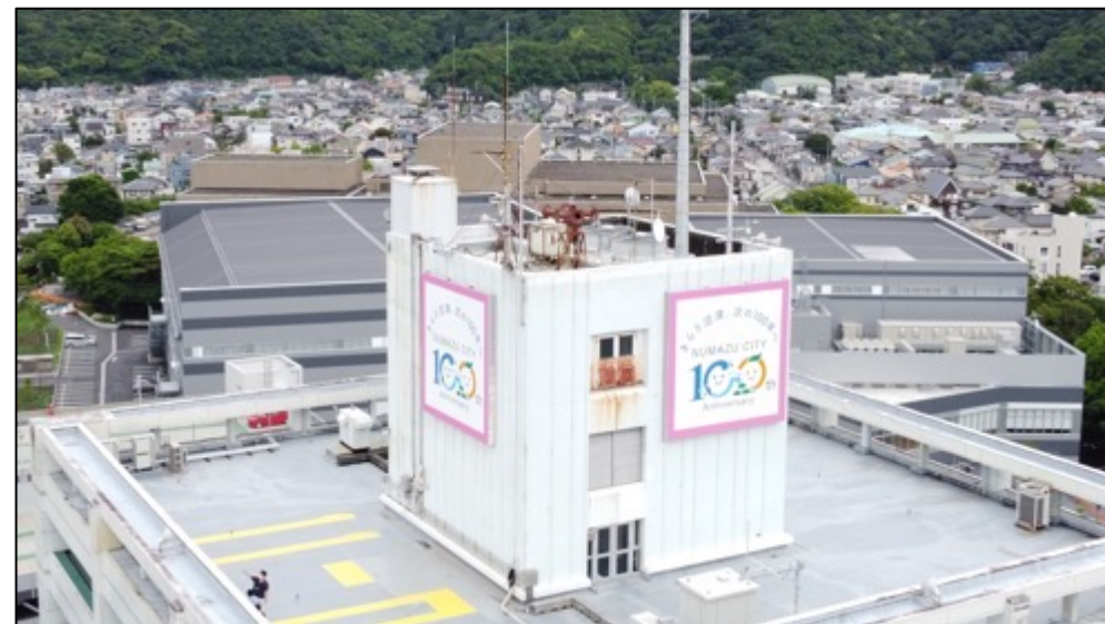
【沼津市役所屋上の大型看板の様子】
