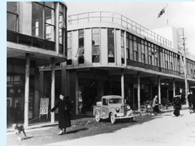
全国で初めてつくられたアーケード街。昭和30年頃
