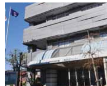
津波避難ビル(第四地区センター)
