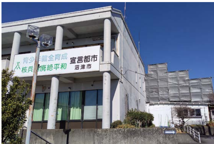
現地区センター 旧館解体工事始まる 1月14日
