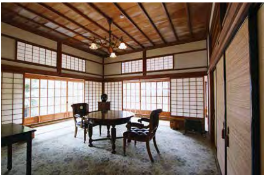
西附属邸 御食堂 壁と襖は間似合紙(和紙)張り 障子は手漉き和紙 棧と棧の間に細い継ぎ目がある
