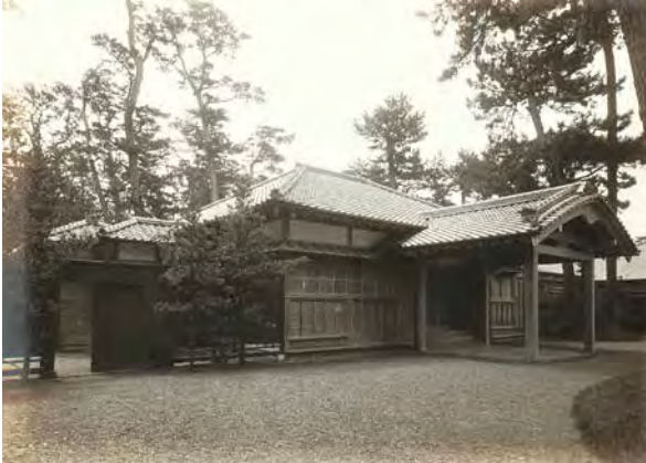
6 御車寄と玄関部分
