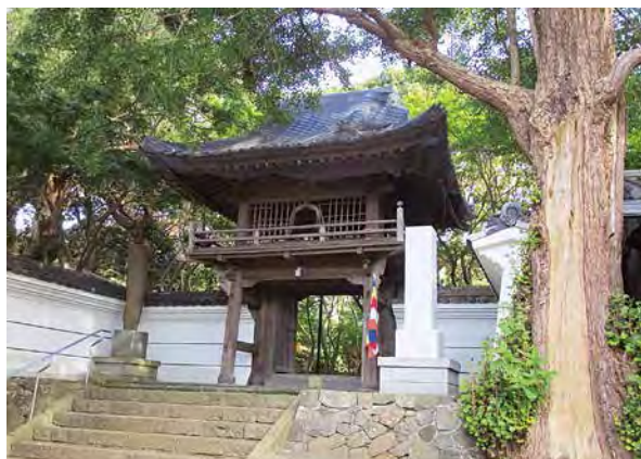
大中寺 鐘楼門 天保12年(1841) 建築
