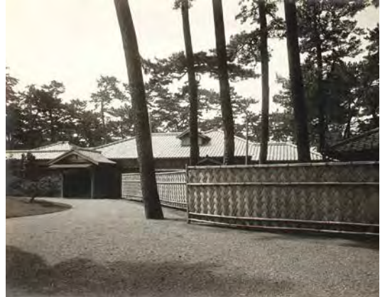
東附属邸御殿臣下昇降口付近の沼津垣 (宮内庁書陵部所蔵)
