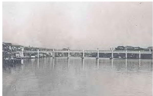
大正15年、鉄筋コンクリート製の橋に架け替え後の永代橋(*14)
