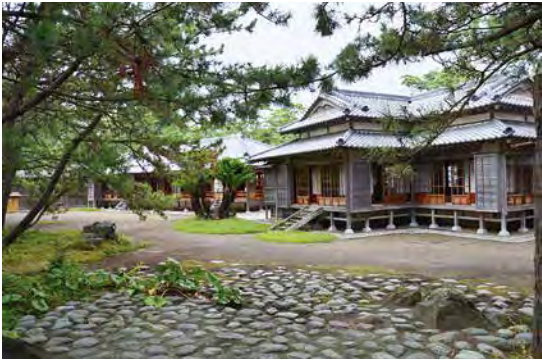
西附属邸 入母屋造り棧瓦葺きに下屋が回っている
