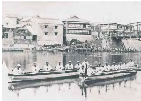
狩野川右岸の御成橋付近（大正6年頃）(*13)
