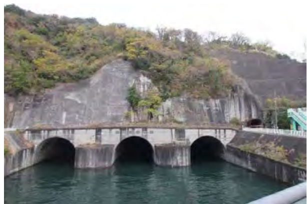
狩野川放水路(口野トンネル)
