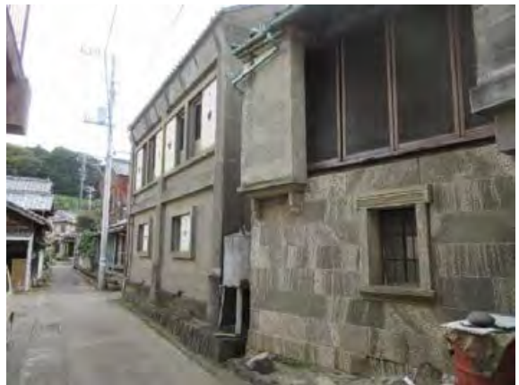
西浦久連の伊豆石建造物群
