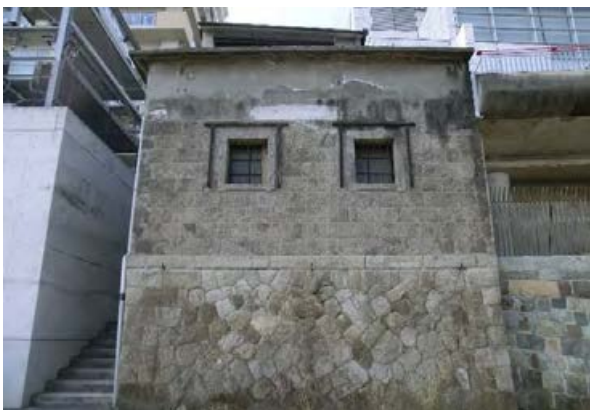
伊豆石建造物（福島屋石蔵）
