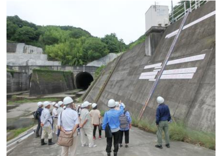
狩野川放水路
