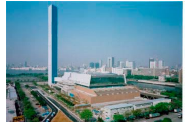
中央区清掃工場
