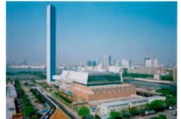
中央区清掃工場
