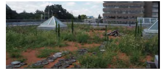
武蔵野クリーンセンター
