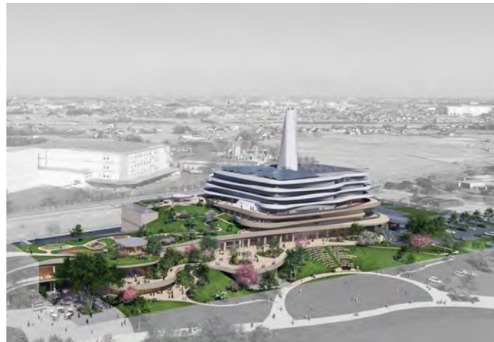
久喜市ごみ焼却施設
