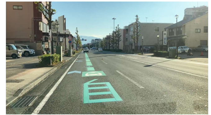
②自動運転車両アイコン標示 交差点付近に上下線計8箇所整備
