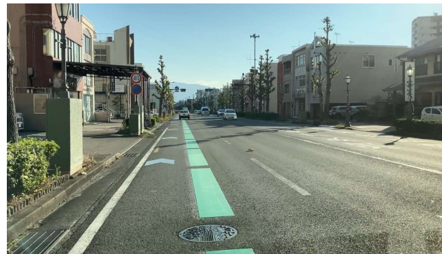
①走行レーン標示 グリーンカラーの幅45cmの破線を整備
