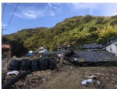
土砂災害で崩壊した住宅
