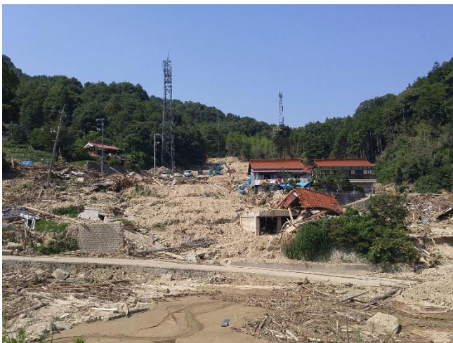
中畑地区：土砂は野呂川まで続き、集落を破壊した
