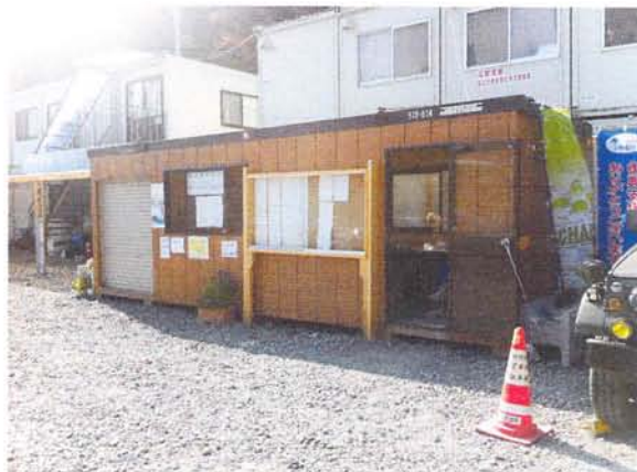
総合受付業務を行った仮設建物
