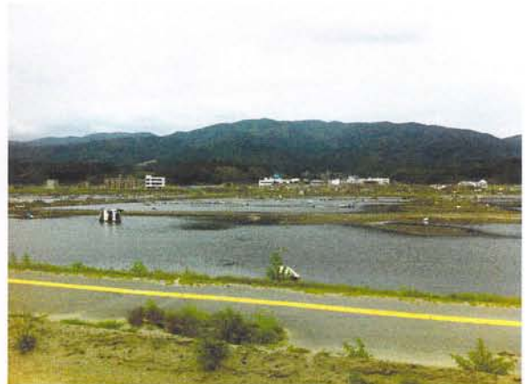
水が引かなくなった平地（陸前高田市）
