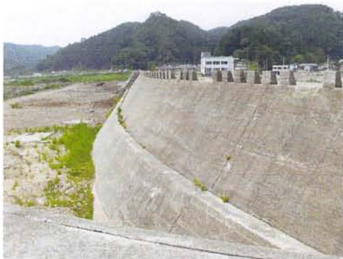
宮古市田老地区の巨大な堤防
