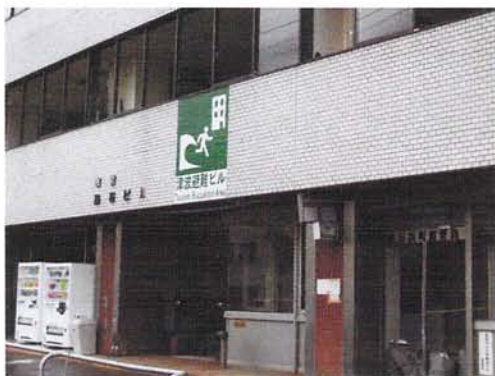
津波避難ビル（釜石市）
