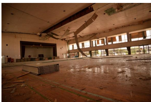
写真 4 益城町民体育館
