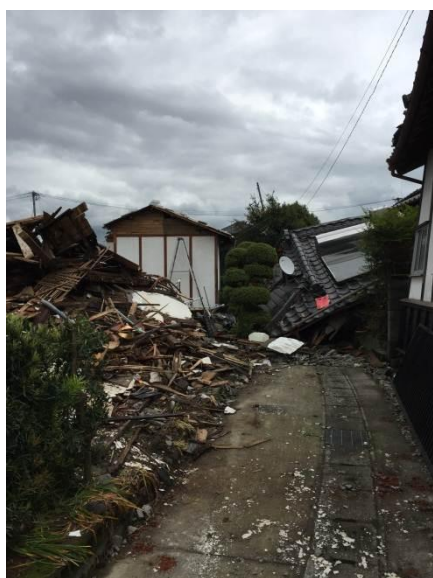
倒壊し道路を閉塞している家屋
