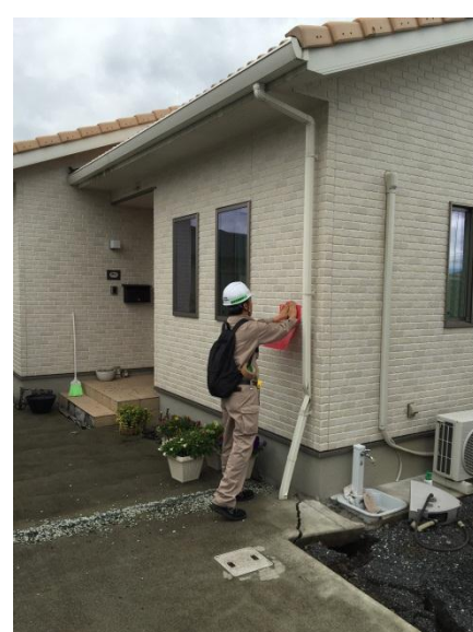
判定の様子(危険の判定)
