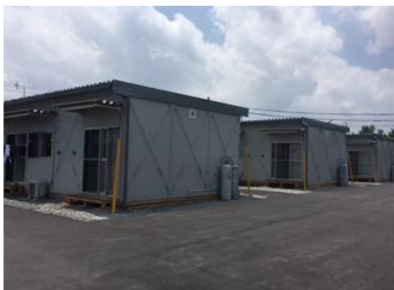
応急仮設団地(1)
