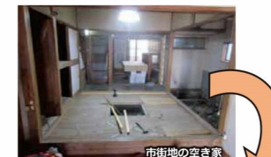
市街地の空き家
