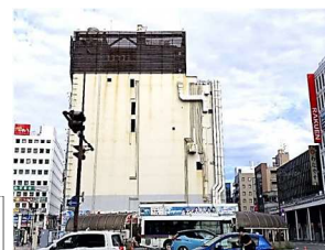
沼津駅前の大きな壁面
