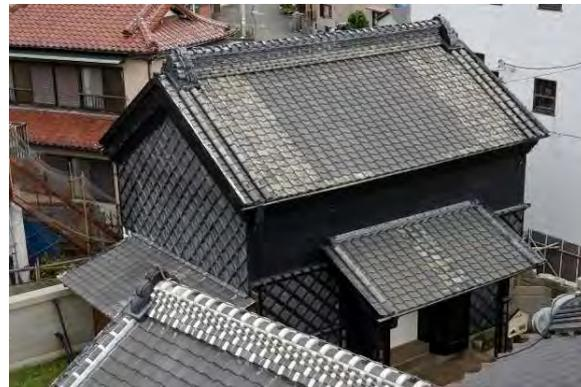
東組47 大屋根及び出入口土庇屋根施工完了
