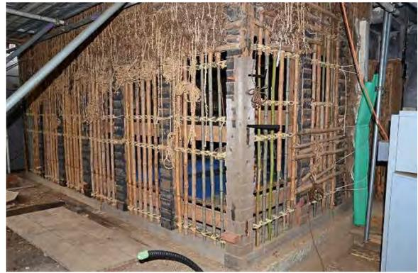
東組4 土台補修（一部取替）、柱高根継完了
