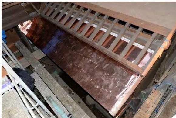
文組29 銅板葺下屋銅板葺施工完了
