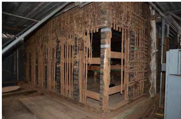
東解34 下段荒壁土解体完了（北西より見る）
