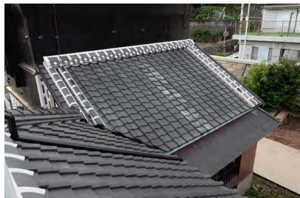
文組30 蔵前・銅板葺下屋 屋根施工完了
