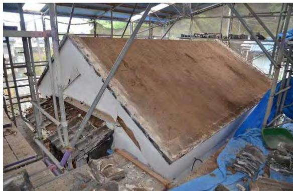
文解11 大屋根椽瓦葺土撤去状況（南東より見る）
