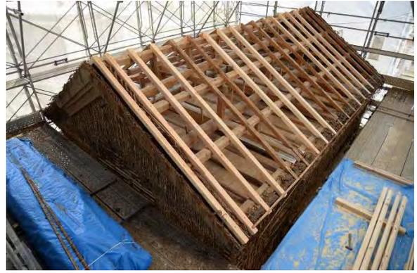
東組12 大屋根垂木補修完了（北西より見る）
