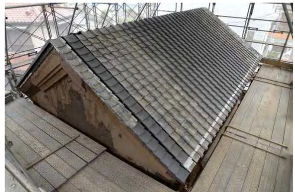
東組16 大屋根棧瓦平葺完了（北西より見る）
