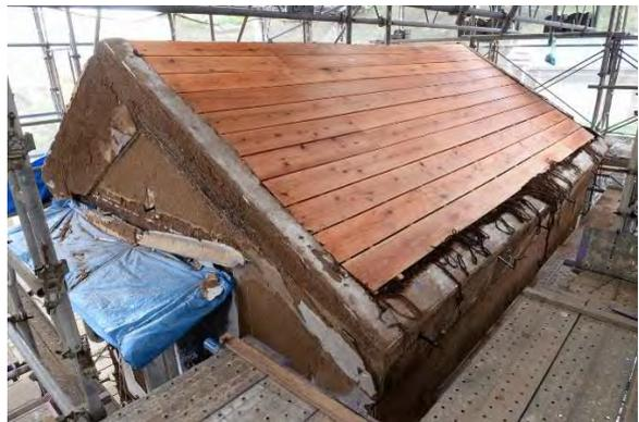
文組14 大屋根二重野地施工完了 (南東より見る)
