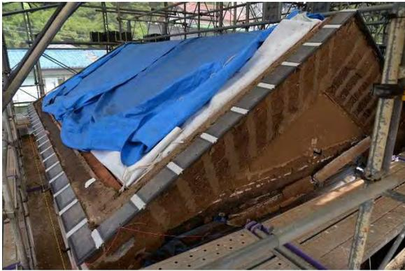
文組17 大屋根軒先・蝶羽敷瓦施工完了
