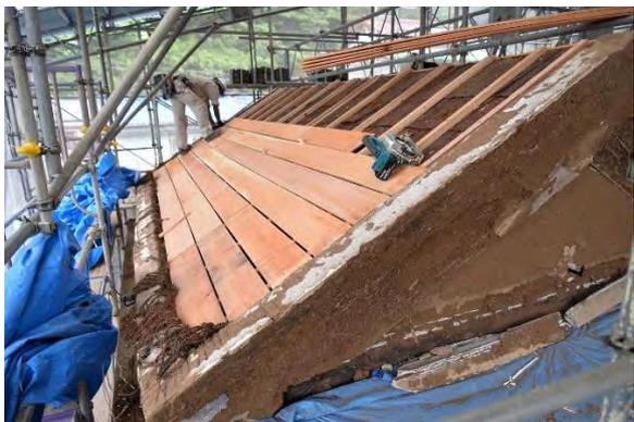
文組13 大屋根二重野地施工状況 (南西より見る)
