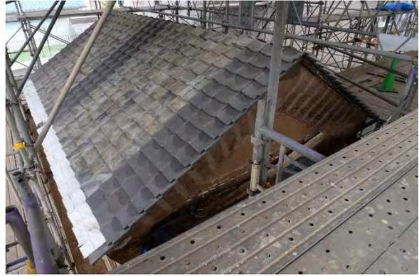
文組18 大屋根根椽瓦平葺完了
