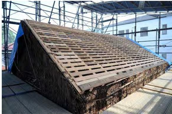
東組13 大屋根小舞野地施工完了（北西より見る）
