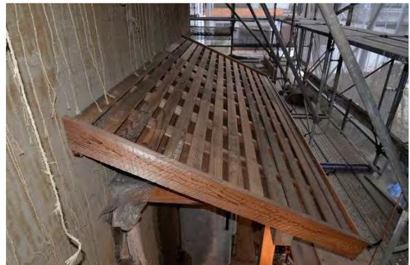
東組25 西面出入口土庇 小舞野地施工完了
