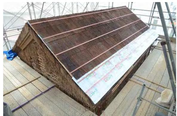
東組14 大屋根下地葺完了（北西より見る）
