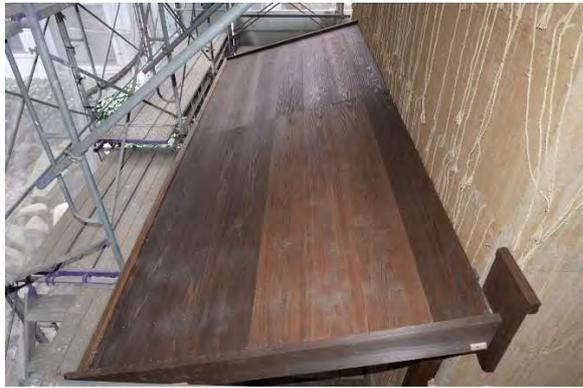
東組26 北面下屋 野地板施工完了
