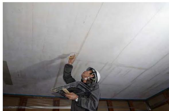
東組33 2階天井漆喰塗 亀裂部補修状況
