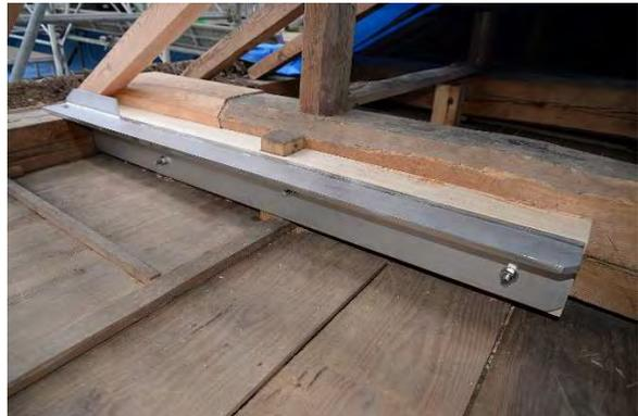
文組10 小屋梁補修及びステンレスアングル鋼材補強完了
