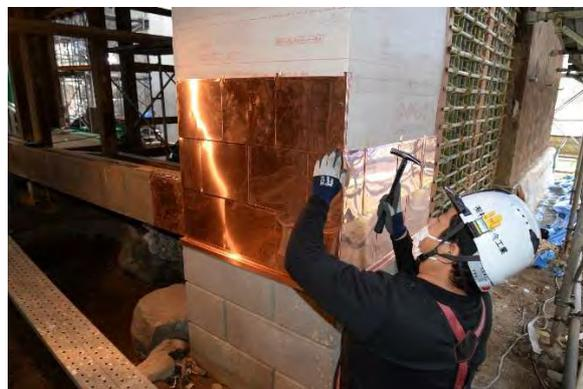
文組47 同左壁 銅板包み施工状況
