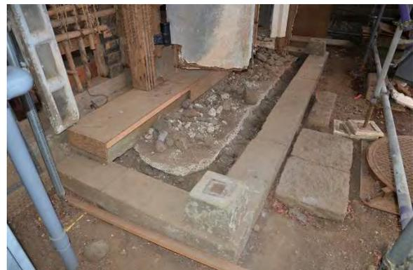
東組6 西面出入口 沓石、縁石 据直し完了
