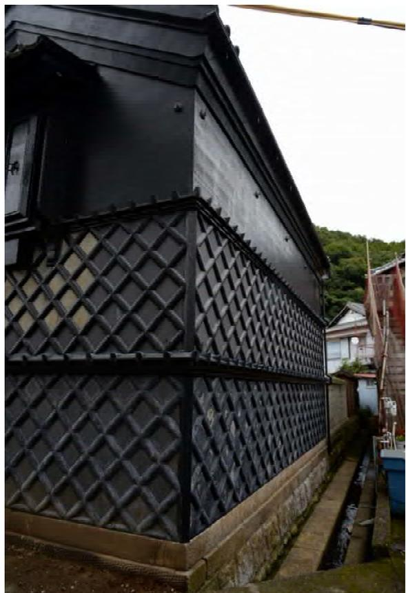
東組49 東面外壁左官仕上げ施工状況
