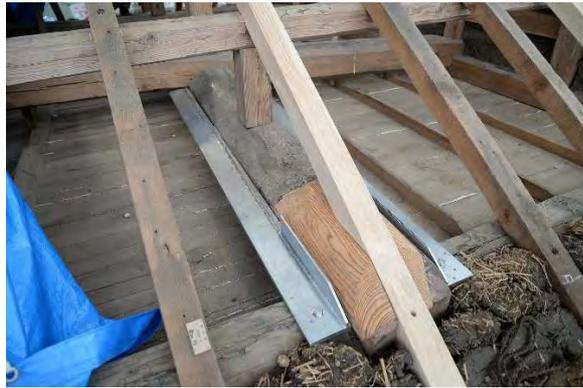
東組11 小屋梁補修及び補強完了
