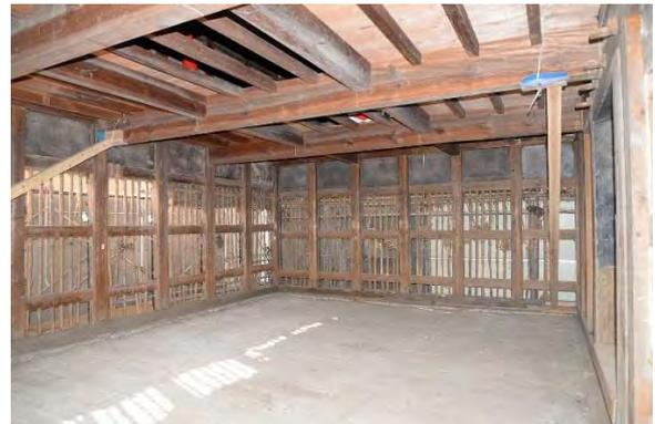
東解35 下段荒壁土・置床解体完了（北西より見る）
