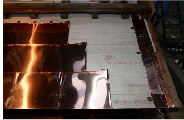
文組28 銅板葺下屋銅板葺施工状況
