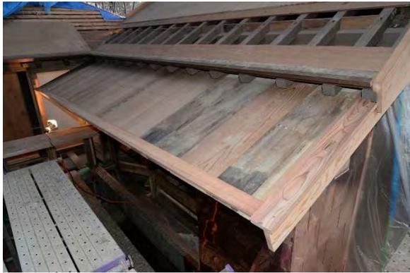
文組27 銅板葺下屋野地板補修完了
