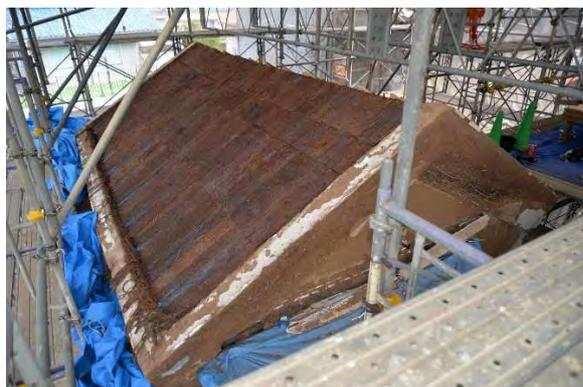
文組15 大屋根杉皮下地葺施工完了
