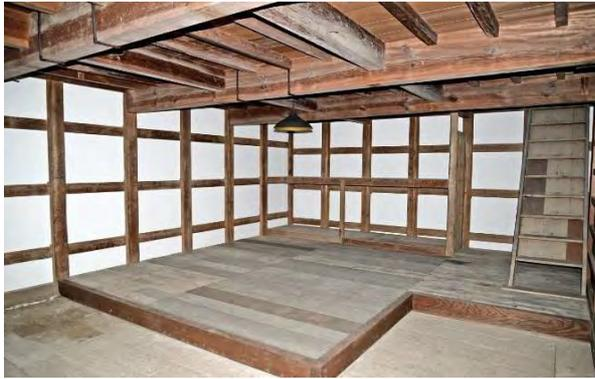
東組9 1階置床・造作組立完了（北西より見る）
