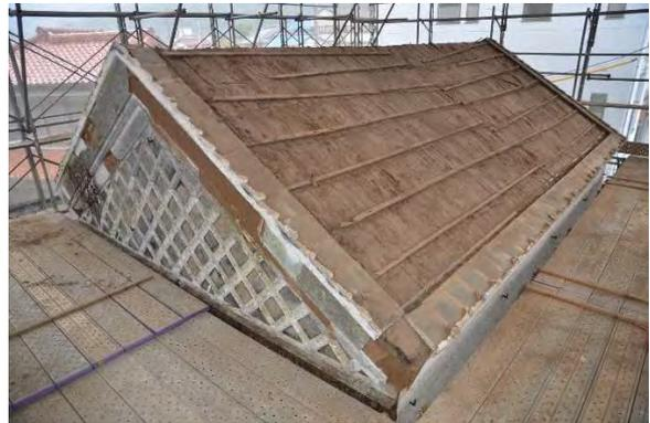
東解6 大屋根棧瓦解体完了、軒先台瓦状況
