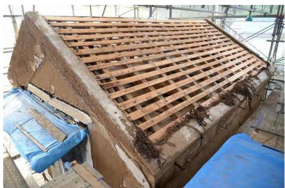
文組12 大屋根小舞野地施工完了 (南東より見る)
