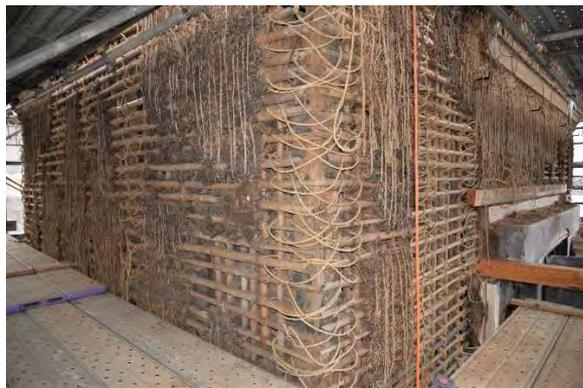
東組28 外壁中段木舞掻き補修完了
