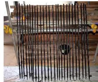
文組42 鉄筋格子防錆黒色塗装完了
