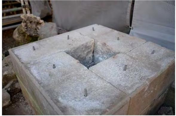
文組2 基壇組立状況（ステンレスダボピン補強）
