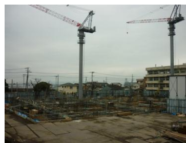
順調に進む新校舎の建設工事 （平成25年3月現在の状況）
