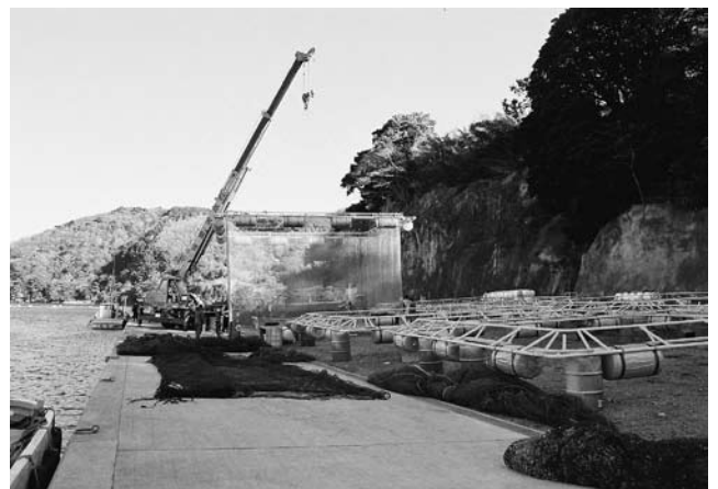
写真2：クレーンで吊り上げられた金網の生簀
