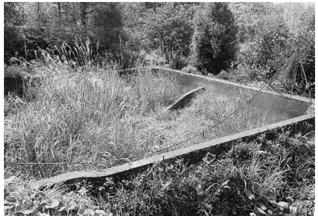
長浜水揚場に残る農業用水の水槽 (コンクリート製、10メートル四方ほどで、深さは2メートル近い。)
