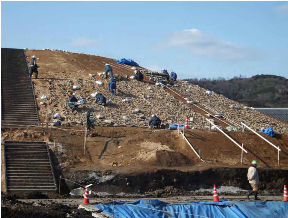
図9 墳丘への葺石施工状況〔大垣市教育委員会提供〕
