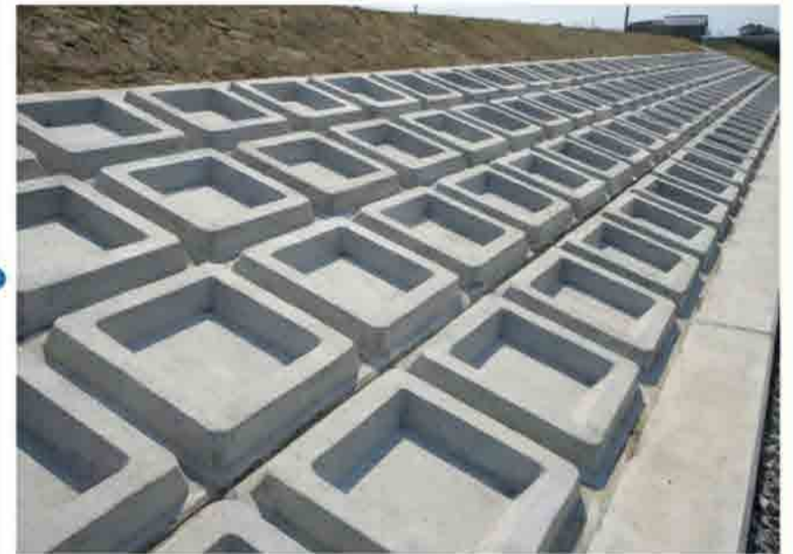
現代：コンクリート護岸 (Concrete Revetment)
