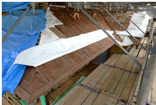
写真 3-2-6-1 土居葺と防水紙施工状況(主屋南下屋南東より)
