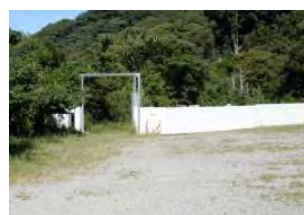
仮囲い・パネルゲート
