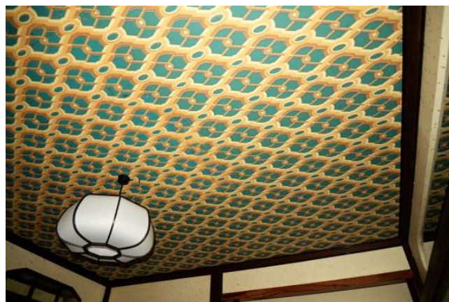
写真3-2-12-2 張り直し状況（左手前1/3ほどが古材）
