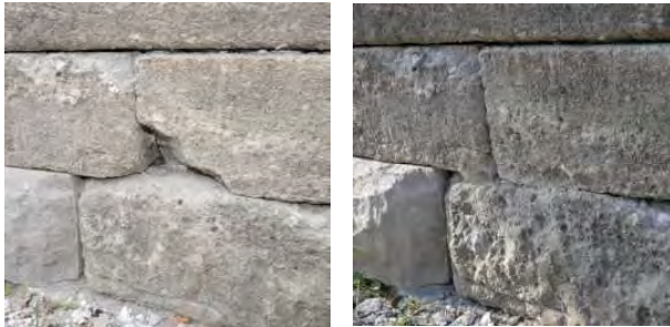
写真 3-2-14-2 表面肉盛補修 補修前（左）と補修後（右）
