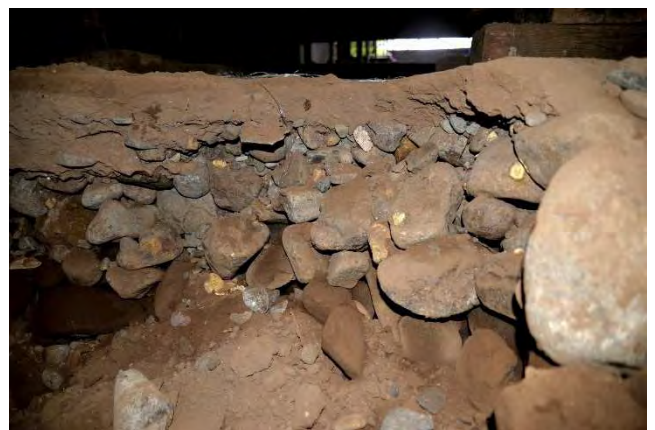
写真 3-4-1-3 主屋中央押入下地業断面
