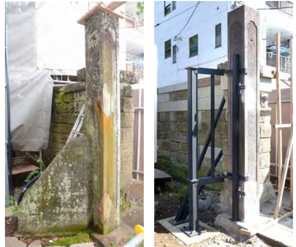
写真 3-2-14-3 門柱 修理前（左）と扉吊り柱設置後（右）
