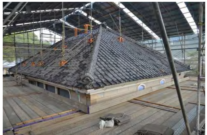
写真 3-2-2-2 主屋素屋根内部（主屋北西より）
