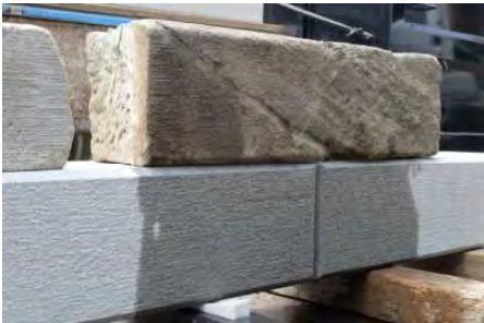
写真3-2-14-1 壁石旧材(上)と新材(下)仕上加工確認状況
