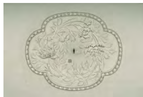
⑥完了（修理後）
