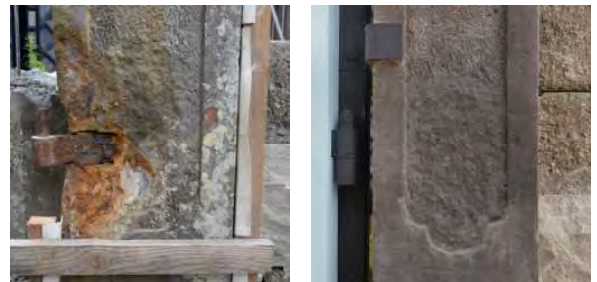
写真 3-2-14-4 門柱肘坪金具 取り外し前（左）と取り外し、肉盛り補修後（右）
