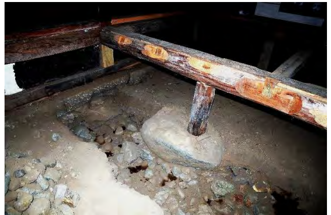
写真 3-4-1-2 主屋オクナンド下玉石地業 柱礎石下以外の周辺部にも及ぶ。主屋に限らず今回掘削した箇所では全て同様な地業を確認した。
