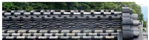
写真 3-2-13-2 大棟避雷導体取付仕様（東土蔵）
