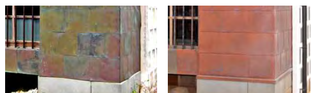
（修理前） （修理後） 写真 3-2-13-1 文庫蔵銅板葺下屋壁銅板包みの仕様
