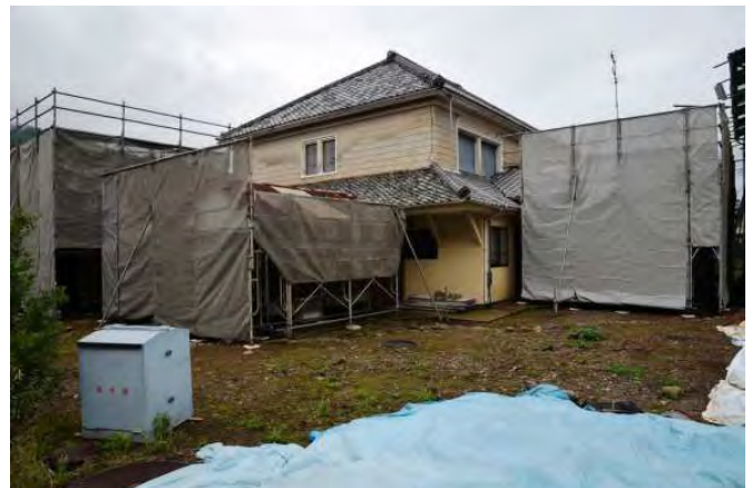
写真 3-2-2-1 先行解体工事足場（主屋北東より）
