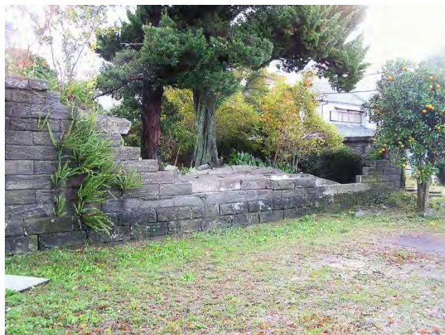
写真 3-4-2-3 平成 16 年台風による西側石塀の倒壊
