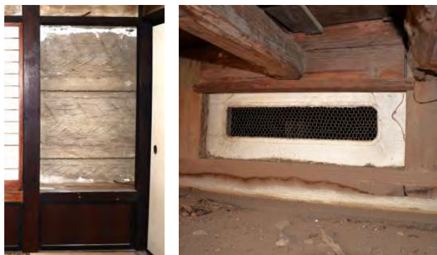
次の間 開閉式戸袋内部 北縁床下通気口金網散り廻り
