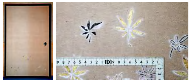
写真 4-4-5-17 主屋北西十畳間葛布襖[77]と置上げ絵様（修理前） 襖は表裏で意匠をシダ植物型刷りと分けている。蛍光 X 線分析の結果より、青金ほどではないが金箔には銀を含む。銀箔も用いているが黒変？。墨差しも併用か。（前出シダ植物絵様とは表裏関係）
