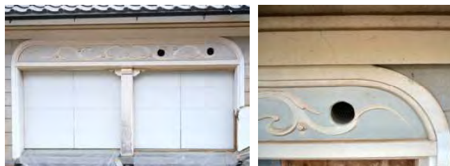
写真 4-4-4-12 2階北面東半額縁蛇腹窓と唐草レリーフ（工事中）
