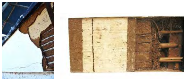
文庫蔵西面軒付 文庫蔵蔵前北面腰上塗り層構成 写真 4-4-4-33 生漆喰・土を混ぜた砂摺層（刷毛引き）
