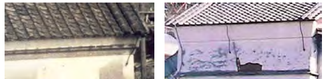
東土蔵西面（古写真6切抜） 文庫蔵西面（古写真61切抜） 写真 4-4-11-1 古写真に見られる軒樋受け金具（長首式）
