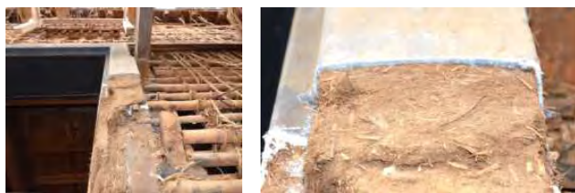
写真 4-4-4-32 緩やかな膨らみをもつ北土蔵出入口枠の仕上げ
