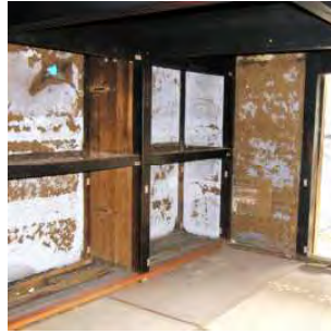
同左室内壁と押入壁の違い
