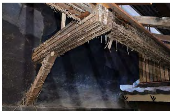
写真 4-4-4-2 1階東下屋揚げ裏下地（解体中）
