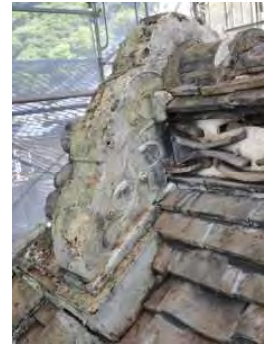
大棟胴塗り等 写真 4-4-4-29 海鼠瓦張り付け施工
