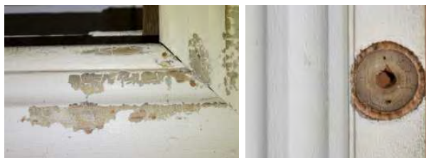
南西八畳間 西面窓額縁 2階南廊下西奥扉 ノブ下 写真 4-4-7-9 その他部位に残る主屋当初黄土色ペンキ
