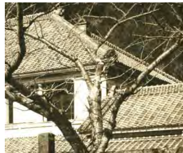
写真 4-4-3-7 明治末～大正主屋、 ミセ目地漆喰状況（古写真2切抜）
