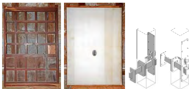
腰板張格子戸（外面） 土戸（外面） 連結金具（2壺） 写真4-4-5-7 文庫蔵出入口建具（工事中）
