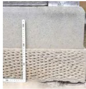
上段：水磨き 下段：トンボつつき (主屋ヒロマ南縁)
