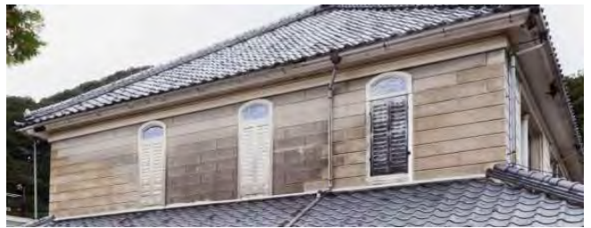
写真 4-4-4-9 2階西面窓廻り（修理前）
