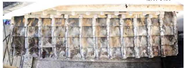
写真 4-4-3-6 文庫蔵南庇 修理前目地漆喰状況
