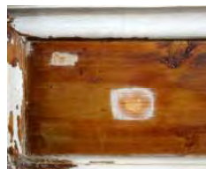
北廊下東端 同左板鴨居当初ペンキと後補ニス 同左腰板断紋 写真 4-4-7-7 主屋2階廊下廻りペンキ塗り (工事中)
