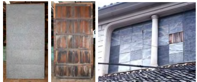
修理前外面 同内面 昭和59年（古写真32切抜） 写真4-4-5-2 主屋2階南面雨戸（1726×868×40）
