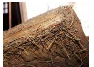
写真4-4-6-22 ミセ2階縁無し（琉球）表端部拡大
