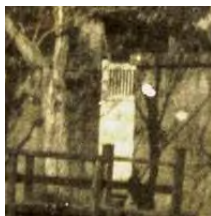
正面門柱開戸 (古写真5切抜)
