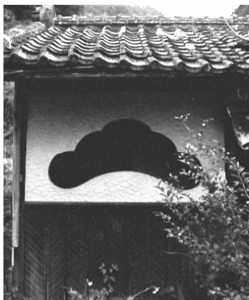
南面松葉形剝抜窓と鰻波調仕上
