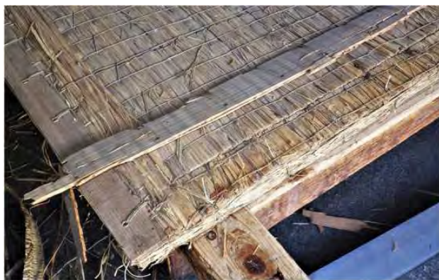
写真 4-4-6-6 手縫い床の四方板（破損の酷いもののみ取替）
