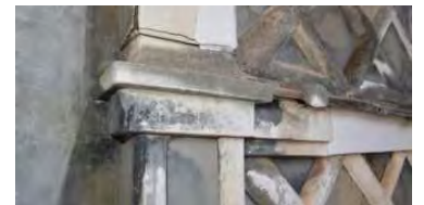
東土蔵西面柱形（水切り補修あり）
