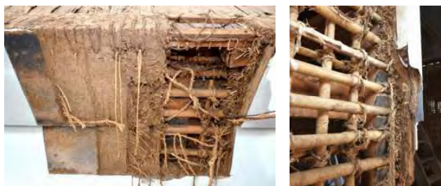
南面軒廻り塗り層構成 写真 4-4-4-34 北土蔵塗り・下地構成
