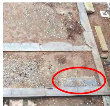
写真 4-4-1-4 ミセ当初叩き（後補コンクリート叩き撤去後）
