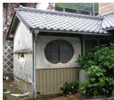
南西全景 腰上・窓廻り当初壁
