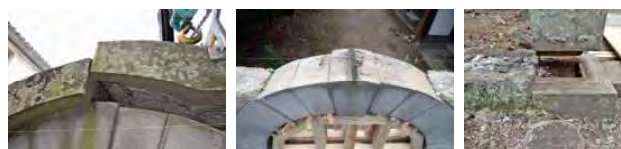
笠石と迫石取合い 同左調整銅板・鉄錠 アーチ柱石短柄 写真 4-4-12-7 庭塀アーチの組積工法（解体中）
