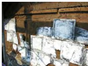
石積風目地入壁の下地瓦張り
