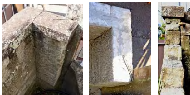
笠石と門柱取合い 壁石と門柱取合い 壁石合端盗み仕事 写真 4-4-12-6 当初石材の組積工法（解体中）
