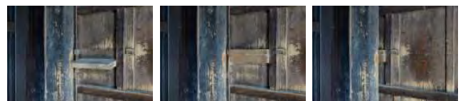
施錠時 解錠中 建具開閉 写真4-4-5-3 南東ドマ東面外部出入口板戸[5]の内締りカギ 堅框と堅棧の間に入れた軸摺のつっぱりを柱に当てて建具の引込みを止める原理であるが、開ける時はつっぱりを建具構内内にたたみ、栓を押し込んで固定する。
