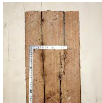
化粧側天井板と砂漆喰の付着面
