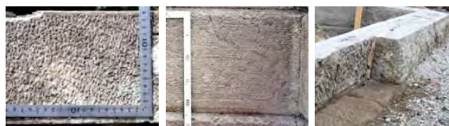
笠石目細つつき サシバ叩き 外側割肌瘤出し？ 写真 4-4-12-5 当初石材の表面加工（解体中）
