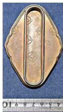
写真 4-4-8-7 引手F…飾金具 (10) (解体中)
