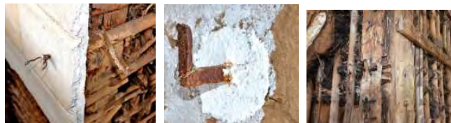
主屋2階壁面北東隅 化粧折釘と銅線 文庫蔵北面壁西端 化粧折釘と銅線 北土蔵南面東端張付柱 折釘打込用（壁埋込）
