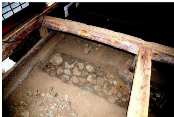
写真4-4-1-2 主屋オザシキ基礎下発掘確認
