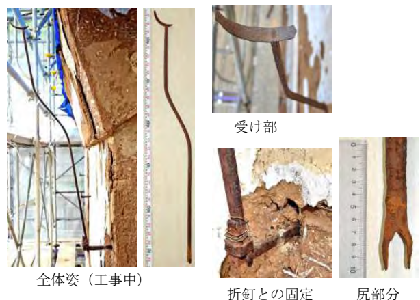
写真 4-4-11-2 残存する唯一の長首式軒樋受け金具（文庫蔵）
