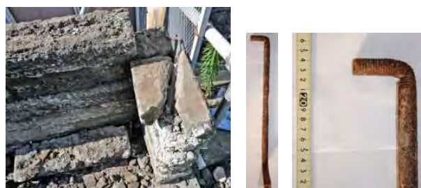
北面東端控壁 手違いに曲げられたアンカー 写真 4-4-12-8 後補石塀工法（解体中）
