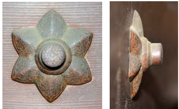
写真 4-4-8-2 六葉 正対/側面（修理前）
