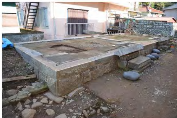
写真4-4-1-6 北土蔵基壇石組と根石確認
