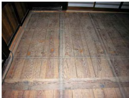
写真4-4-6-1 主屋ナカノマ荒床に残る当初畳割付墨・圧痕
