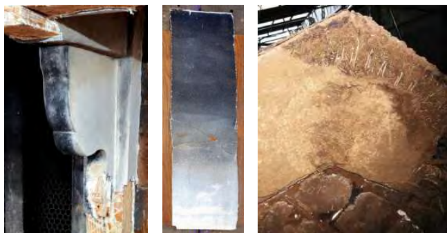
南面 2 階窓廻り下地 黒ノロ風化 東面拝み棕櫚繊維塗り 写真 4-4-4-31 北土蔵大壁・揚げ裏関係当初仕様
