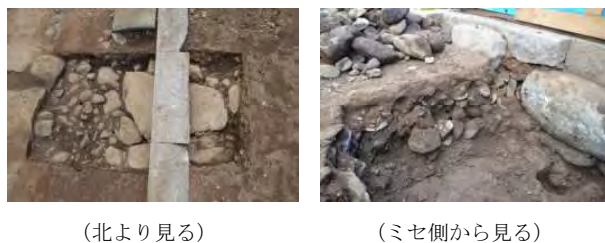
写真4-4-1-1 ミセ・主屋境基礎下発掘確認
