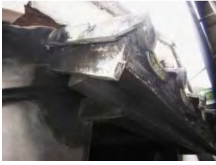
2 階窓底廻り 揚げ裏
