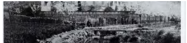
明治期の西石塀～南石塀（古写真1切抜）
