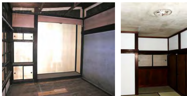
2階南東六畳間（解体中）
