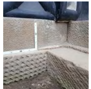
上段：ビシャン 下段：トンボつつき、鑿切り (東土蔵西面出入口北西より)
