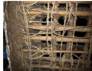
外部側藁縄棕櫚縄掻き付け構成 写真4-4-4-35 北土蔵壁下地
