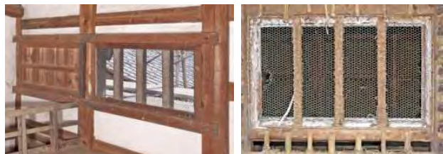
内側窓土戸片引 外側塗り込め部分解体状況 写真4-4-5-6 北土蔵2階窓金網張り（工事中）
