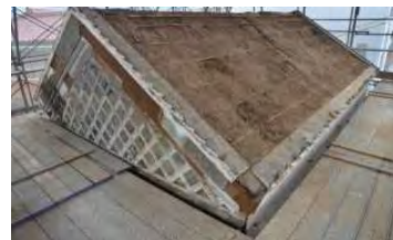
写真 4-4-3-4 東土蔵軒台瓦全景
