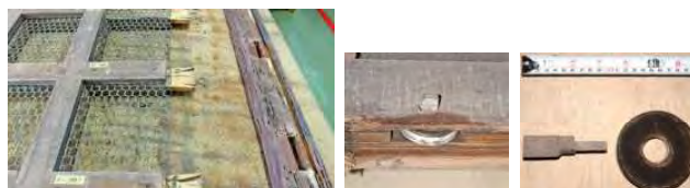
銅線亀甲網取合い 当初戸車 同左詳細 写真4-4-5-9 腰板張格子戸解体状況
