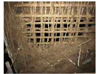
外部側の下地と塗り層
