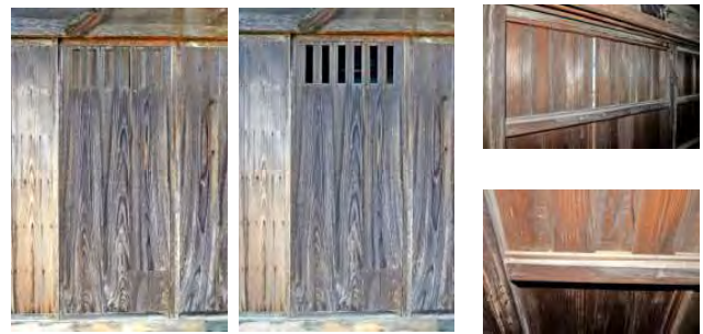
修理前外面 同（無双窓開放） 無双窓部分内面 写真4-4-5-1 主屋1階西面雨戸の改造状況（大正～戦前）
