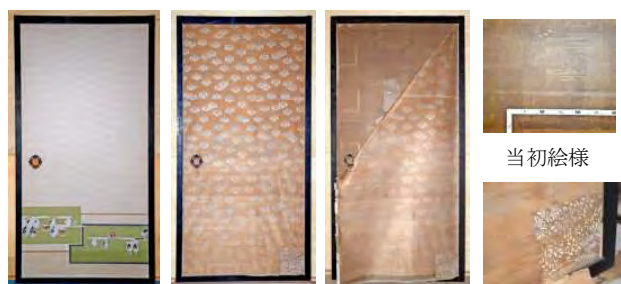
修理前（表層） 中古1（第2層） 中古下の当初紙 中古2（補修） 写真 4-4-5-15 主屋マエナンド押入襖[40]の改造
