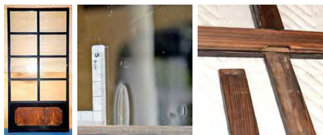
室内側 ガラス気泡詳細 2材構成の縦組子 写真4-4-5-10 主屋2階腰下ガラス戸[64]（修理前）1675×865×30
