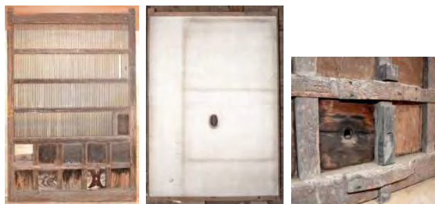
腰板張格子戸（外面） 土戸（外面） 猿落とし（内面） 写真4-4-5-5 北土蔵出入口建具（工事中）
