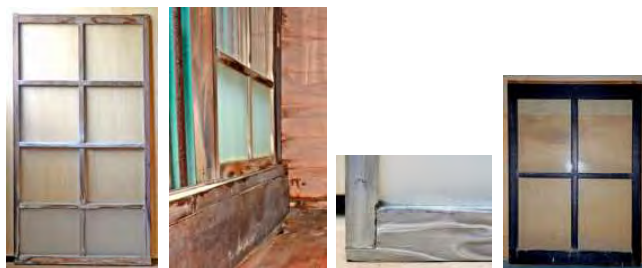
大切縮め 付敷居挿入改造 縦框・摺棧改造 2階南面窓 写真4-4-5-12 銅板葺下屋窓改造と主体部2階窓（右端）（修理前）
