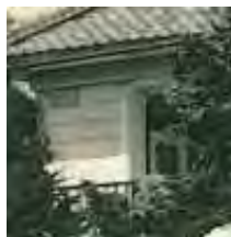
主屋2階南廊下開戸 (古写真9切抜)
