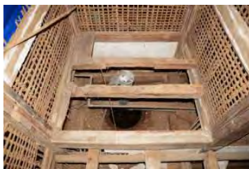
真壁下地・床下砂漆喰壁
