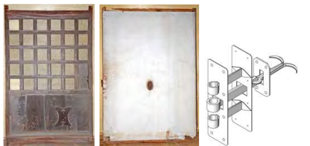
腰板張格子戸（外面） 土戸（外面） 連結金具（3壺） 写真4-4-5-8 東土蔵出入口建具（工事中）
