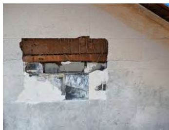
西妻面下地の工法切替
