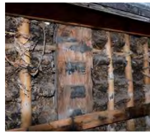
東面外壁改造板張り撤去状況
