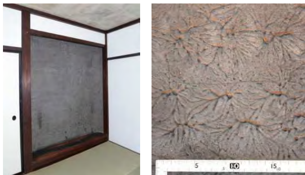
写真 4-4-4-16 2階次の間 室床の変り塗り（工事中）
