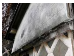
西面妻石積風浅目地入砂漆喰壁
