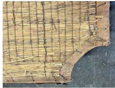
写真4-4-6-7 円柱取合いの四方板納まり
