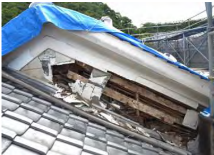
妻面下地状況
