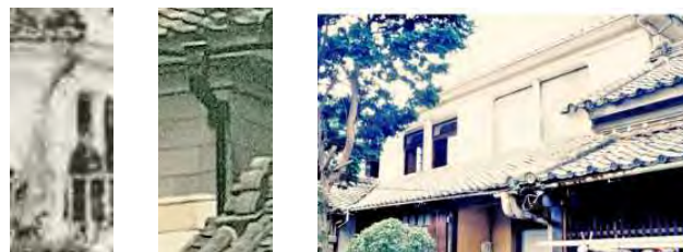
写真4-4-11-4 古写真に見られる堅樋や鯨鯨（海老形・円錐形）
