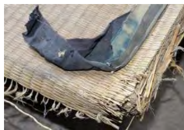
写真4-4-6-21 ミセ2階縁付き表端部処理
