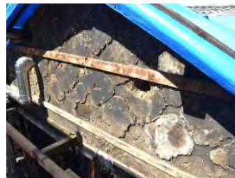
東妻面 当初海鼠壁痕跡
