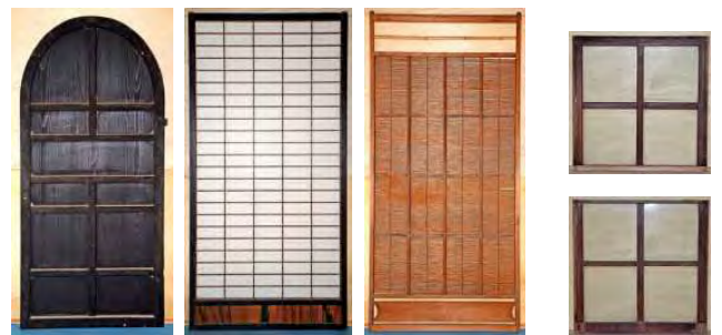
開戸[58] 腰障子[76] 簀戸[96] 上下窓[70] 1642×770×36 1768×860×30 1765×830×28 620×620×26 写真 4-4-5-19 その他建具①（全て主屋、修理前）
