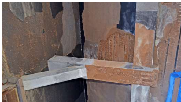
写真 4-4-4-1 1階東下屋揚げ裏（修理前）
