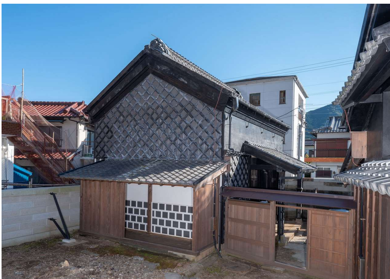
36 側面（北西より見る）
