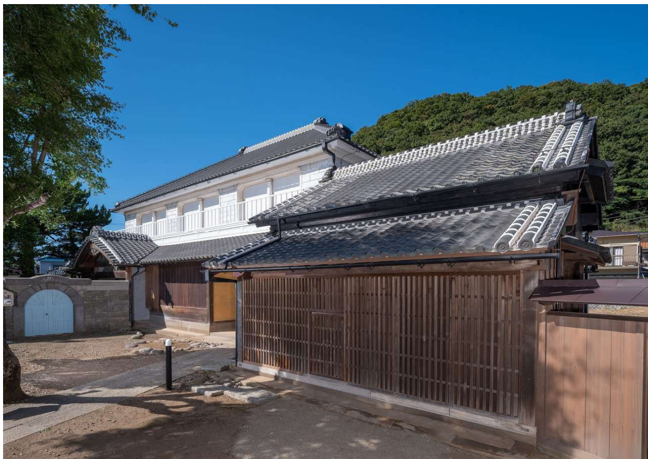
1 正面（南東より見る）
