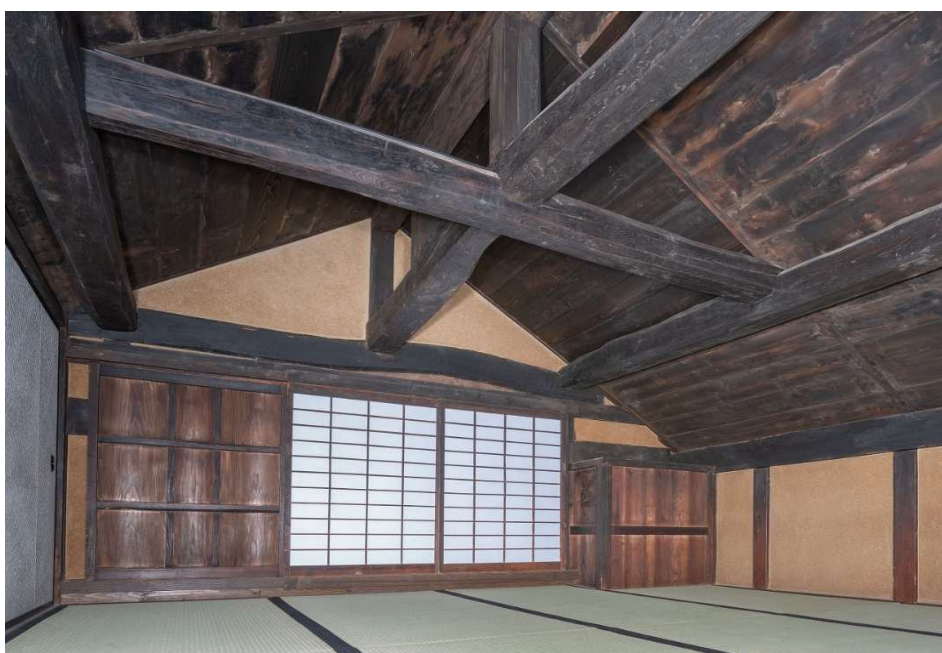
29 2階内部 (北西より見る)
