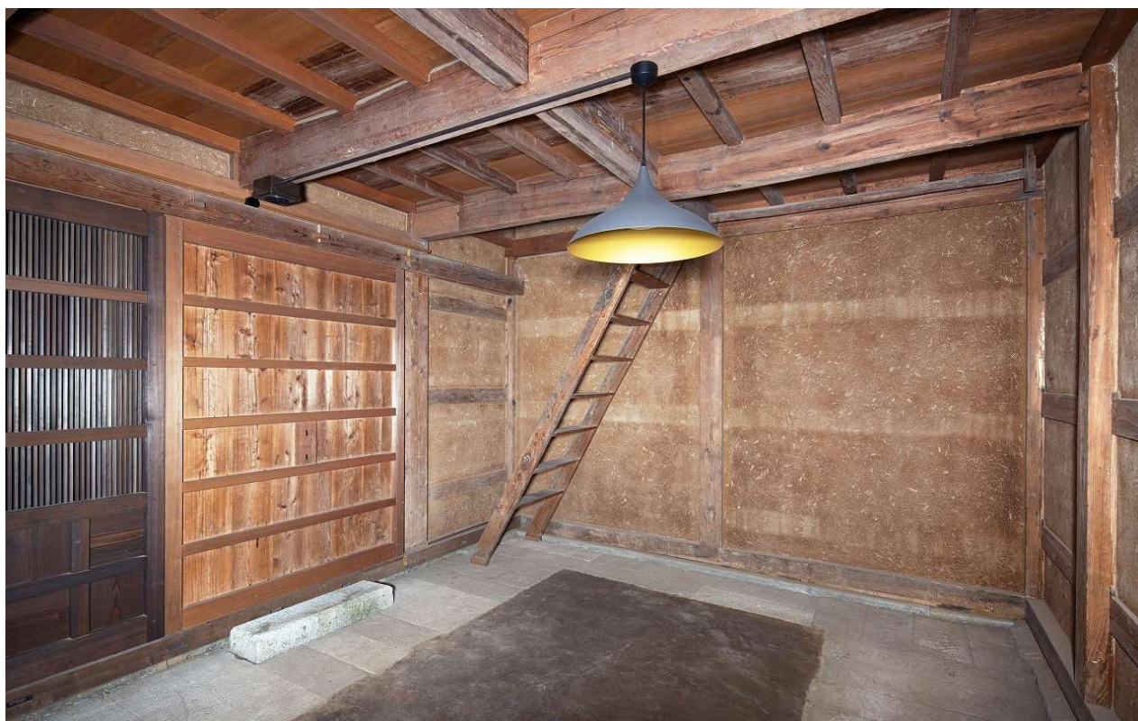
42 1階東室（北東より見る）
