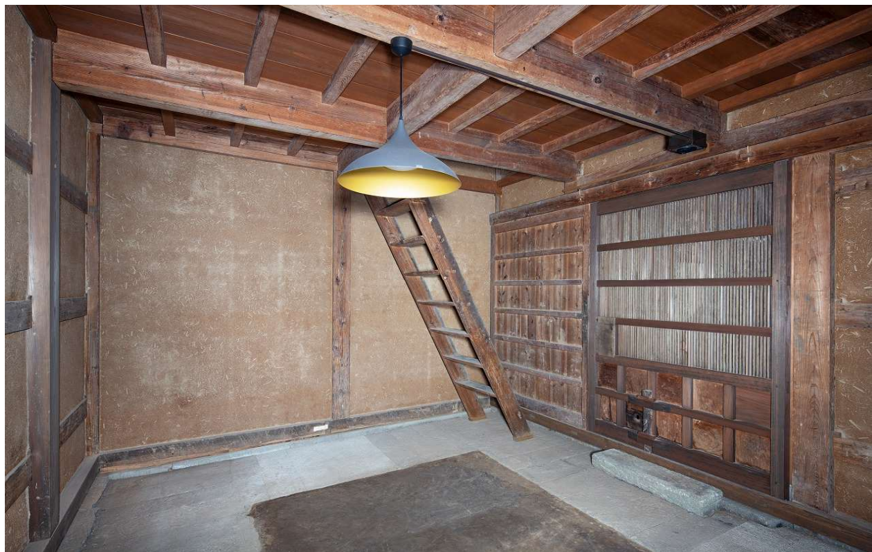
43 1階西室（北西より見る）
