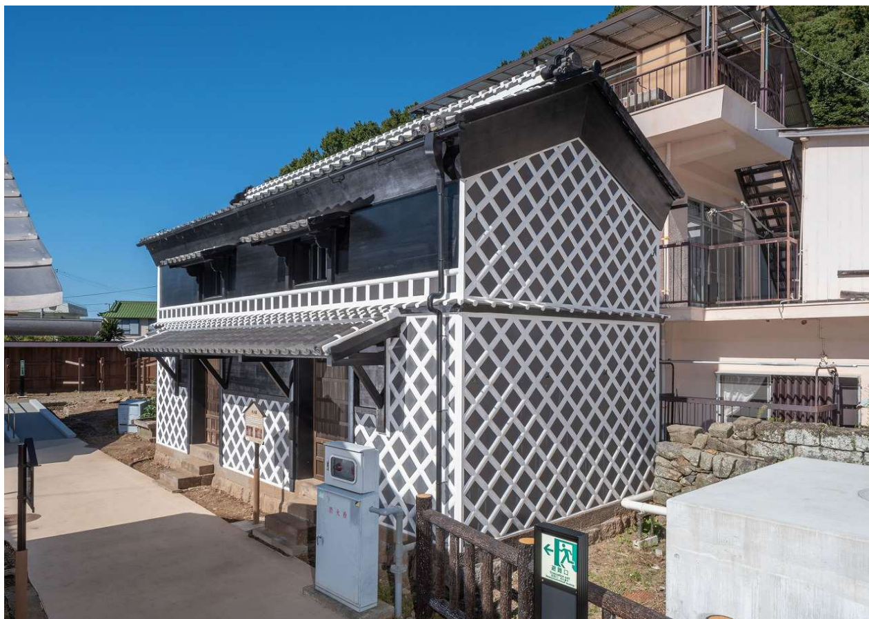
40 正側面（南東より見る）
