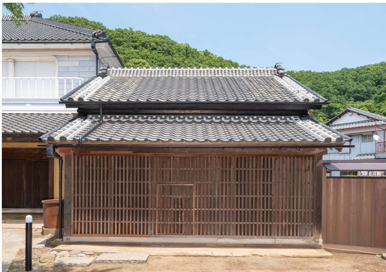
25 正面（南より見る）
