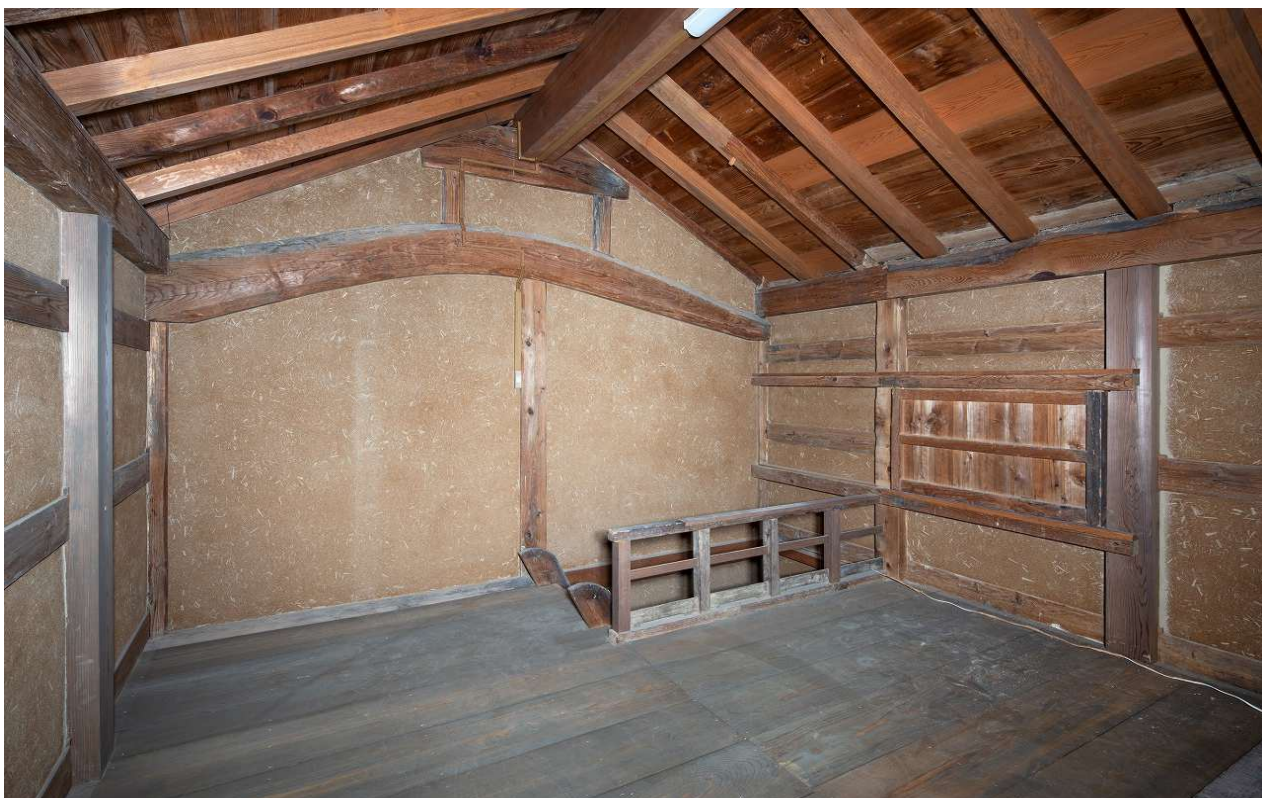
45 2階西室（北西より見る）
