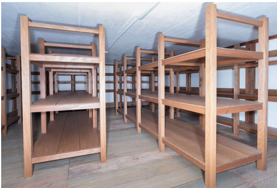
39 2階内部 (南より見る)
