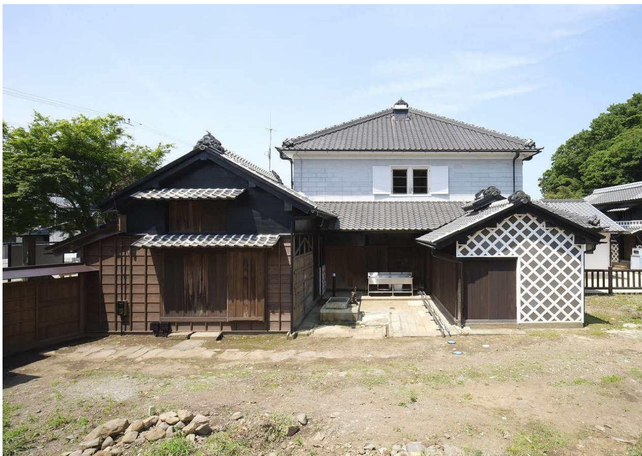
5 東側面（東より見る）
