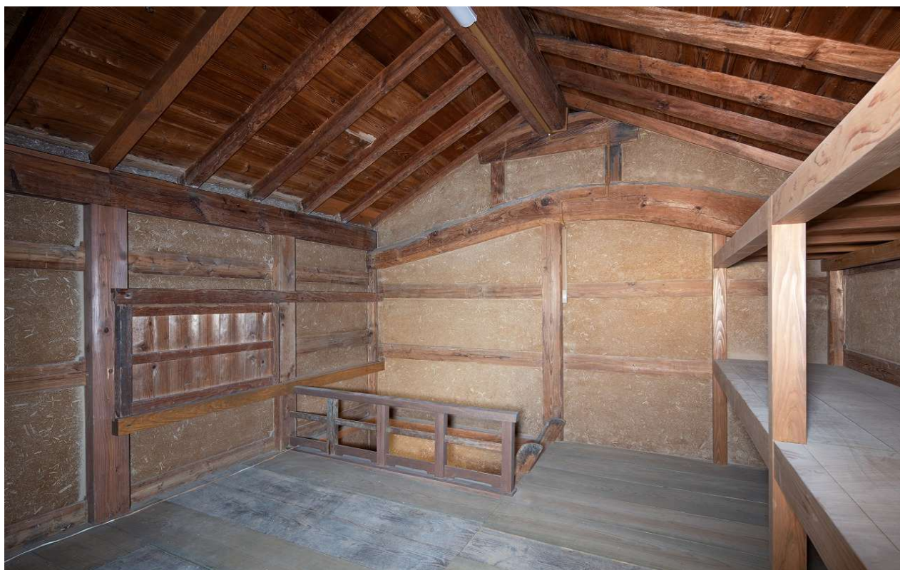
44 2階東室（北東より見る）
