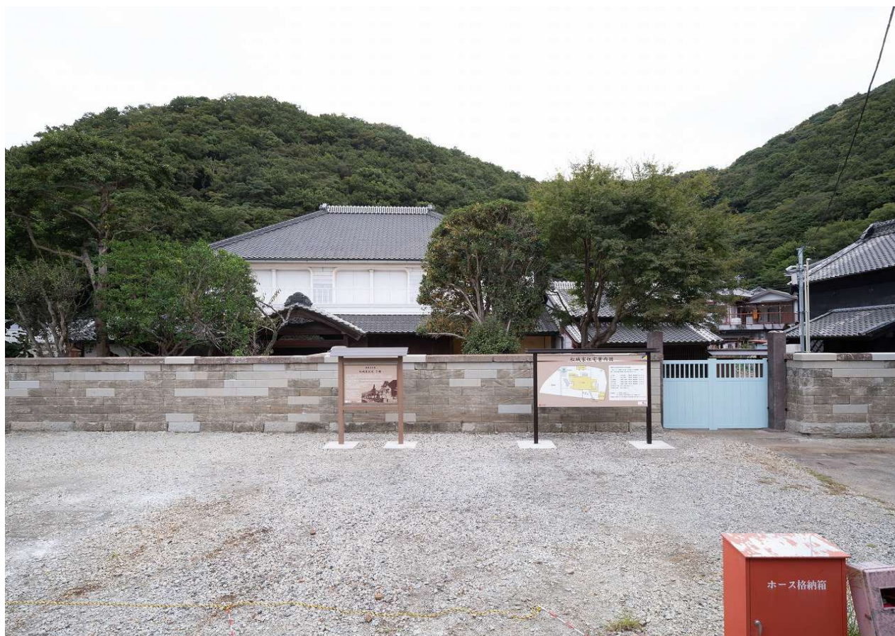
46 正面（南より見る）
