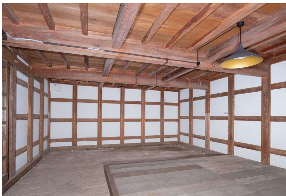
38 1階内部 (南西より見る)
