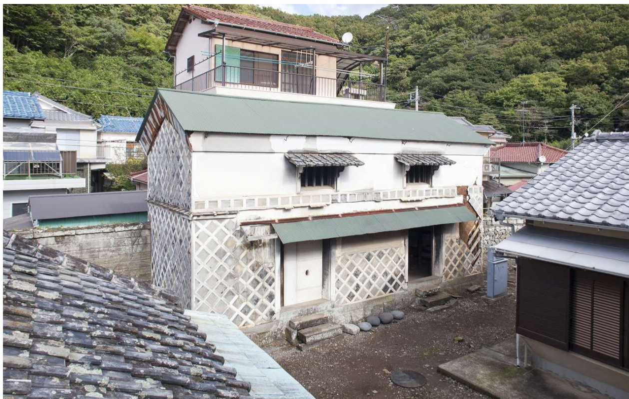
40 正面（南西より見る）
