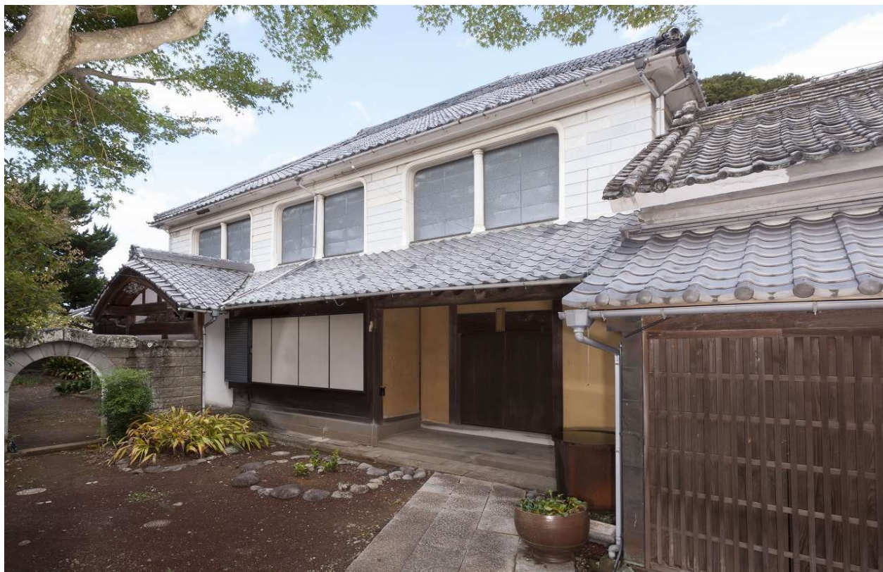
1 正面（南東より見る）
