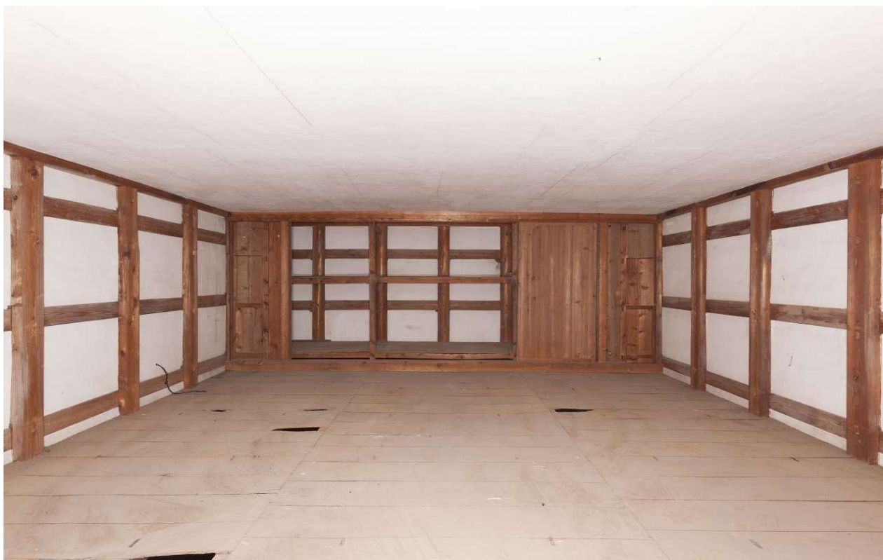
37 2階内部（南より見る）
