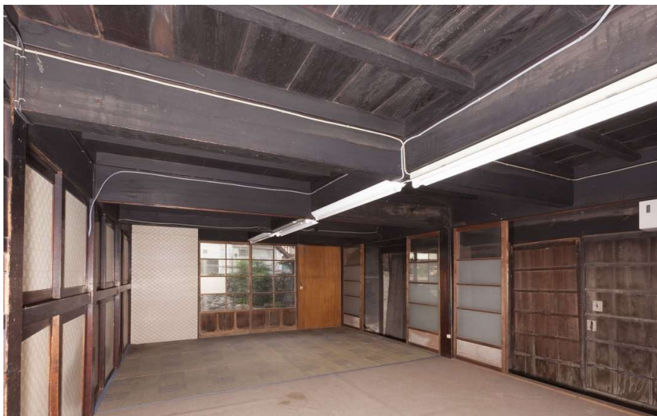
25 1階内部 (北西より見る)
