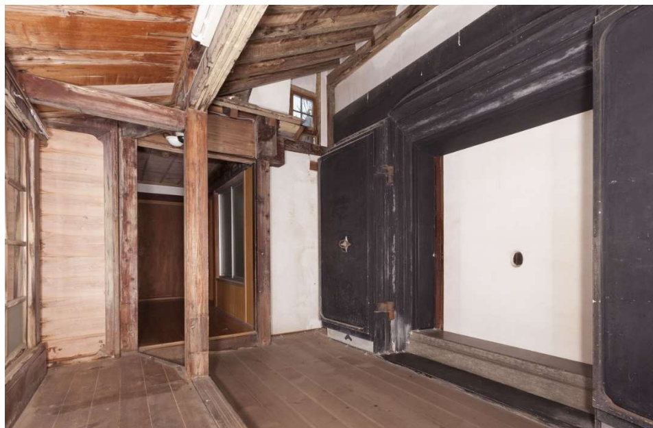
30 蔵前内部 (北東より見る)
