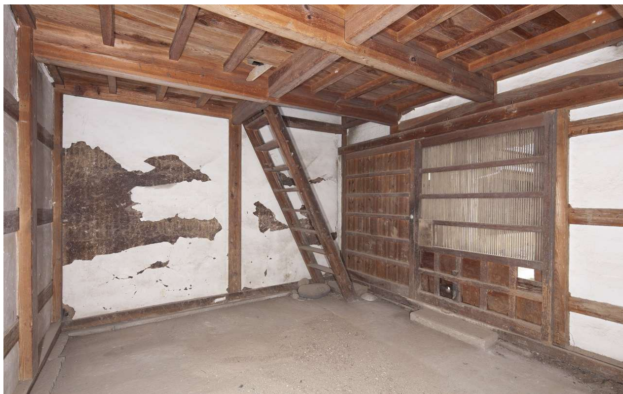
42 1階西室（北西より見る）
