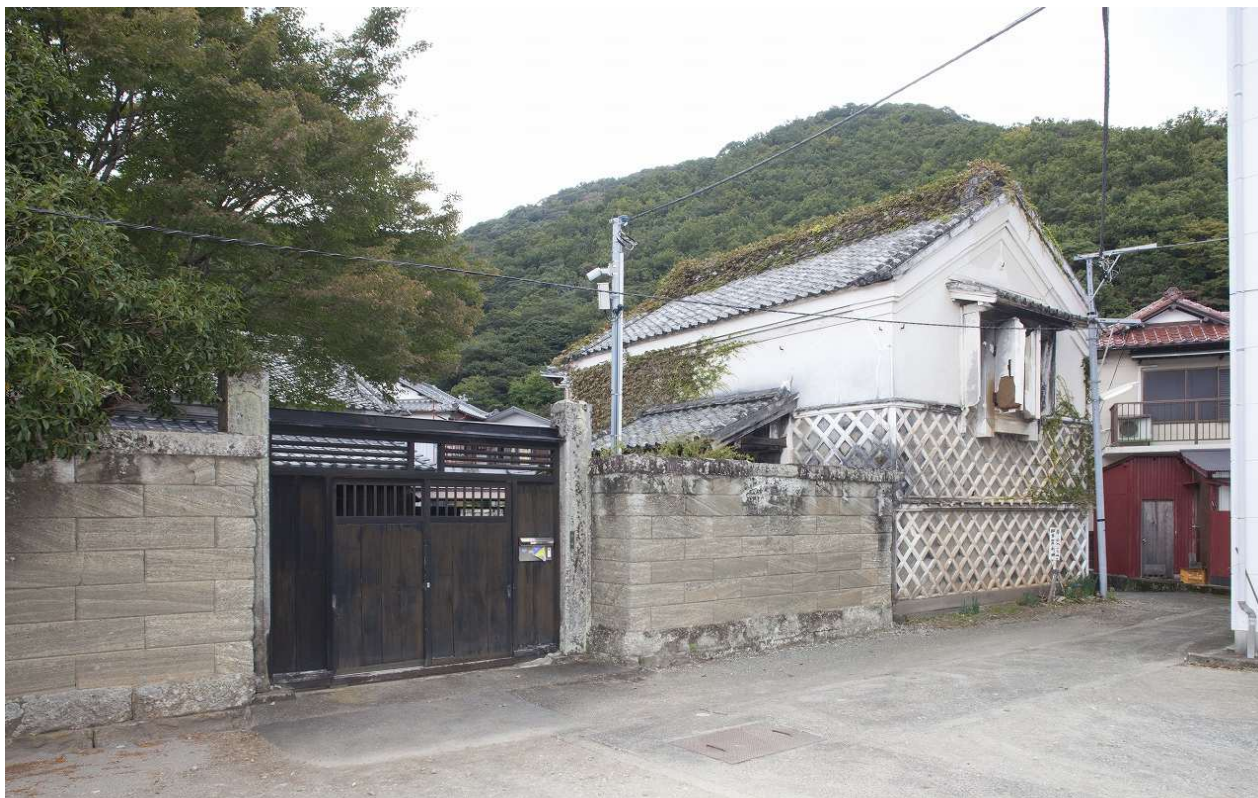
47 正面東半（南西より）
