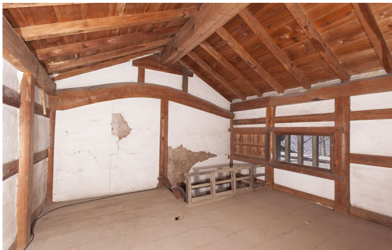
44 2階西室（北西より見る）
