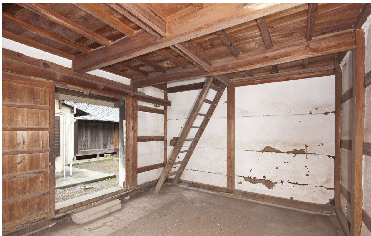
41 1階東室（北東より見る）
