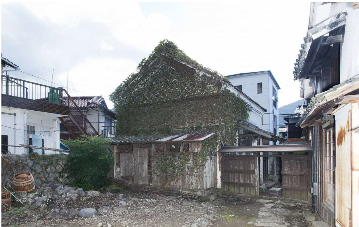
34 側面（北西より見る）
