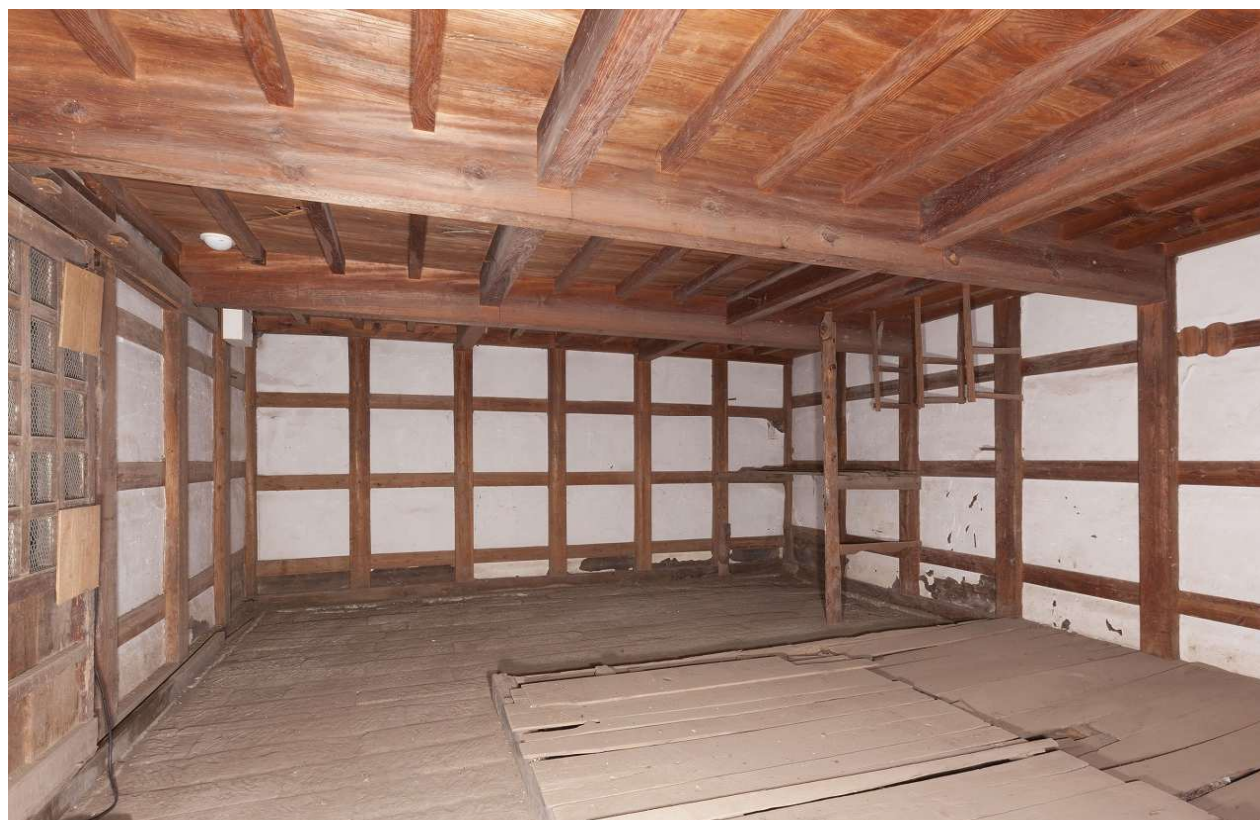
36 1階内部（南西より見る）
