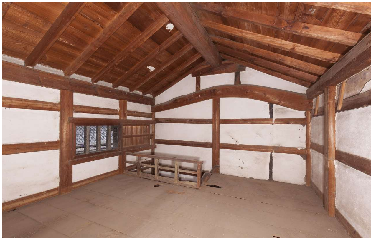
43 2階東室（北東より見る）
