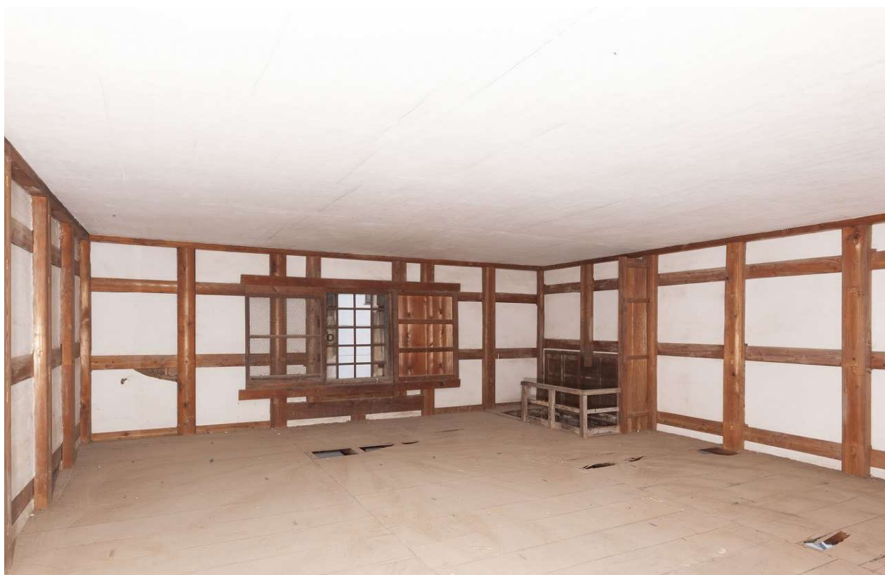
38 2階内部（北東より見る）
