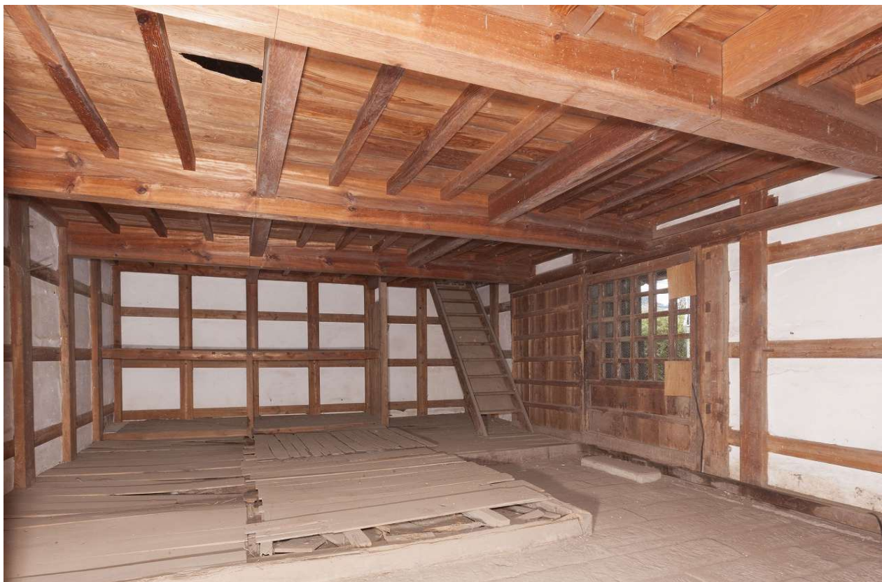
35 1階内部（北東より見る）
