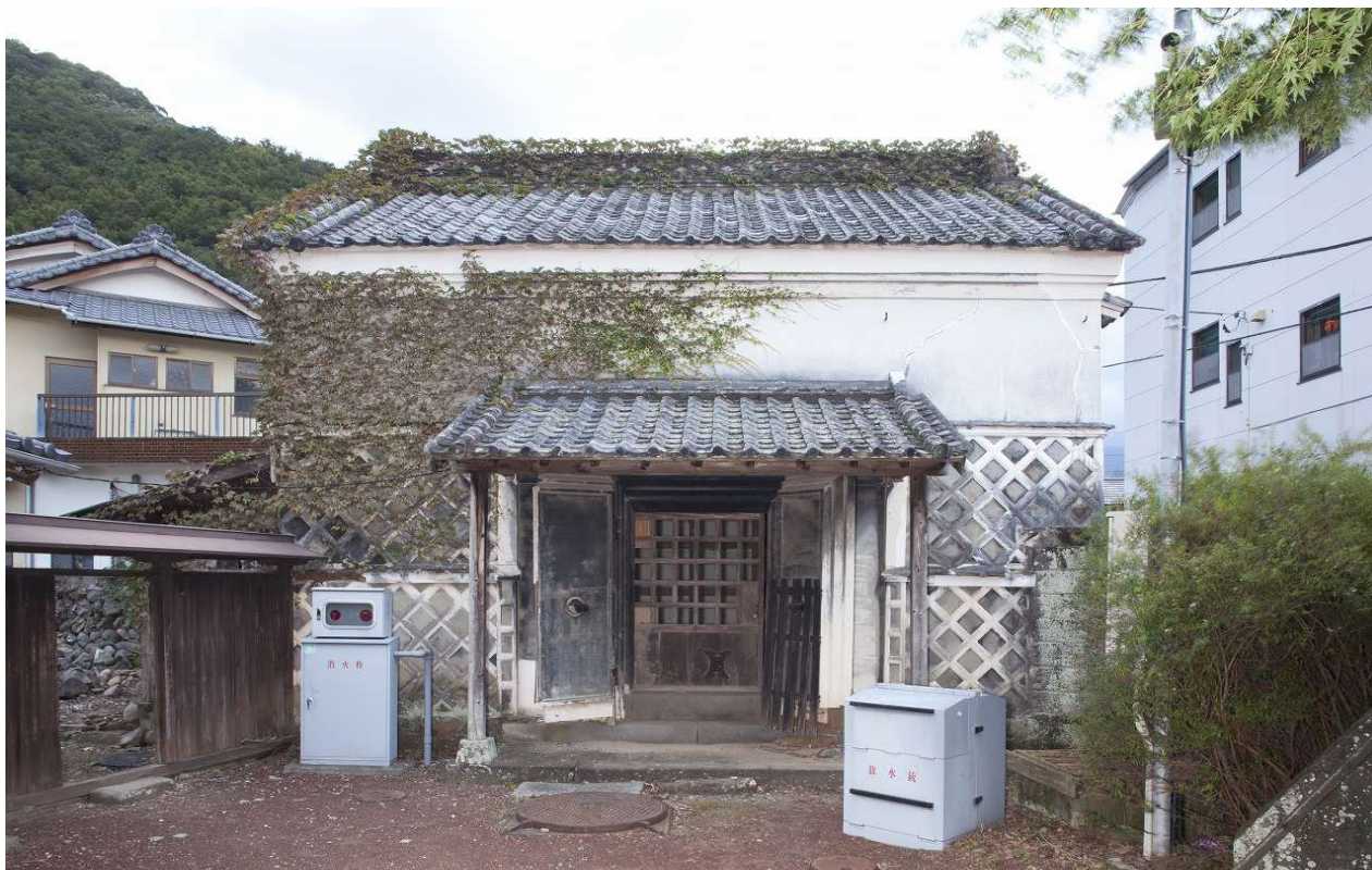
33 正面（西より見る）
