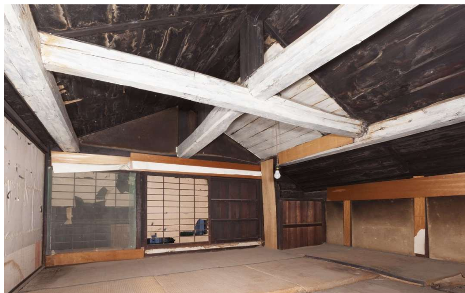
27 2階内部 (北西より見る)
