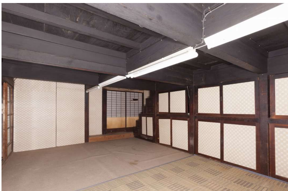
26 1階内部 (南東より見る)
