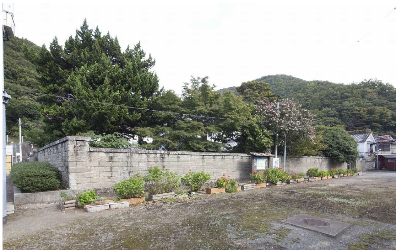
46 正面（南西より見る）
