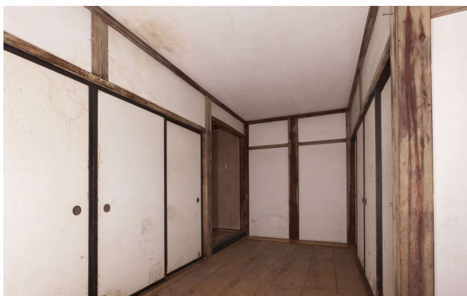
32 2階内部 (南東より見る)
