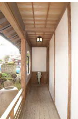
便組25 南廊下造作完了
