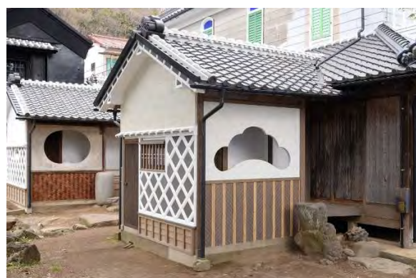
風組26 外壁左官仕上げ及び造作完了（南西より見る） 開放部はこの後活用事業において、木枠を組み透明アクリル板で塞いだ。
