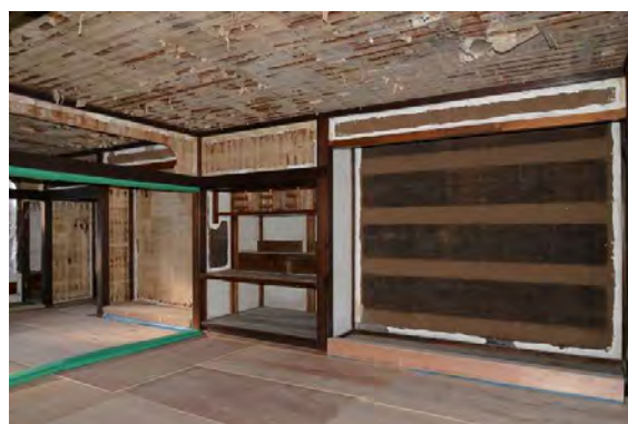
主解41 2階北西十畳間天井紙、壁紙解体完了
