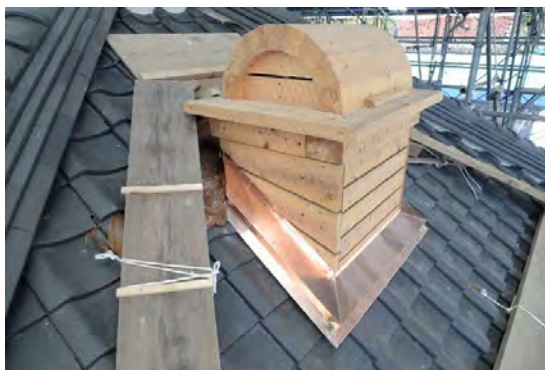
主組25 煙突木下地及び水切り銅板設置完了
