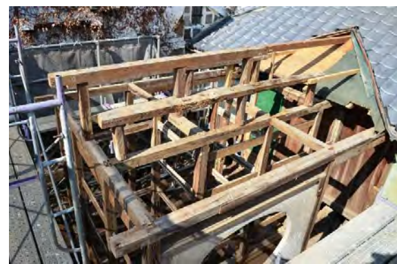
便解7 小屋組状況
