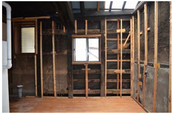
釜解6 新建材内装解体状況
