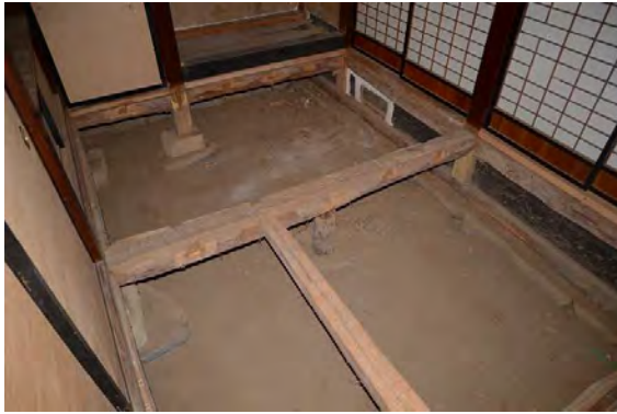
主解52 オクナンド根太解体完了
