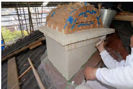
主組26 煙突漆喰下塗り状況
