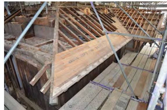
主解24 南下屋野地板解体状況
