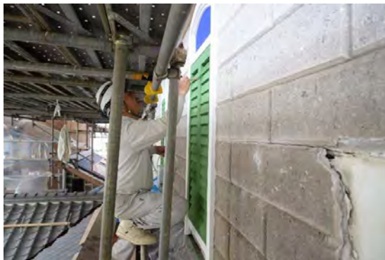
主組50 2階外壁西面擬窓 色漆喰施工状況
