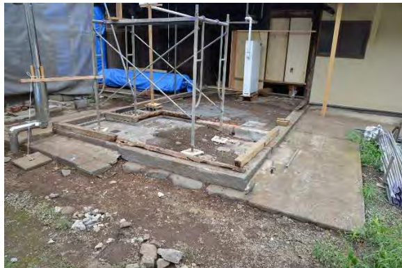
釜解16 軸部解体完了
