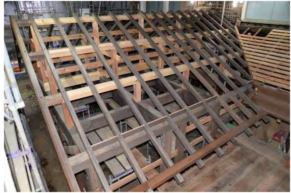
カ組2 小屋組・垂木組立状況（北西より見る）
