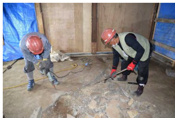
主解32 ドマコンクリート解体状況 内部土間叩きのほぼ全てが戦前～戦後にかけてセメント入りのものに変更されていた。
