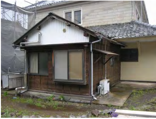
釜解1 外観現況（北東より見る） 平成4年の造替により突出部は全て後補材（文化財指定範囲外）
