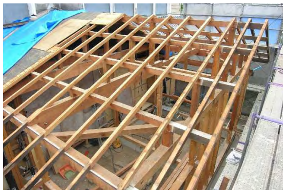
カ解5 小屋組状況
