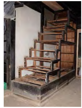
主解54 北東ドマ箱階段段板、蹴込板解体状況
