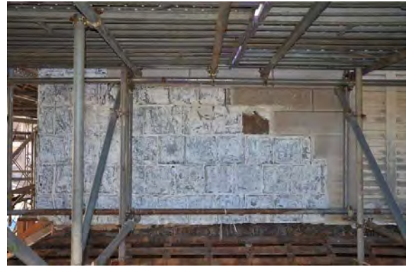
主解58 外壁石積風漆喰大壁（擬石塗）解体完了
