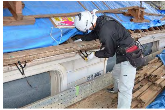
主組33 大屋根軒樋受け金具取付状況
