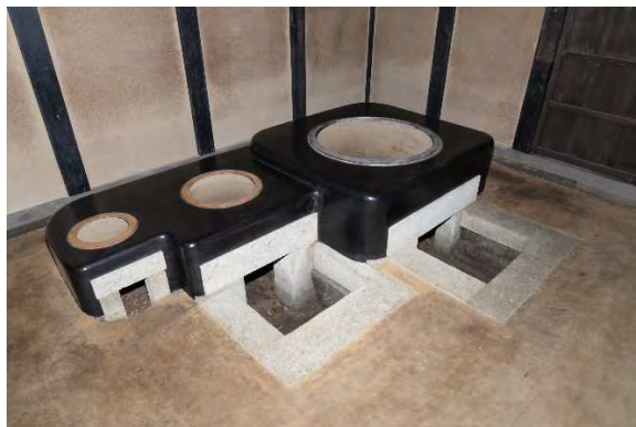
釜組18 竈施工完了 地上部分は古材が残っていなかったため類例による復原とした。
