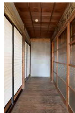
主組94 1階南縁 造作及び建具復旧
