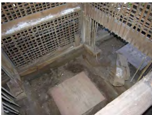
便解27 内部床組解体完了 昭和50年頃水洗化工事で、床下壁・土台・基礎石を切り取り、配管が通されていた。
