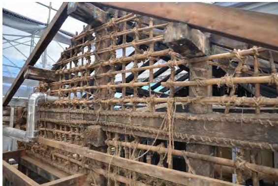
釜解11 東面妻壁下地状況
