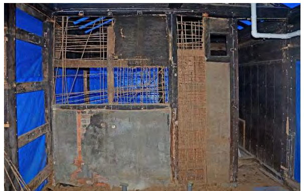
釜解8 後補間仕切り（大正頃）解体状況
