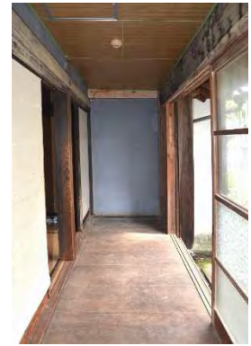
主解8 1階南縁現況（西より見る）
