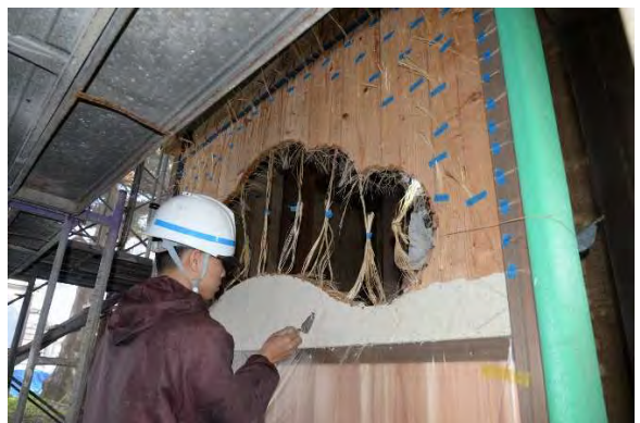
風組17 砂漆喰変り塗鏝波調仕上下塗状況 (南面) 便所に倣い、板張り下地とした。
