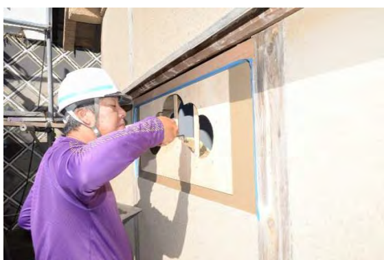
便組17 松形下地窓左官施工状況 当初のものは破損が酷かったため大外しとして資料保管した。
