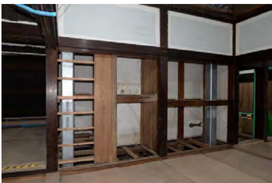
主組88 中央部鉄骨建方完了 ホンゲンカン押入内
