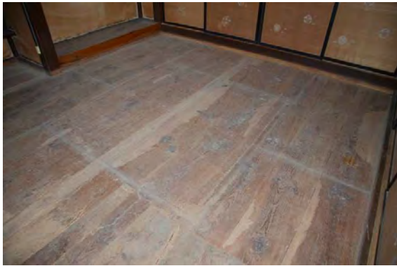
主解48 オザシキ荒床板状況
