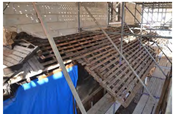
主解20 東下屋屋根小舞野地状況 当初の小舞野地が残っていた。
