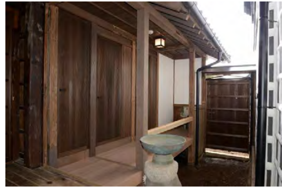
便組24 北廊下造作完了(北東より見る)
