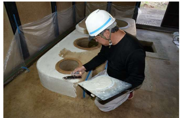
釜組17 竈塗り施工状況
