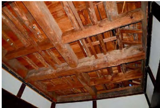
主解55 1階オクナンド竿縁天井解体完了
