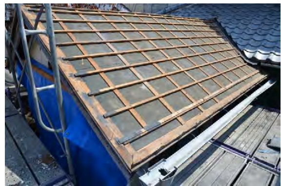
便解5 屋根下地状況
