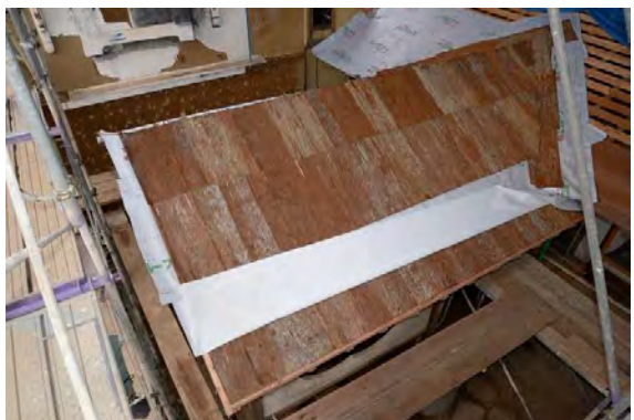
便組10 屋根下地完了
