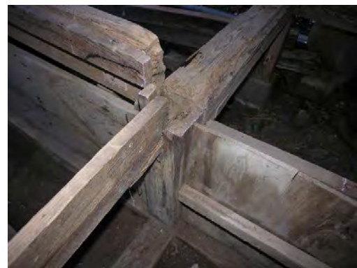
便解24 便所個室西から3北東柱切断痕
