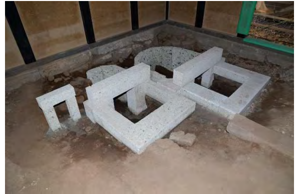
釜組15 竈焚口石積み完了 焚口の石積みの2段目以下は古材を再利用した。
