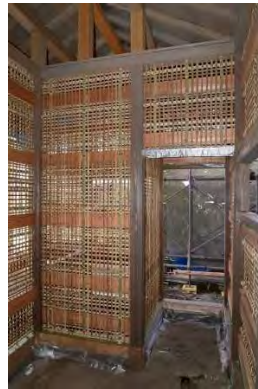
風組10 左官下地完了 (内部)
