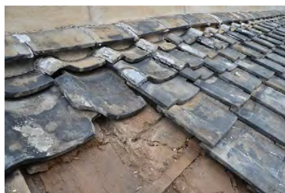
主解18 東下屋屋根解体状況 野地には修理が1回行われ、古瓦が再用されていた。
