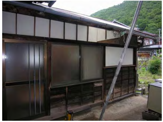
釜解2 外観現況（南西より見る）
