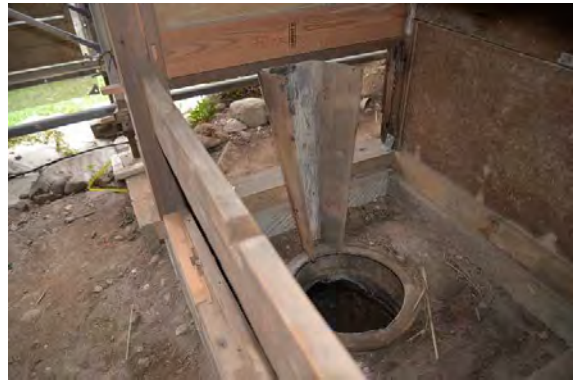
便解30 小便器～糞流し板（床下納まり） （床下残置材、仮組確認のみで復旧せず）
