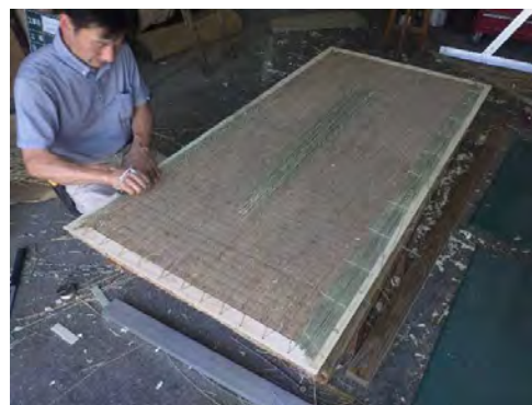
主組64 2階西半4室畳表替え状況1 旧手縫い床を再用し、四方板は極力再用了。
