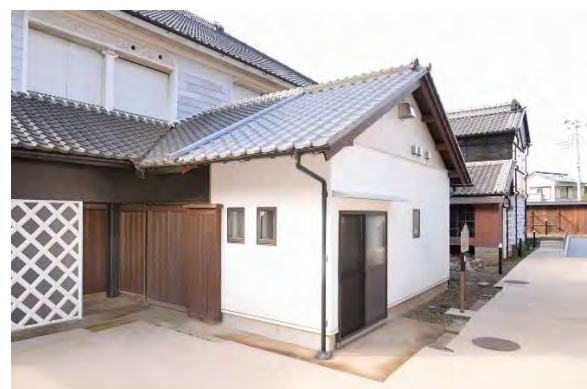
カ組8 外壁施工完了（北東より見る）
