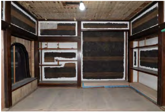
主解35 1階ジョウダンノマ壁紙解体完了 金散らし和紙張付壁
