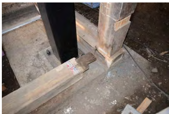
主組9 北東下屋土台組立状況
