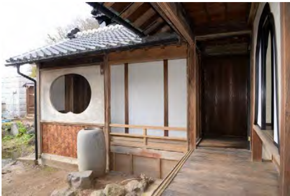
便組23 南廊下造作完了(南東より見る) 開放部はこの後活用事業において、木枠を組み透明アクリル板で塞いだ。
