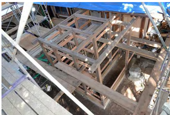
風組6 軸部組立状況2
