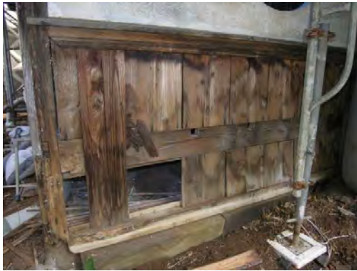
便解25 南面腰下外壁新材外装解体完了 当初杉皮網代張り断片残存
