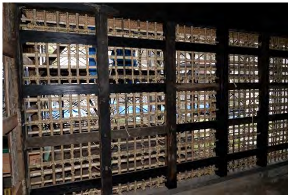
釜組10 木舞掻き完了
