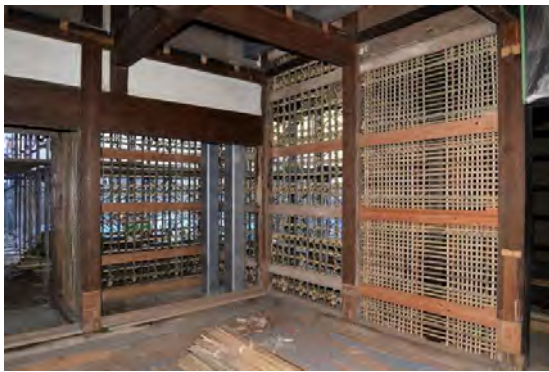
主組36 北東下屋木舞掻き状況（内部より見る）
