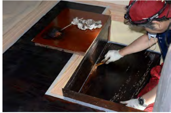
主組66 廻階段うるみ漆塗 刻芋飼い作業状況 蹴込板で劣化の少ないものは部分補修とした。
