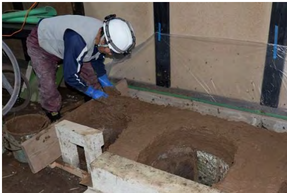
釜組16 竈塗り施工状況
