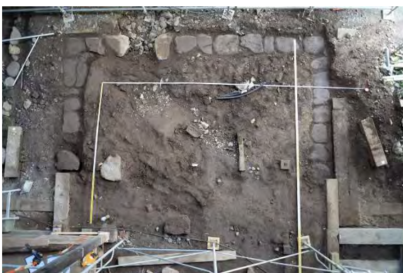
カ解8 布石部分解体状況 今回の台所部分復旧は当初基礎布石を記録保存とし、撤去の後RC基礎を立ち上げた。
