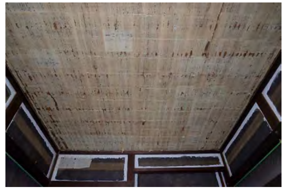
主解36 1階ジョウダンノマ天井紙解体完了 金散らし和紙張付天井
