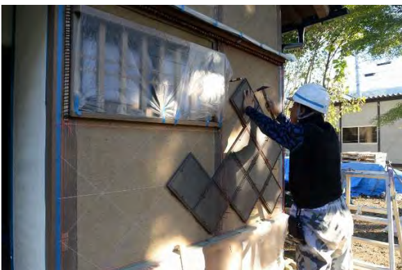
風組16 海鼠瓦取付状況 (西面腰壁)
