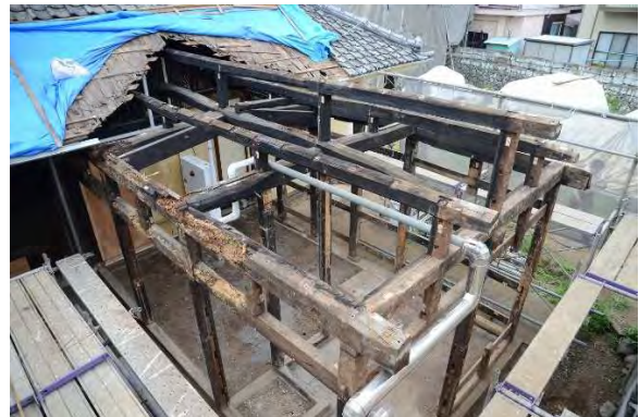
釜解13 小屋組状況
