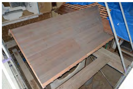
便組9 野地板組立完了
