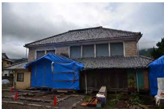
主解11 北面現況（台所先行解体完了）
