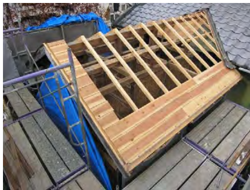
便解6 垂木及び野地板状況 垂木から上は全て後補材
