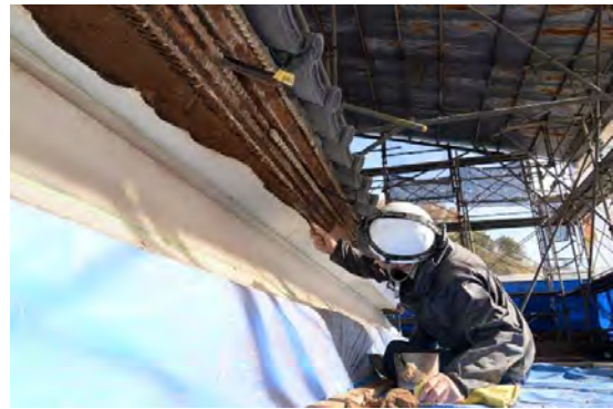
主組51 2階揚げ裏含侵強化状況 補強箇所の材質に応じ、ハイレックスやアクトメールなどを希釈して含浸させた。
