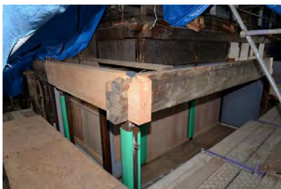
主組11 南西下屋根組立状況
