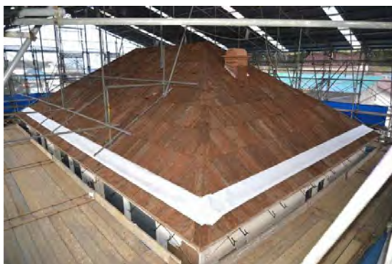
主組22 大屋根下地完了 空葺とするため、防水紙を敷き込んだ。軒先では杉皮土居葺より防水紙の上に出し排水を工夫した。
