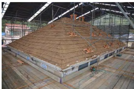
主解15 大屋根下地状況（南西より見る）
