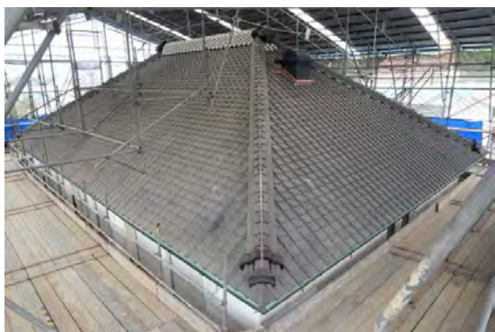
主組30 大屋根施工完了
