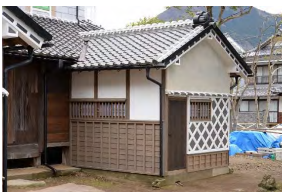
風組27 外壁左官仕上げ及び造作完了（北西より見る）
