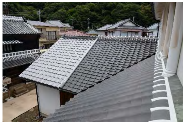
カ組6 屋根施工完了
