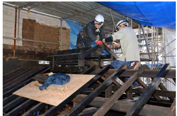
釜組5 越屋根組立状況
