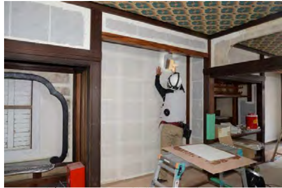
主組81 2階南西八畳間壁紙（金散らし和紙）下張り状況
