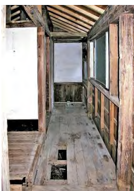
便解17 北廊下後補床組解体完了
