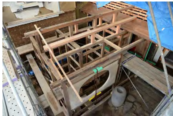
便組7 小屋組組立状況
