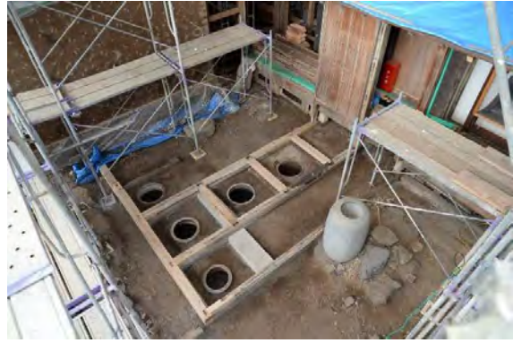
便組4 土台設置完了
