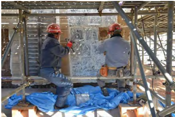
主解57 外壁石積風漆喰大壁（擬石塗）解体状況
