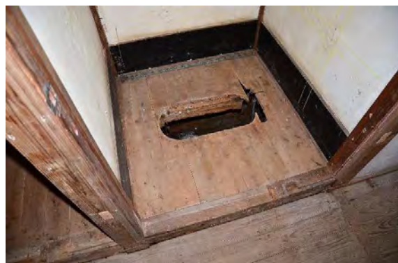
便解14 便所個室西から2 後補床板
