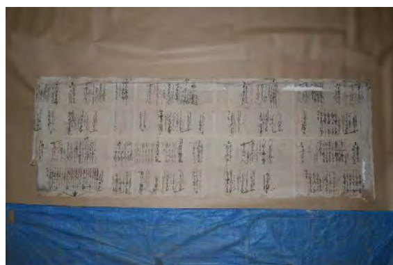
主解34 1階ジョウダンノマ解体天井紙 裏側下張り 日記や帳面などの反古紙が利用されていた。
