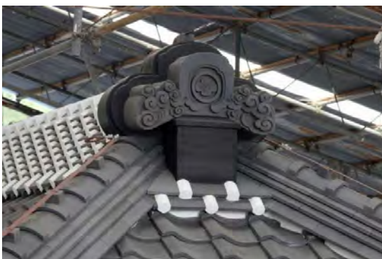
主組31 大棟端納まり（西側） 今回の工事では、大棟廻りのみ目地漆喰巻を復原した。
