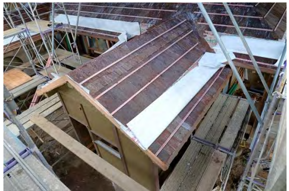
風組13 屋根下地完了
