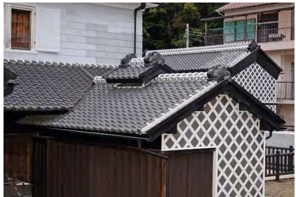
釜組9 屋根漆喰施工完了
