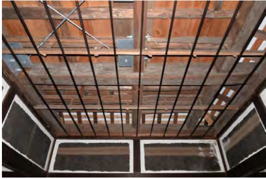
主組17 ホンゲンカン竿縁組立完了 今回の工事では天井裏で部分的に構造補強水平ブレースを取り付けた。
