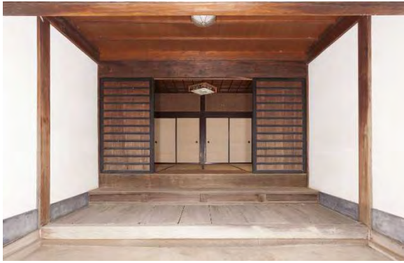
主解1 式台現況（南より見る）
