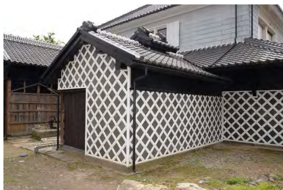
釜組20 海鼠壁施工完了（北東より見る）
