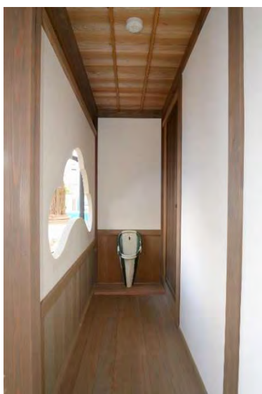
風組24 南廊下便所部分造作完了
