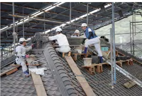
主組29 大棟施工状況
