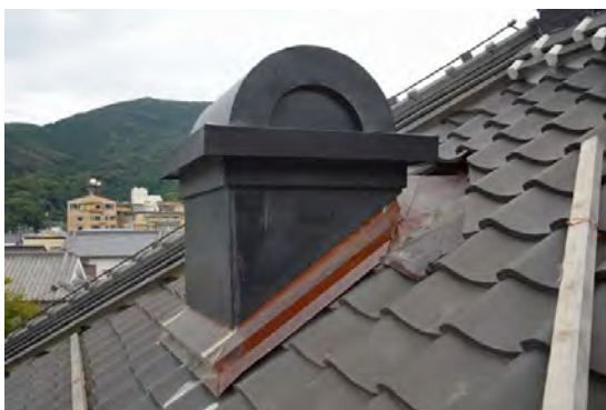
主組27 煙突施工完了 古写真を元に黒漆喰仕上げで復原したが、形を合わせた板金を被せるなど雨仕舞に留意した。
