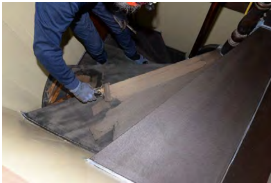
主組67 廻階段うるみ漆塗 切粉付け作業状況
