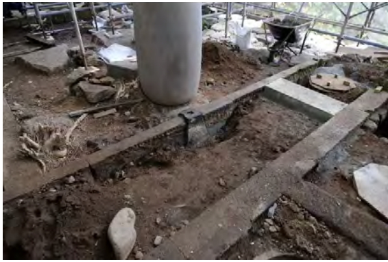
便組3 布石・沓石据直し状況
