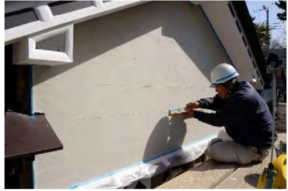
便組20 石積風浅目地入砂漆喰仕上施工状況
