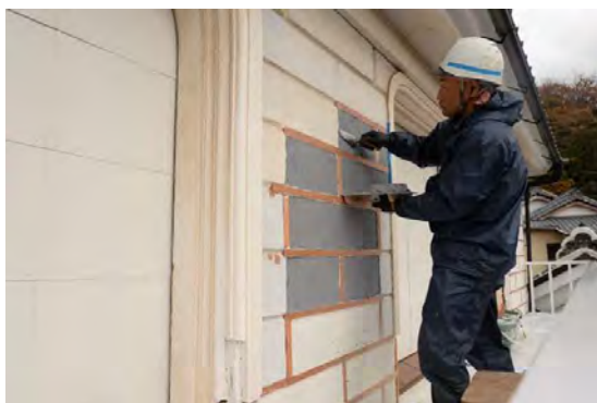
主組47 2階外壁南面擬石塗 上塗り状況
