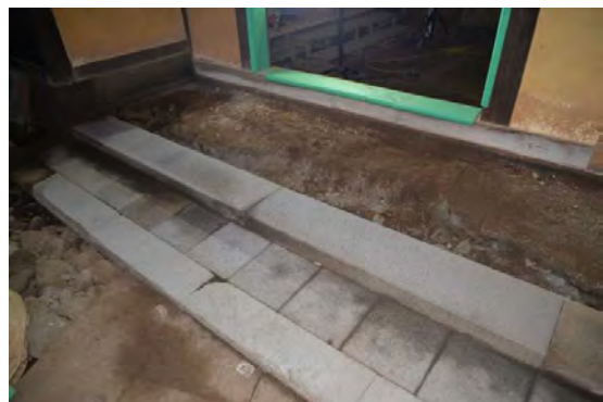
主組4 ワキゲンカン（踏込）敷石補修完了
