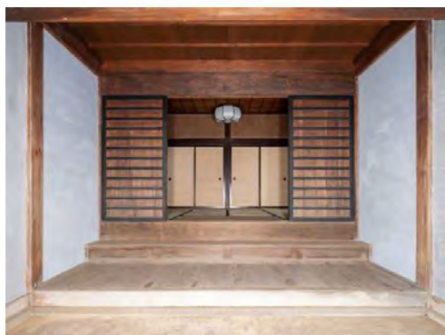
主組92 式台床板復旧及び壁補修完了
