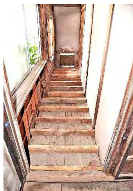
便解16 南廊下後補床板解体完了
