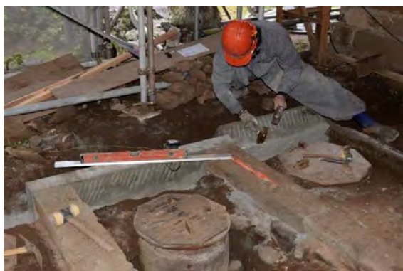
便組1 補足布石据付状況
