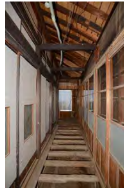
主解53 北縁床板、竿縁天井解体完了
