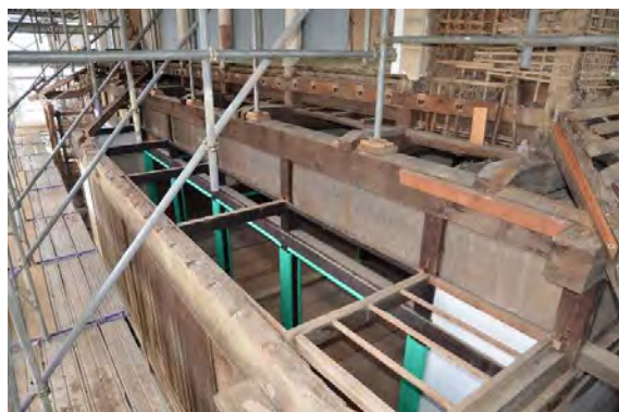
主解27 北下屋垂木解体完了
