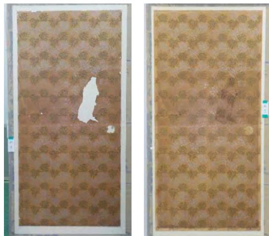
主組57 2階応接間襖補修状況（左）と補修完了（右）
