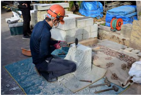
釜組14 竈焚口鳥居石加工状況
