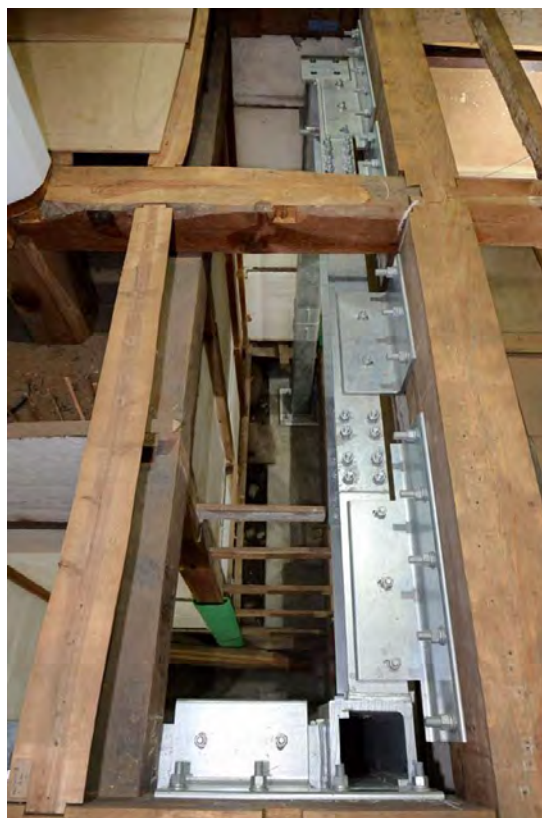
主組89 中央部鉄骨建方完了（2階南西八畳間より見る） ジョウダンノマ・ホンゲンカン押入内。鉄骨フレームで床梁を固定。手前柱頭はND工法によった。
