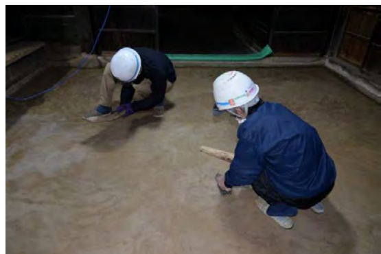
主組8 ドマ叩き施工状況
