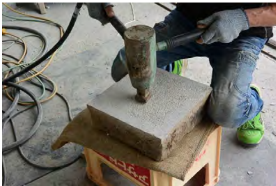
主組3 ワキゲンカン（踏込）敷石再加工状況 表層剥離・劣化部分を除去して下げた位置に仕上げ加工を 施し、その分上げて据え直した。
