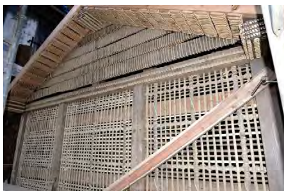
便組12 木舞下地・縄巻木摺下地完了（妻壁）
