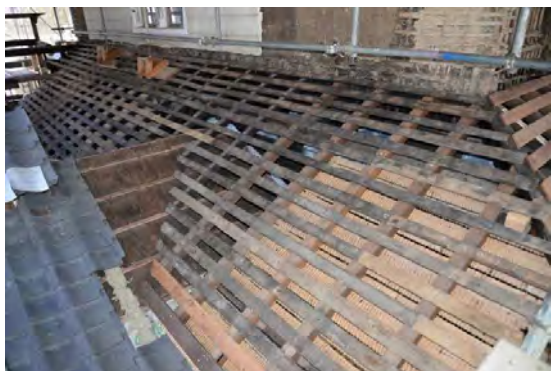
主組13 東下屋小舞野地組立完了 揚げ裏部分は垂木下端に縄巻小木摺板打ち付け。
