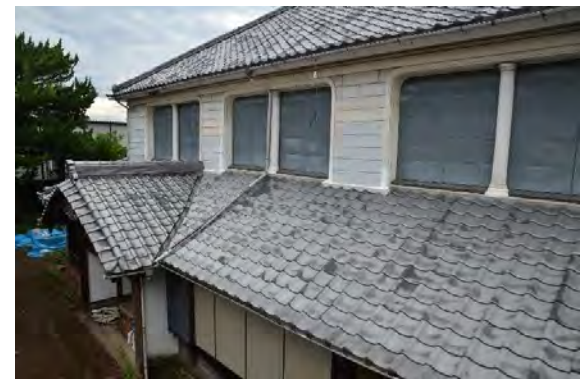
主解10 南下屋屋根及び2階外壁現況（南東より見る）
