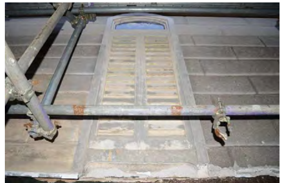
主解56 外壁漆喰塗擬窓現況
