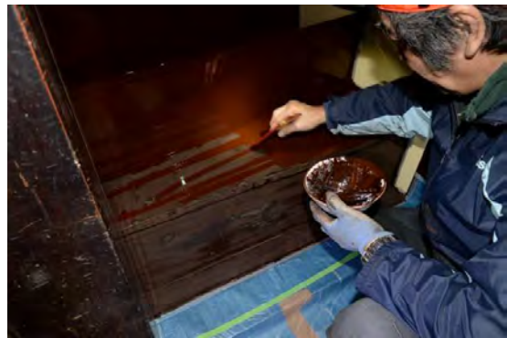
主組68 廻階段うるみ漆塗 上塗状況
