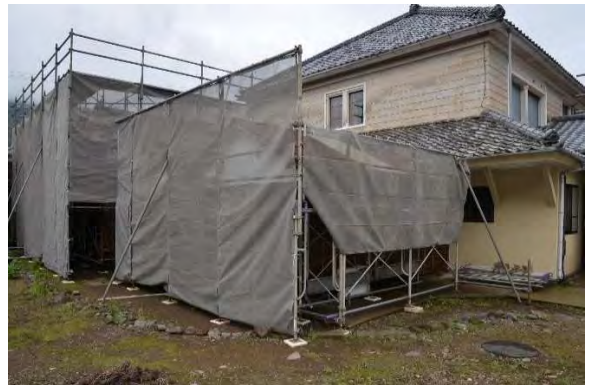
釜解4 軒足場建設完了
