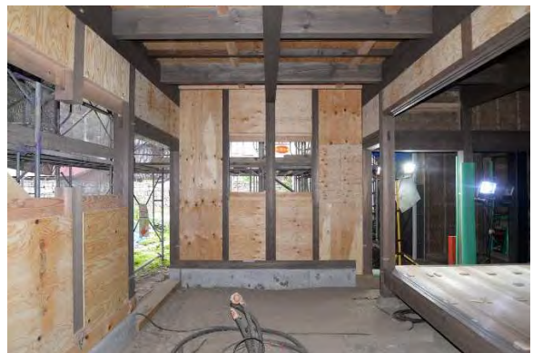
カ組4 台所構造用合板取付状況
