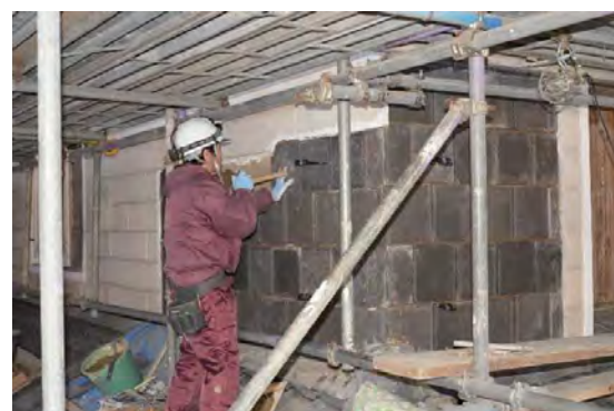
主組44 2階北東外壁 擬石塗下地(海鼠瓦) 取付状況
