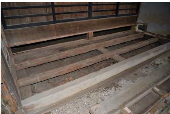
主解50 1階式台床組状況 式台のうち突出部は全て平成4年取替材であったが、南下屋に組み込まれる階段・床組は当初のもの。
