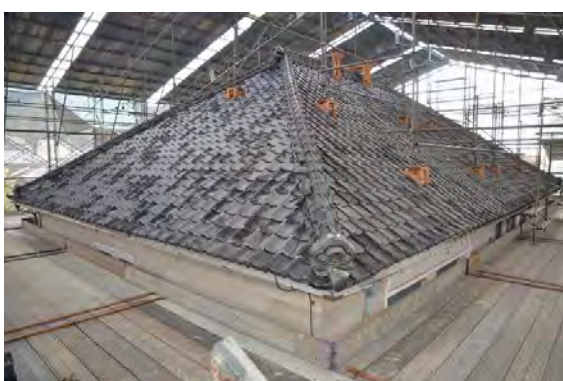
主解14 大屋根現況（北東より見る）
