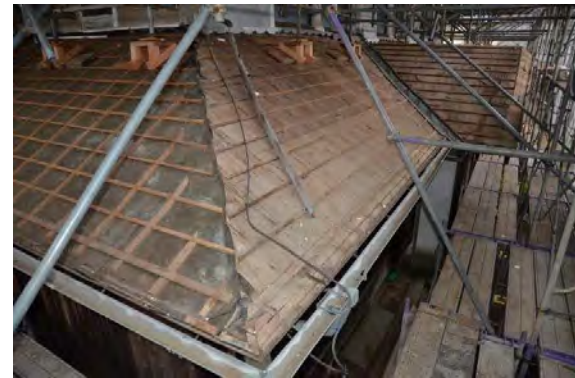
主解22 南下屋及び西下屋屋根下地状況 一部野地板から上が変わられ、全面にルーフィングが敷かれていた。
