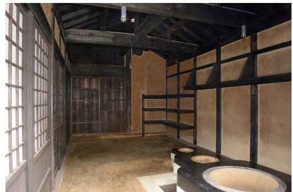
釜組19 棚及び建具復原完了（南東より見る）
