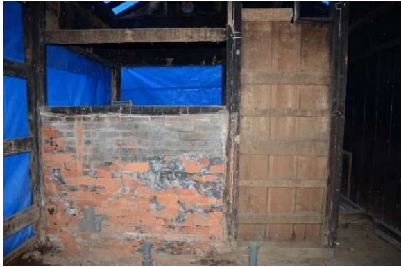
釜解9 後補間仕切り（大正頃）煉瓦積み
