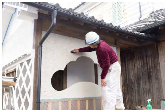
風組18 砂漆喰変り塗鰻波調仕上塗状況 古写真より変り塗を復原した。
