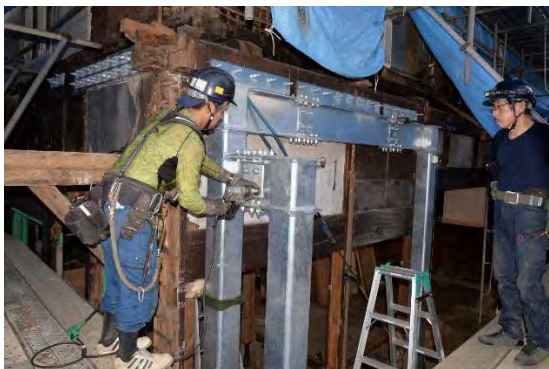
主組85 北東隅部鉄骨ボルト締め作業状況
