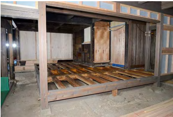
カ組3 カッテ床組立完了
