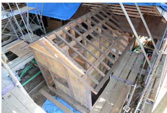
風組8 垂木組立状況
