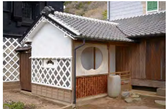
便組22 外壁左官仕上げ及び杉皮網代張施工完了 (南西より見る)
