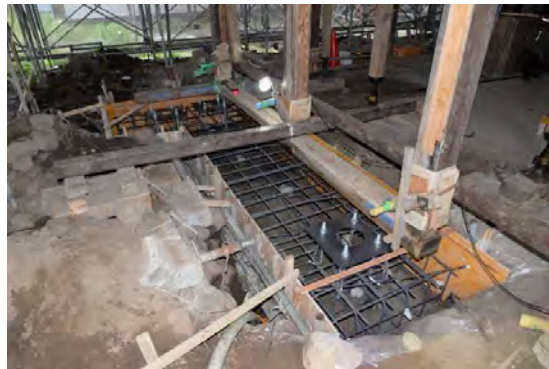
主組84 北東隅部構造補強耐圧盤配筋状況
