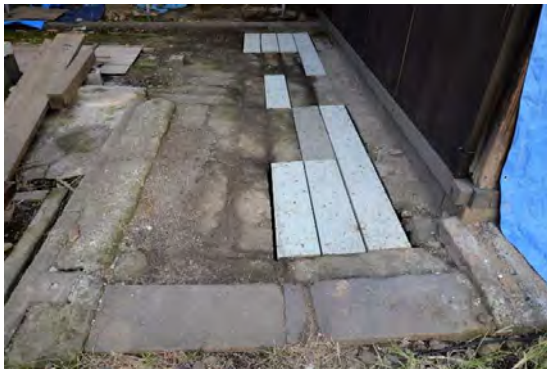
主組5 東下屋東側敷石取替え、据直し完了
