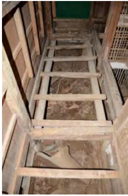
便解20 北廊下床組状況 当初床組残存
