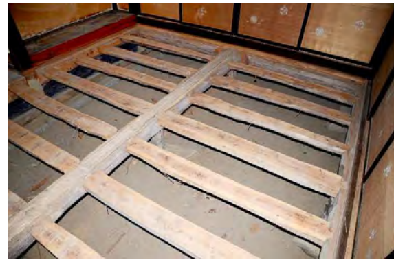
主解49 オザシキ床組状況
