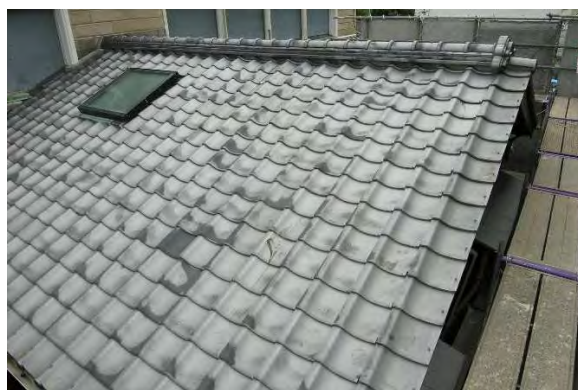
カ解3 屋根現況
