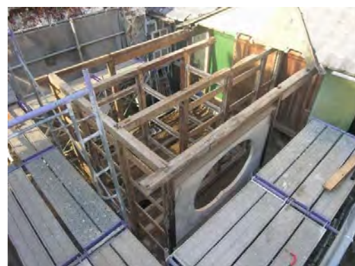
便解28 小屋組解体完了
