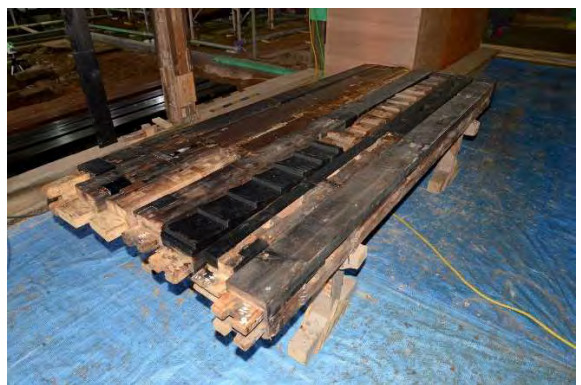
釜組1 柱補修状況
