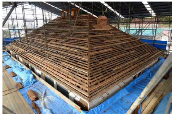
主組21 大屋根小舞野地組立完了（南東より見る）
