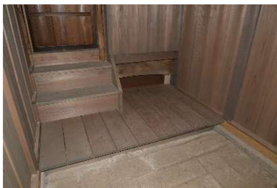
風組19 床及び階段設置完了（風呂部分）
