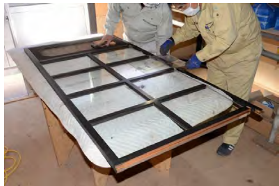
主組53 2階南西八畳間・応接間腰下ガラス戸 補修状況
