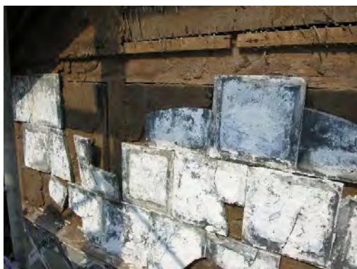
便解10 石積風浅目地入砂漆喰仕上解体完了（下部）
