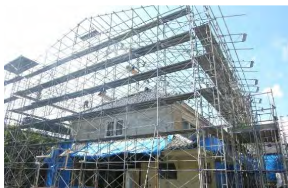
主解12 素屋根建設状況
