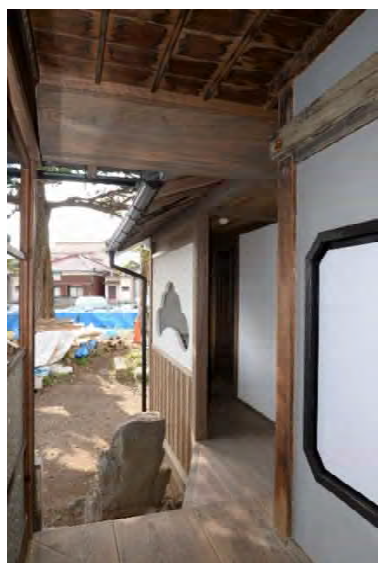
風組23 南廊下造作完了（東より見る）
