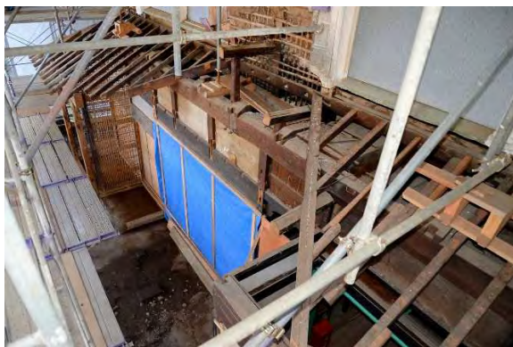
カ解6 軸部解体完了 当初棟木・母屋の切断片が主屋北面に取り付いたままになっていた。
