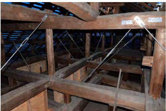
主組90 小屋裏補強完了 垂直ブレース及び小屋材応力伝達用構造用合板設置
