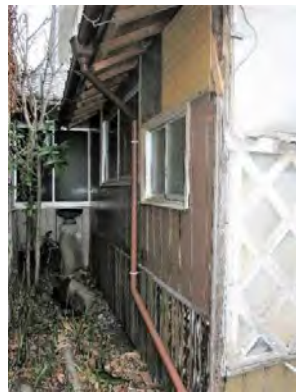
便解2 外観現況（北西より見る）
