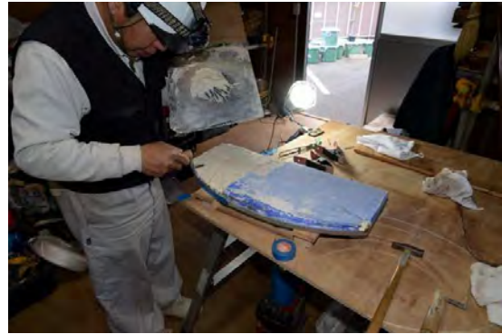
主組49 2階外壁西面擬窓ファンライト補修状況 旧仕上げ部分を残したまま薄く上塗り直しを行った。
