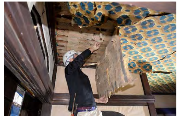
主解38 2階前の間天井紙解体状況 模様印刷洋紙張付天井
