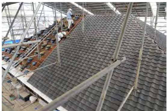
主組23 大屋根棧瓦葺状況
