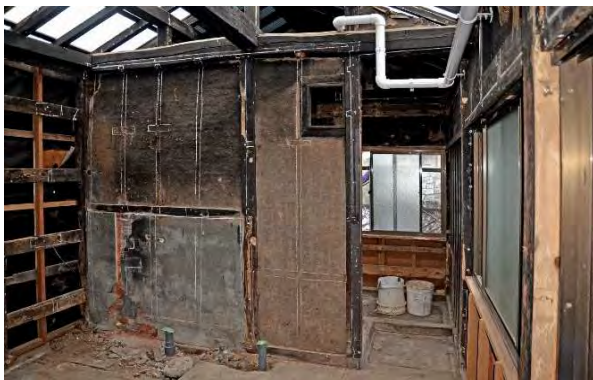
釜解7 新建材内装解体完了
