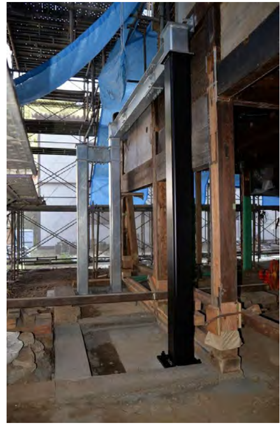
主組86 北東隅部鉄骨建方完了 手前の支柱は北東土間出入口踏込に位置し、北面外部からは一部見え掛かりとなるため黒色塗装。
