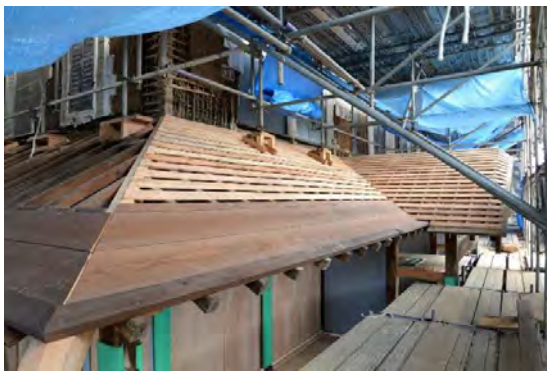
主組14 南下屋小舞野地及び化粧野地組立完了
