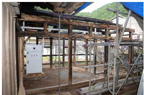
釜解15 南面軸部状況
