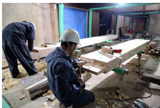
主組10 下屋根新材加工状況
