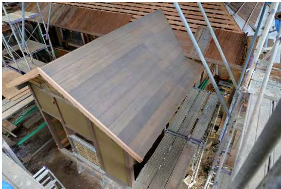
風組12 野地板組立完了
