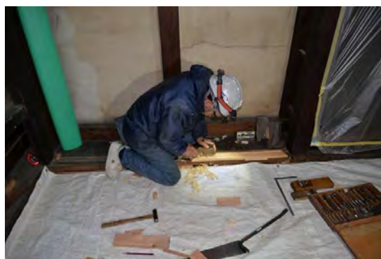
主組16 2階次の間敷居補修状況
