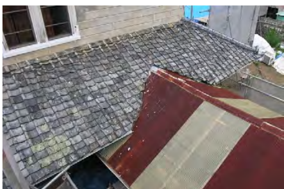
主解17 東下屋屋根現況（右手前は釜屋屋根） 際熨斗は概ね当初の状態が残っていた。
