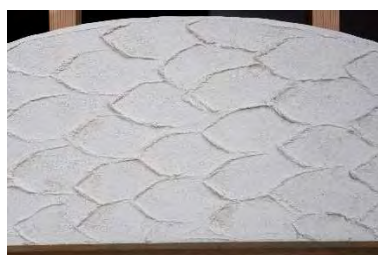
風組20 砂漆喰変り塗鰻波調仕上詳細
