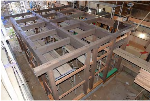
カ組1 軸部組立状況（北西より見る）
