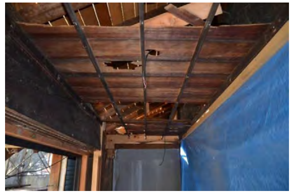
主解47 1階ヒロマ南側縁当初竿縁天井残存状況
