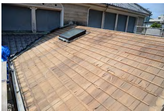
カ解4 屋根下地状況
