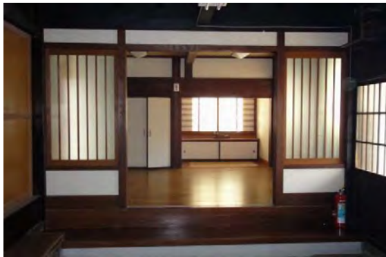
主解3 ドマ奥現況（南より見る）
