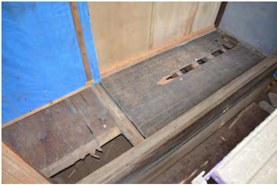
主解46 1階ヒロマ南側縁当初床板残存状況
