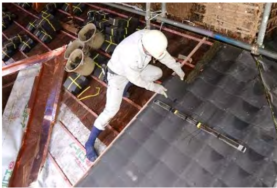
主組34 東下屋棧瓦葺状況
