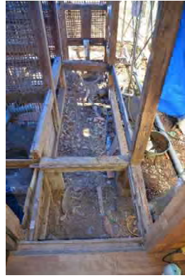
便解21 北廊下根太解体完了
