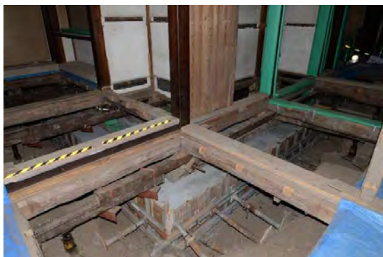
主組87 中央部構造補強耐圧盤 ホンゲンカン・ジョウダンノマ押入。コンクリート打設完了
