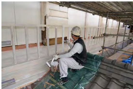
主組73 バルコニー ペンキ塗状況
