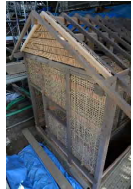
風組11 左官下地完了 (外部)
