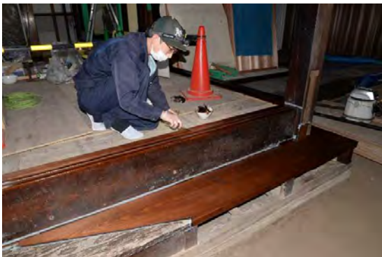
主組71 ナカノマ上框 弁柄透き漆施工状況
