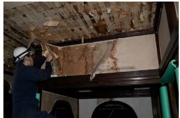
主解40 2階前の間壁紙解体状況 金散らし和紙張付壁
