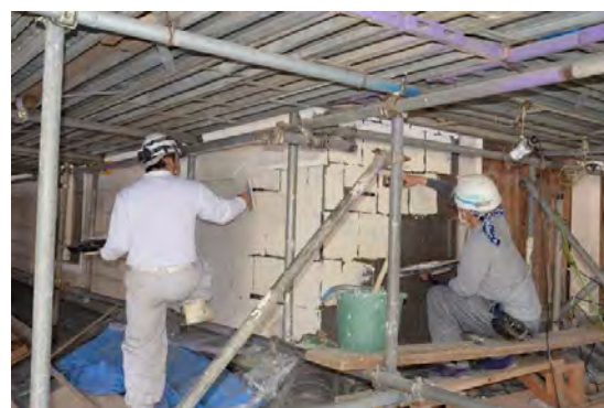
主組45 2階北東外壁擬石塗 下塗り状況
