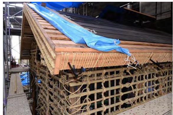
釜組11 木舞掻き、揚げ裏下地完了
