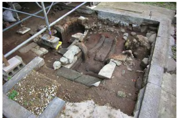
釜解18 竈発掘状況 (大正期間仕切煉瓦壁解体完了)
