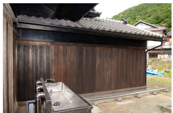
釜組21 雨戸復旧完了（南西より見る）
