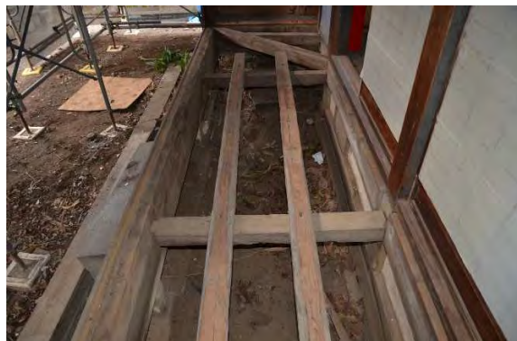
主解51 1階南縁床組状況
