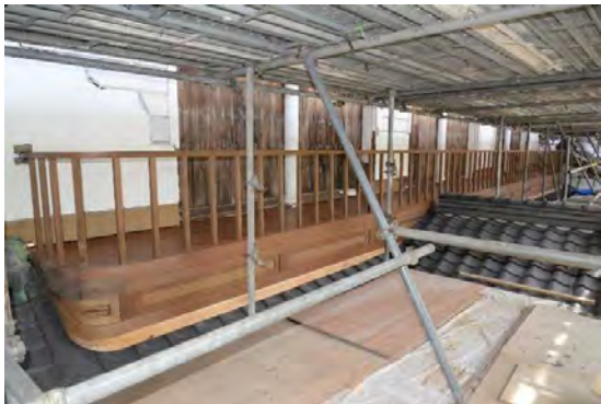
主組20 バルコニー組立完了
