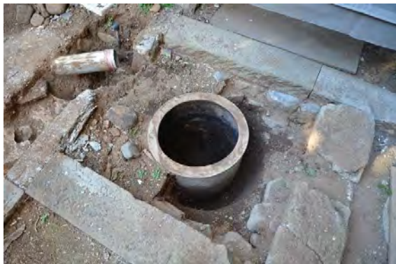
便解33 地中糞掘付状況掘削確認（西奥個室）
