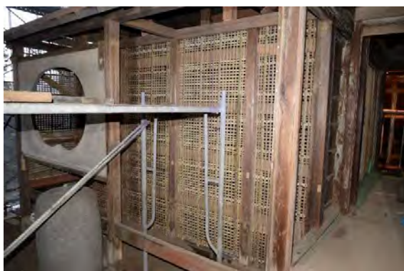
便組13 木舞下地完了（内部間仕切壁）
