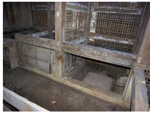
便解22 便所個室西から2・3 床下汲み取り用開口と横俵鈍板戸
