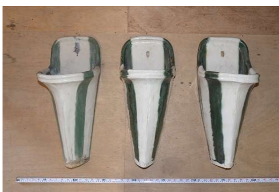
便組16 青竹朝顔形小便器 床下に残存していた当初材（左端）に倣い、右2つを新規作製。1つは風呂棟内便所に用いた。
