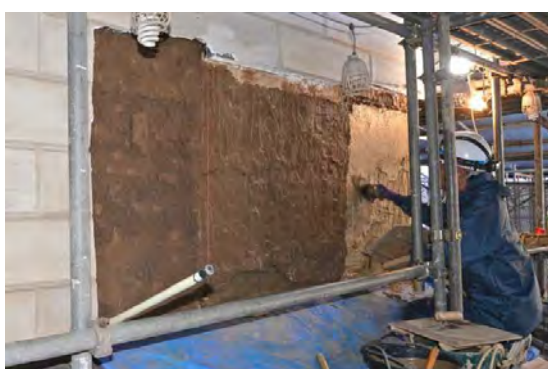
主組43 2階北東外壁中塗り状況
