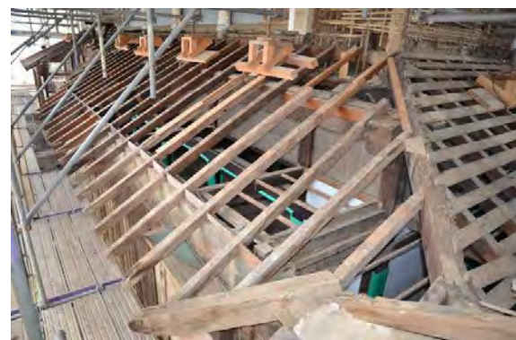
主解26 北下屋垂木状況
