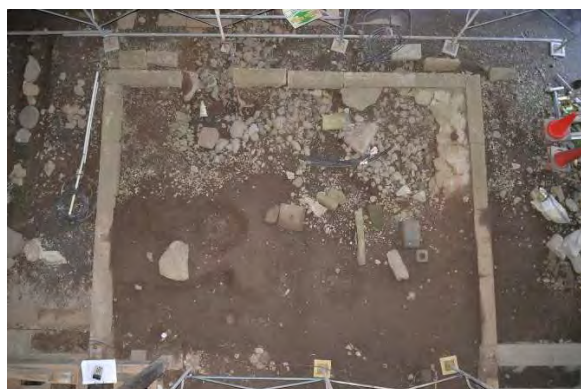
カ解7 当初基礎布石残存状況 現況コンクリートベタ基礎解体後
