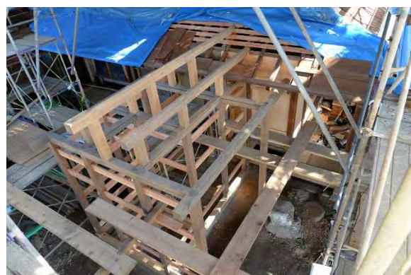
風組7 小屋組組立状況
