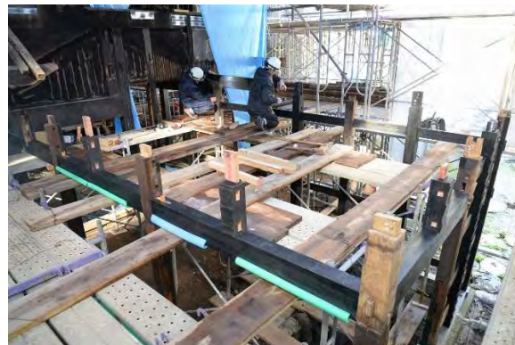
釜組2 軸部組立状況1
