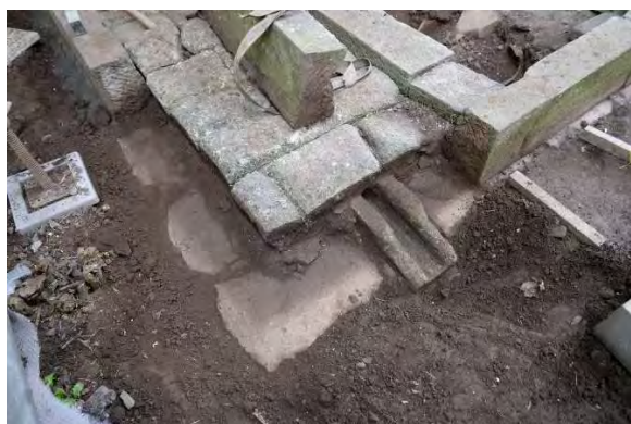
風組3 基礎布石解体状況（北西隅） 傷みと沈下の激しい側通りの基礎布石のみ解体した。洗い場から敷石下を潜って排水する仕様であった。
