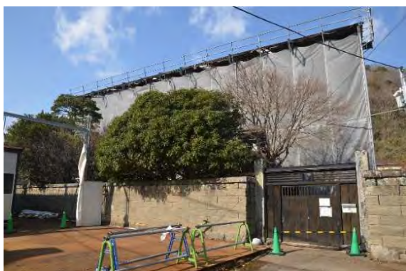
主解13 素屋根建設完了
