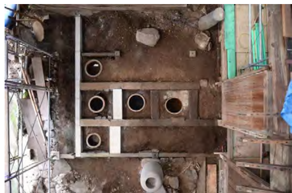
便組2 基礎布石取替、据付完了 床下5つの糞は全て存置した。
