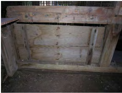
便解23 便所個室西から3 床下汲み取り用開口の横俵鈍板戸
