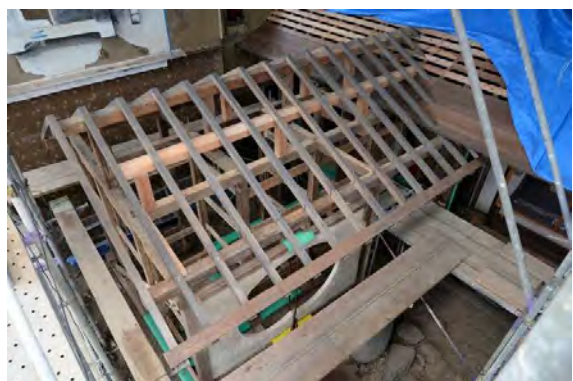
便組8 垂木組立状況
