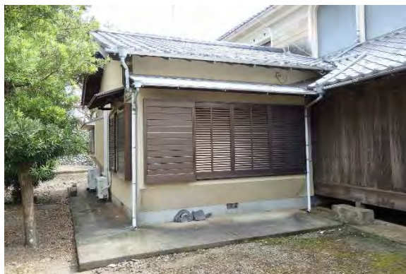
カ解2 外観現況（北西より見る）
