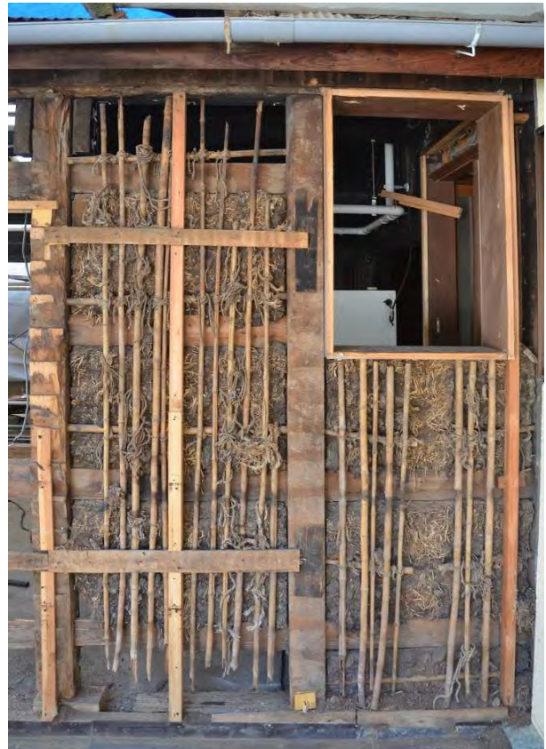
釜解10 北面西側壁解体状況（外部から見る） 内部側の下地と塗り壁は当初のものが残っていた。
