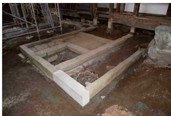
風組4 基礎布石取替、据付完了
