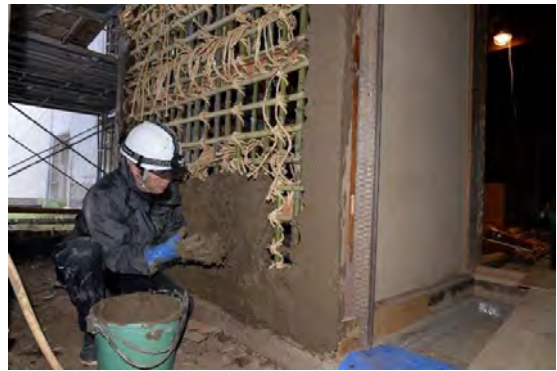
主組39 北東下屋荒壁付け状況
