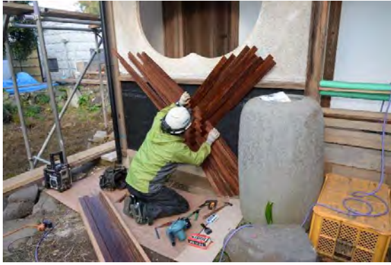
便組19 南面腰下外壁杉皮網代張施工状況 今回の工事では防水紙を張ってから施工した。
