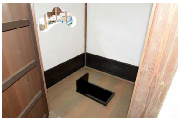
便組27 個室樋箱施工完了
