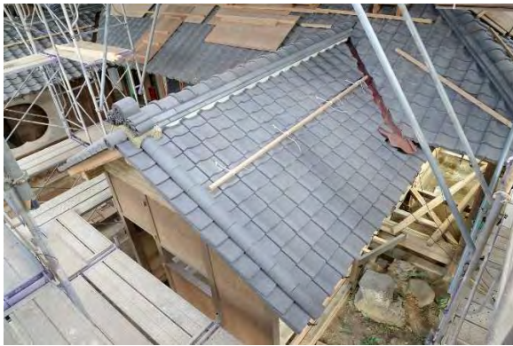
風組14 桟瓦葺完了
