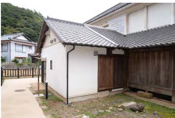
カ組7 外壁施工完了（北西より見る） 平面上復原したカッテ板敷きが突出する部分までを立面上も復原扱いとした。
