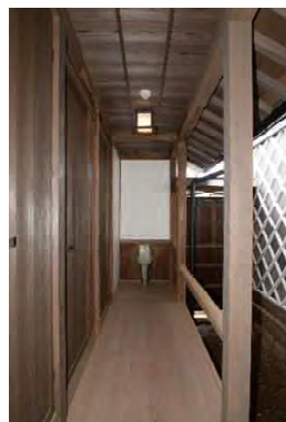
便組26 北廊下造作完了
