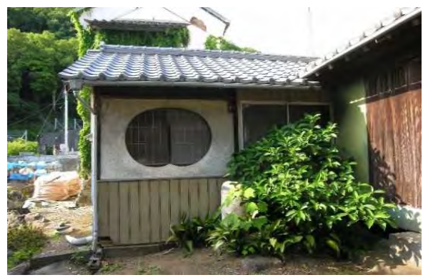
便解3 外観現況（南より見る）
