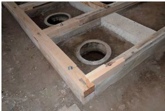
便組5 土台補強金具（アンカー）取付完了
