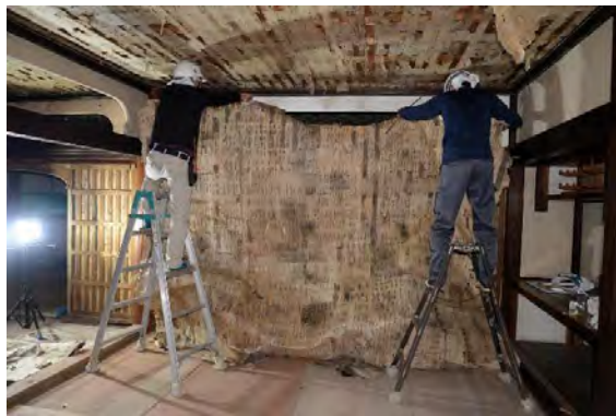
主解39 2階北西十畳間天井紙解体状況 模様印刷洋紙張付天井
