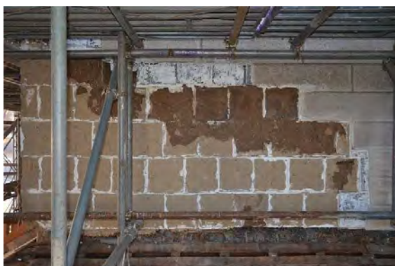
主解59 外壁擬石塗海鼠瓦解体完了 各面とも下方を中心に過去の修理が入っていた。
