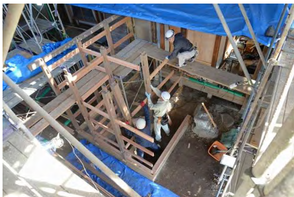
風組5 軸部組立状況1
