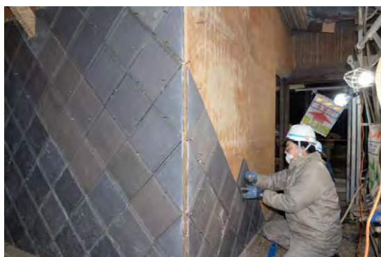
主組41 北東下屋海鼠瓦取付状況
