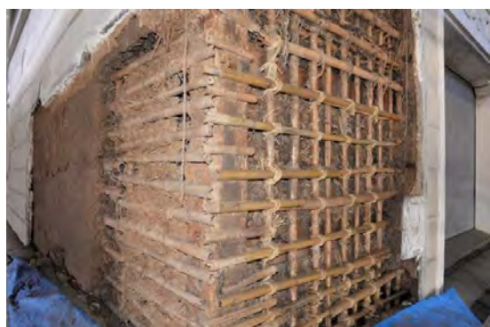
主組42 2階北東外壁木舞下地補修完了 下地丸竹は可能な限り古材を残し、端先破損箇所を中心に新材を補足した。
