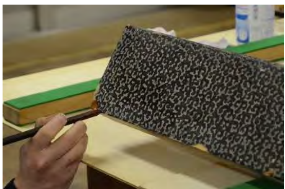
主組72 オクナンド床框 漆変り塗り補修状況
