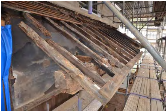
主解21 東下屋垂木状況
