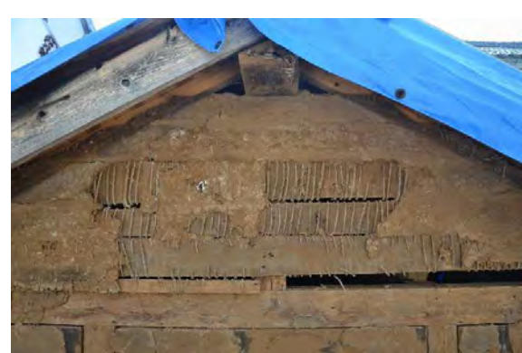
便解9 石積風浅目地入砂漆喰仕上解体状況（上部）
