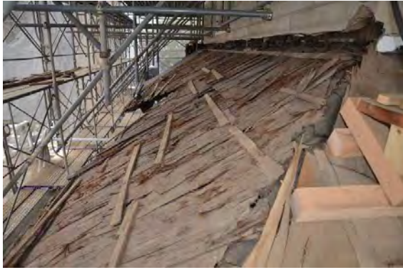
主解19 東下屋屋根下地状況
