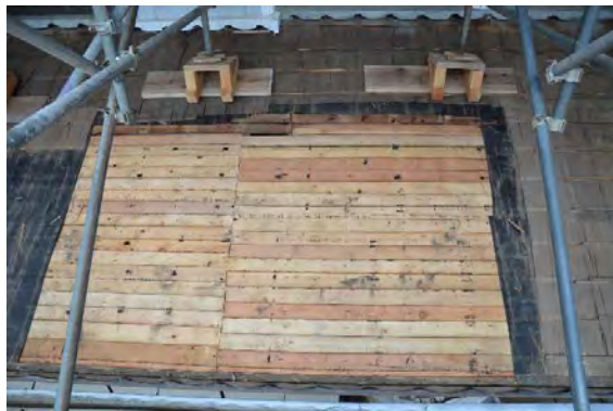
主解23 南下屋野地状況 後補のベタ野地
