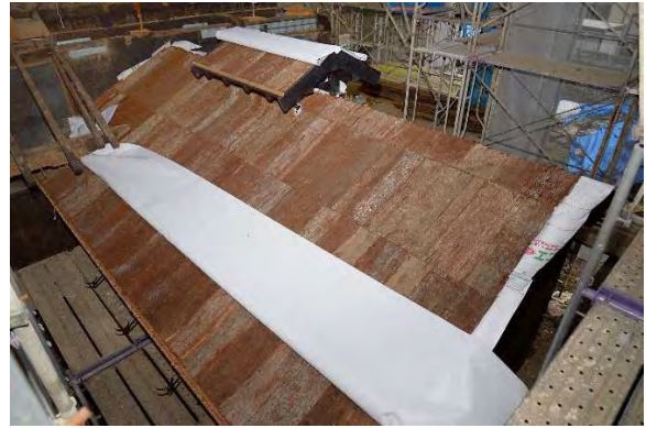
釜組7 屋根下地完了
