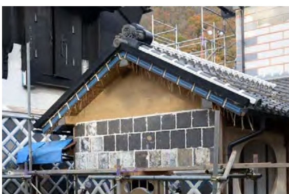
便組18 石積風浅目地入砂漆喰壁下地海鼠瓦施工完了
