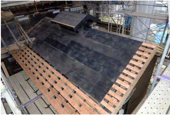
釜組6 野地板組立完了
