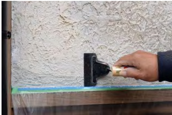
便組21 砂漆喰変り塗スタッコ風仕上補修状況 大外した桃形割抜窓を嵌め込み、散り廻りのみ補修した。
