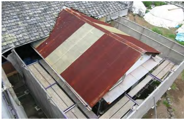
釜解5 屋根現況
