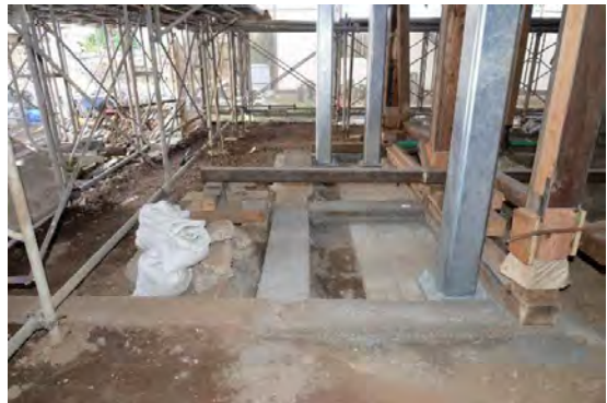
主組6 北東布石取替え、据直し完了 後世の改造で破損を受けていた布石は取替え、補強の鉄 骨・ベタ基礎設置後据え付けた。
