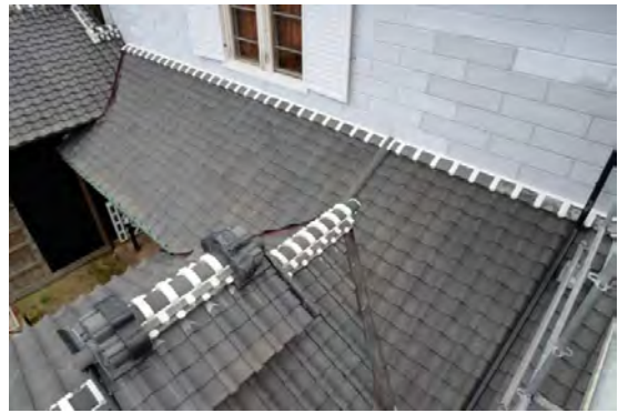
主組35 東下屋根施工完了 手前は釜屋屋根（越屋根付き）
