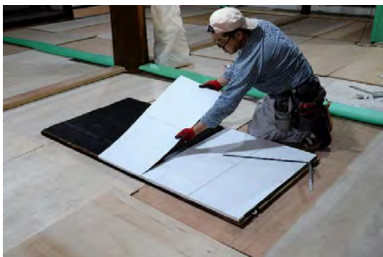
主組63 2階雨戸鉄板張り状況
