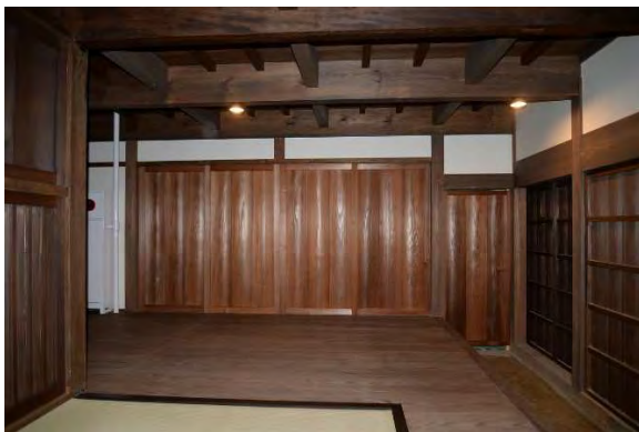
カ組5 カッテ床板、建具施工完了
