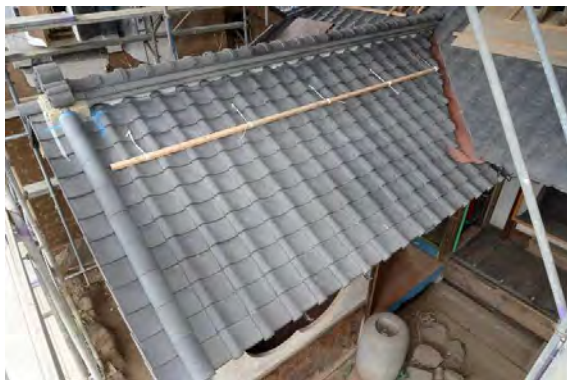
便組11 棧瓦葺完了
