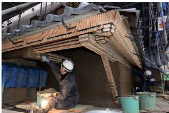
主組40 北東下屋揚げ裏荒壁付け状況
