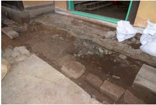
主組1 ワキゲンカン（踏込）敷石解体完了
