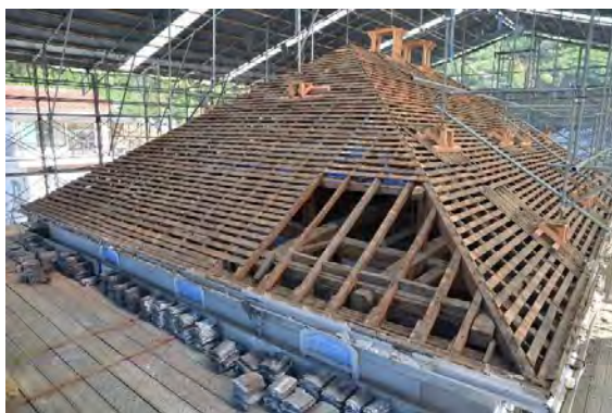
主解16 大屋根小舞野地状況、一部垂木状況
