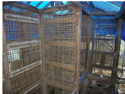
便解26 内部土壁揺き落とし状況
