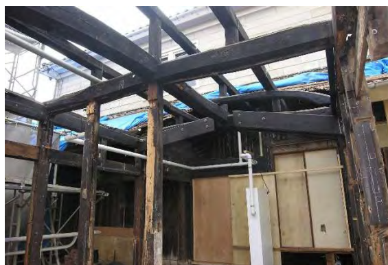
釜解14 小屋組状況 手前2本の間柱は後補（大正頃）。腐朽の著しい小屋梁は添え板で補強されていた。
