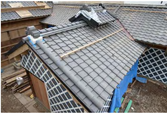
釜組8 棧瓦葺完了
