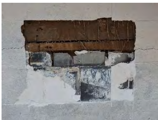
便解8 石積風浅目地入砂漆喰仕上下地調査 軸部の壁は海鼠瓦を塗り込め、妻上部は縄巻木摺下地に薄く 中塗りを行っていた。
