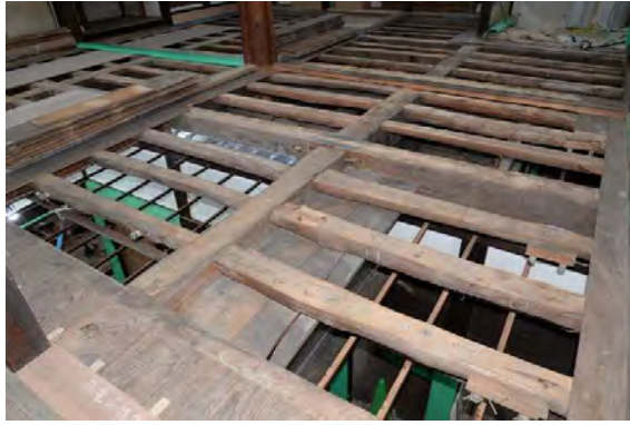
主解43 2階応接間床組状況 下階ヒロマの神棚上部にのみ二重天井が張られていた。
