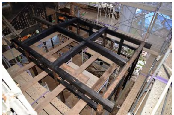
釜組3 軸部組立状況2
