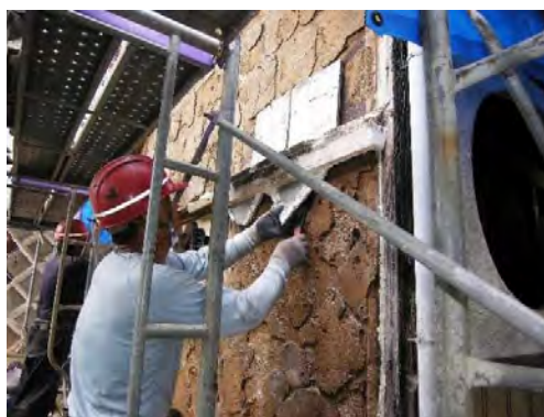
便解11 西面海鼠瓦解体状況
