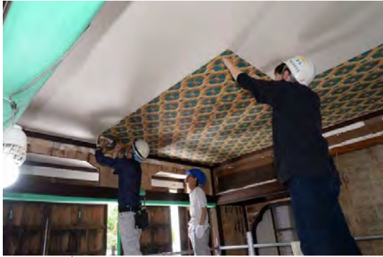
主組80 2階南西八畳間天井紙（模様印刷洋紙）上張り状況
