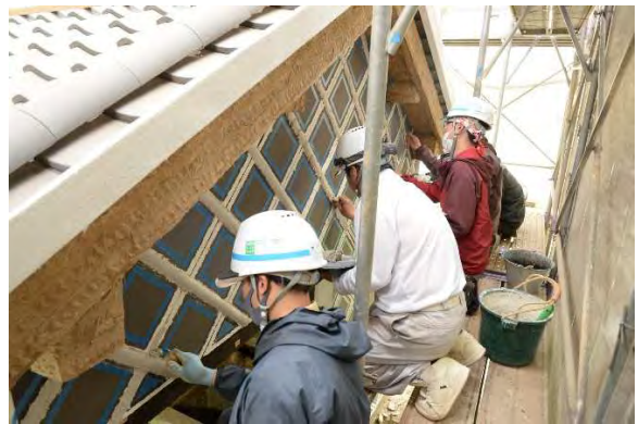
釜組13 海鼠目地施工状況
