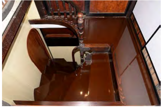
主組70 廻階段うるみ漆塗及びペンキ塗施工完了
