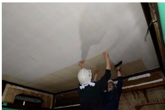
主組79 2階南西八畳間天井紙（模様印刷洋紙） 下張り状況
