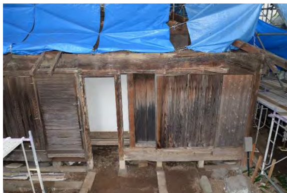
風組2 主屋主体部下屋西面南側現況
