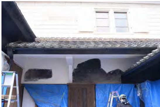
主組52 東下屋上塗り 補修状況（当初上塗り保存状況）
