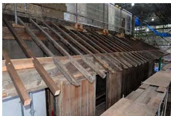
主組12 下屋根垂木組立完了
