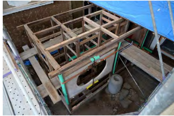
便組6 軸部組立状況
