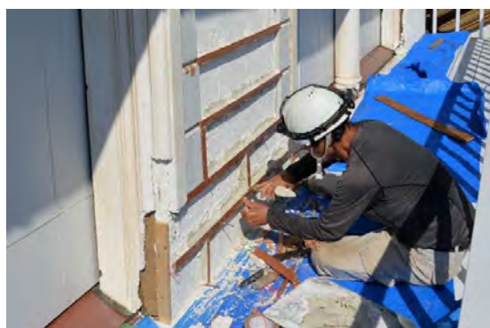
主組46 2階外壁南面擬石塗 目地棒取付状況
