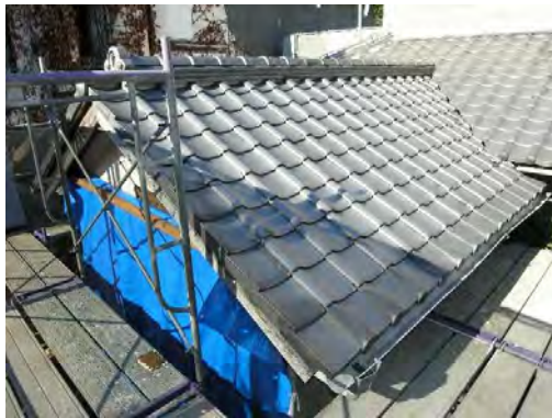
便解4 屋根現況
