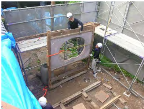
便解31 桃形剝抜窓大外し状況
