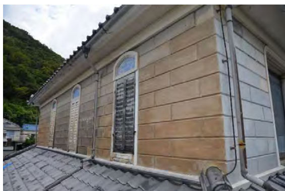
主解9 2階外壁現況（南西より見る）
