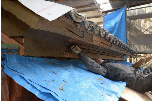
ミ組25 南面揚げ裏荒壁付状況
