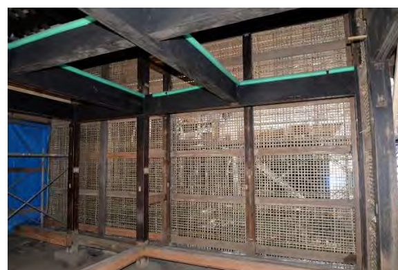
ミ組22 木舞掻き完了（北面 内部より見る）
