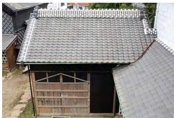
ミ組21 屋根漆喰施工完了（北面）
