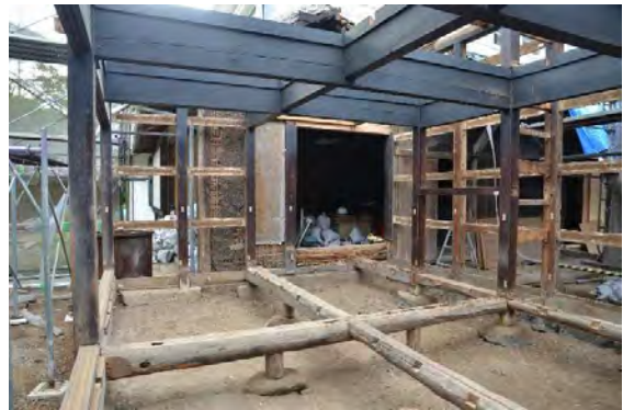
ミ解42 1階軸部解体状況（南東より見る）
