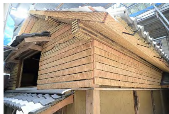
ミ組24 外壁縄巻木摺施工完了
