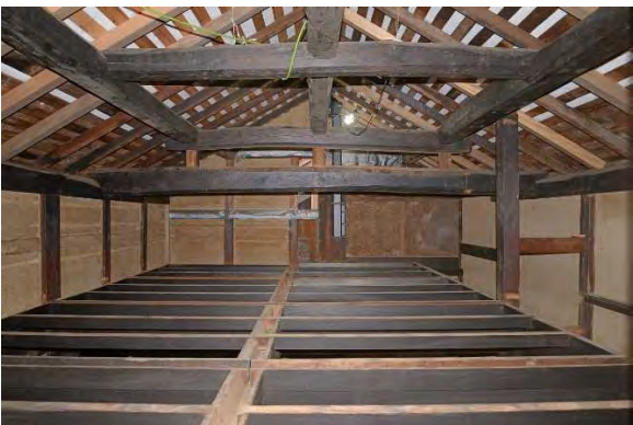
ミ組30 2階床組完了（東より見る）
