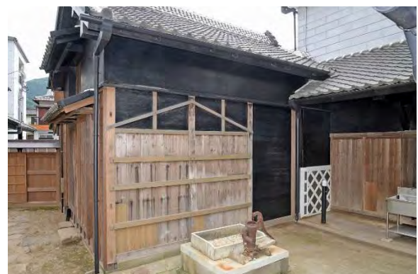
ミ組48 北面外壁造作完了（井戸屋根は復旧せず）
