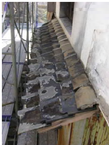
ミ解20 1階底現況 一部棧瓦の差し替えが見られた。
