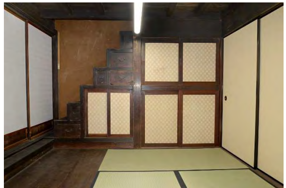
ミ組46 1階室内造作完了（南より見る）
