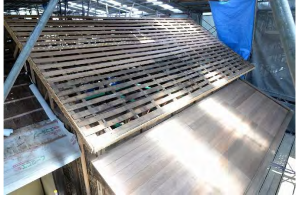
ミ組10 小舞野地及び野地板施工完了（南西より見る）
