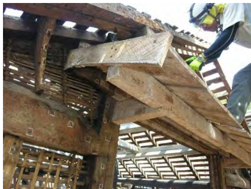
ミ解26 2階窓庇揚げ裏木下地
