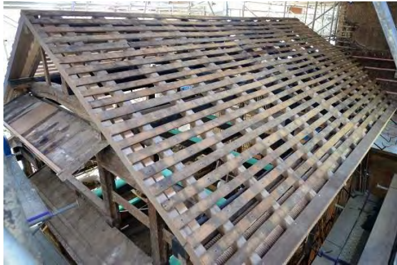
ミ組11 小舞野地施工完了（北東より見る）
