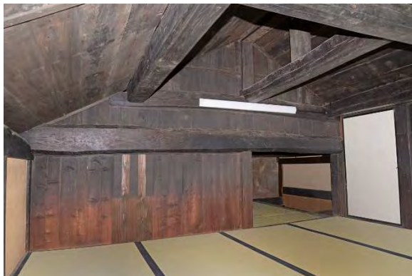
ミ組43 2階室内造作完了（南東より見る）
