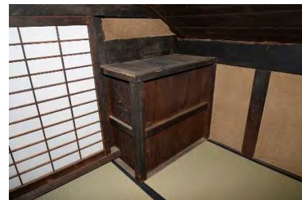
ミ組39 2階神棚上部復旧完了
