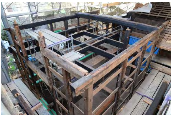
ミ組5 軸部組立状況3（北東より見る）
