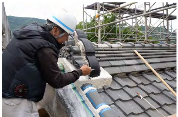
ミ組16 大棟東 影盛補修状況
