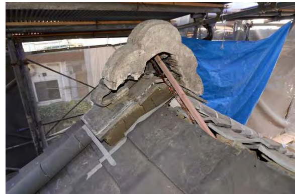
ミ組14 大棟東 鬼瓦・影盛復旧状況 同左
