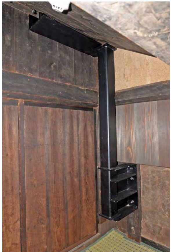
ミ組44 構造補強鉄骨設置完了 主屋構造柱とミセ棟木を緊結した。
