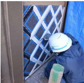
ミ組37 北面海鼠目地施工状況 在来の仕様に倣い、中塗りに 黒漆喰を使用した。
