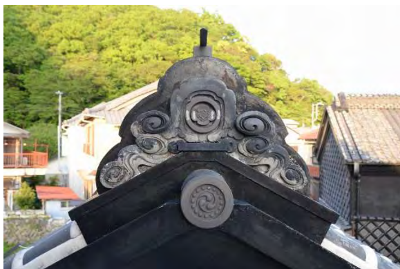
ミ組17 大棟西 影盛、鬼台、黒漆喰巻施工完了
