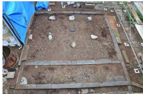
ミ解50 軸部解体完了（南より見る） 下屋南東隅皿戸袋下のみ当初の土間叩きが残っていた。
