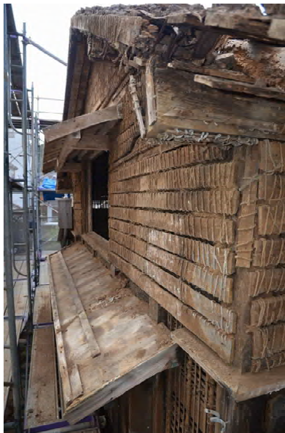
ミ解28 外壁漆喰壁解体完了
