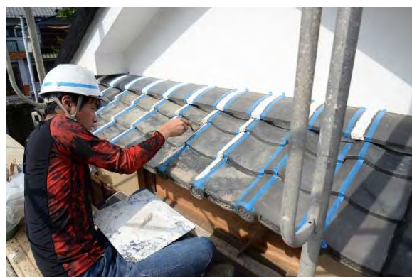
ミ組19 2階窓庇棒漆喰施工状況 土蔵を含め、窓庇のみ平葺の棒漆喰を復旧した。
