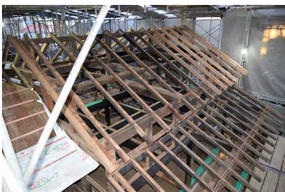
ミ組8 垂木組立状況（南西より見る）
