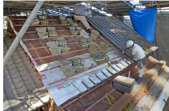
ミ組12 棧瓦葺施工状況（北東より見る）
