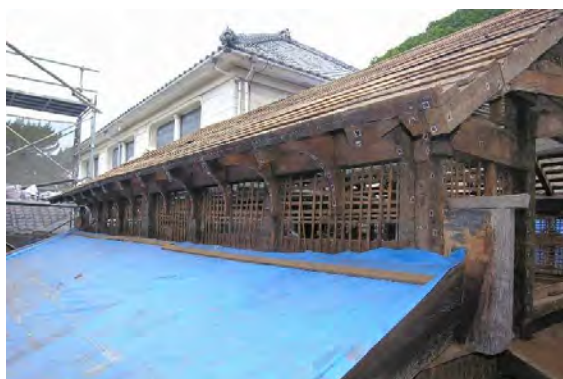
ミ解27 南面揚げ裏縄巻木摺解体完了
