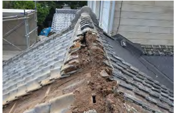
ミ解11 大棟解体トレンチ（東より見る）
