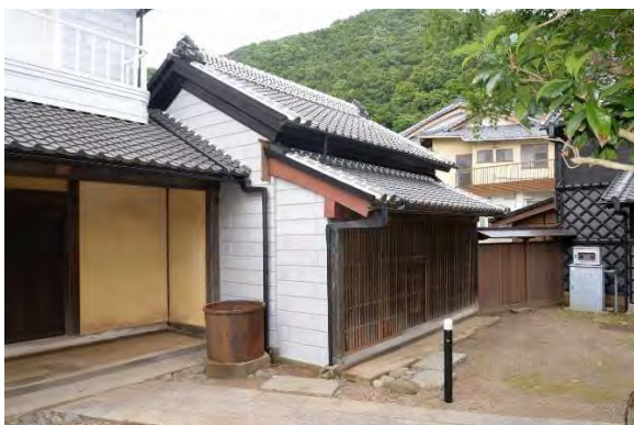
ミ組47 樋工事完了（南西より見る）
