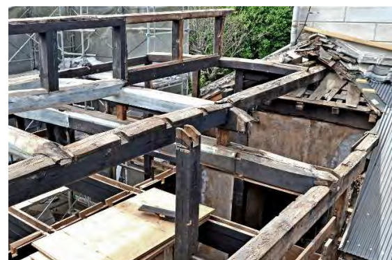
ミ解39 主屋・ミセ接続部状況（小屋組） 昭和に2階小屋材の一部に白ペンキが塗られた。
