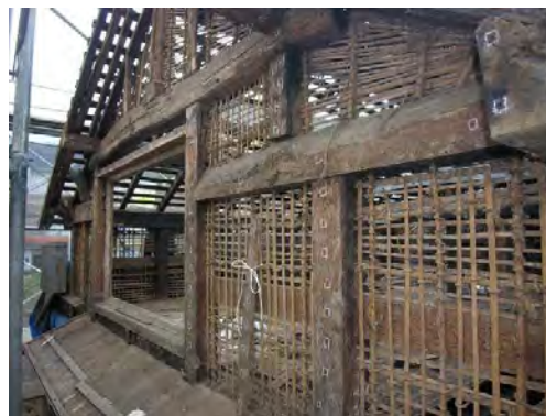
ミ解30 東面2階外壁縄巻木摺解体完了
