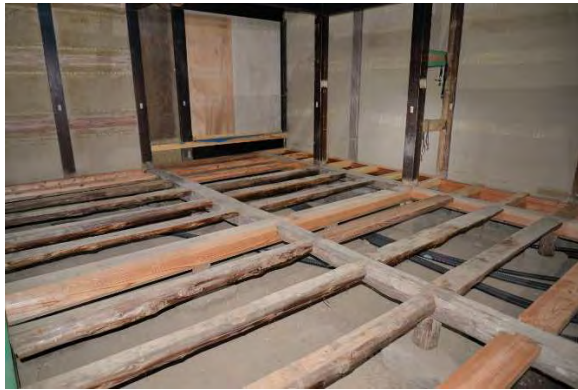
ミ組28 1階床組完了（南東より見る）
