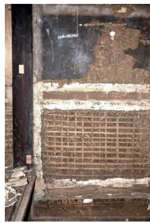
ミ解22 内部漆喰壁解体状況 当初は中塗仕上げ
