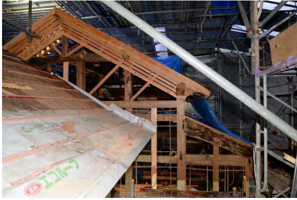
ミ組9 軸部・小屋組組立完了（西より見る）
