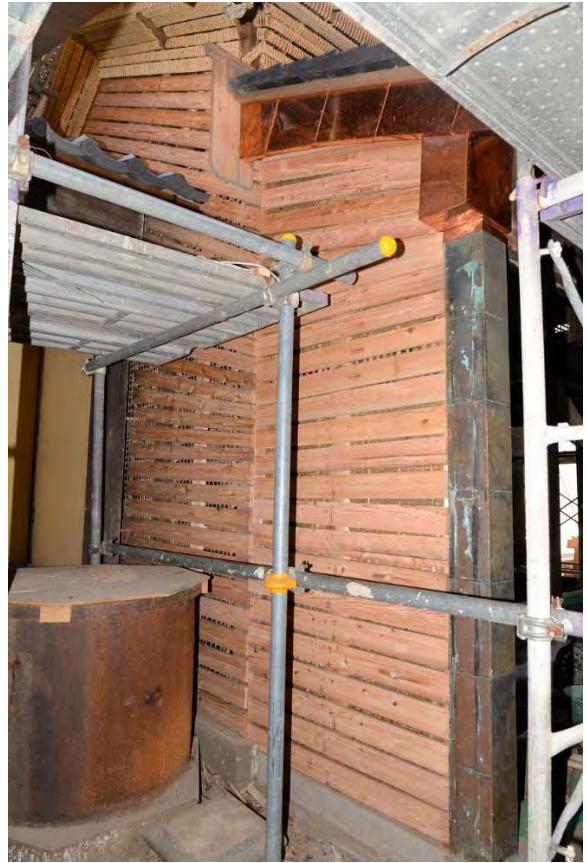
ミ組27 西面外壁擬石塗 木摺下地施工完了 強度ともちを考慮して後補仕様である木摺下地を今回も踏襲した。
