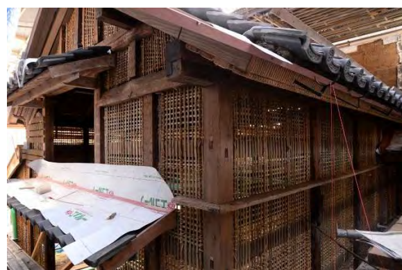
ミ組23 木舞掻き完了（東・北面 外部より見る）
