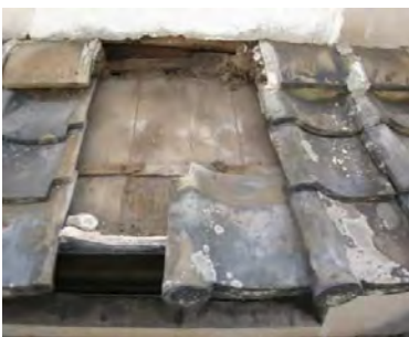
ミ解23 2階底棧瓦葺解体状況
