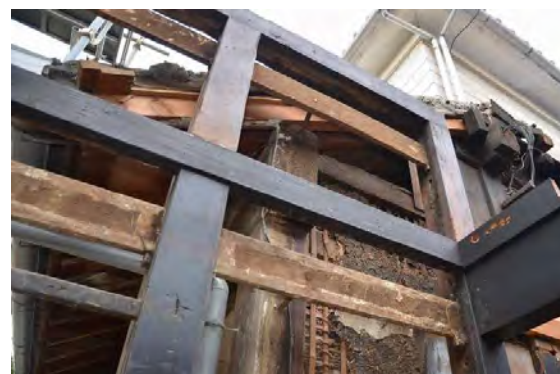
ミ解40 主屋・ミセ接続部状況（南半軸部） ミセ南半は主屋と別に柱通りを設け、主屋柱とミセ貫を丸込栓止めとしていた。
