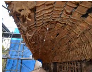
ミ解25 南面揚げ裏縄巻木摺下地
