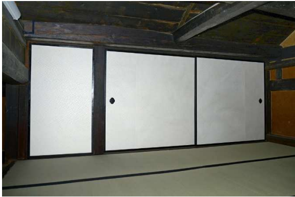
ミ組42 2階北面押入襖（泰平紙張）修理完了
