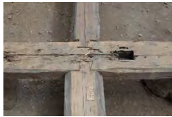
ミ解44 1階大引き継手詳細
