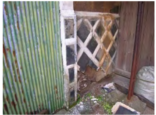
ミ解3 外観海鼠壁現況（北面）
