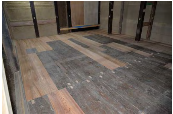
ミ組29 1階床板組立完了（南東より見る）
