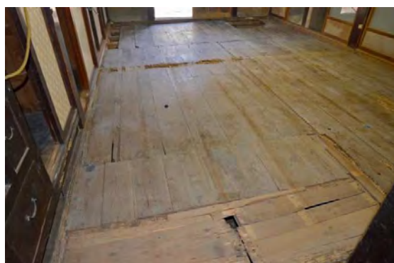
ミ解31 1階後補床板解体完了、当初荒床板状況
