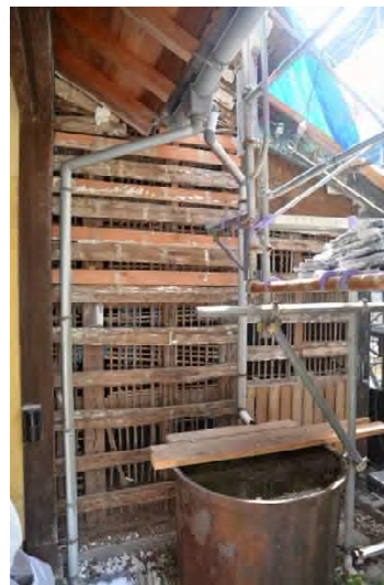
ミ解47 西面擬石塗下地状況 当初は木摺下地ではない。下地も3回分の補修が確認できる。
