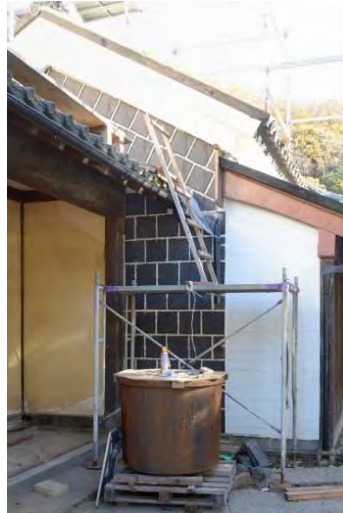
ミ組33 西面擬石塗下地海鼠瓦施工状況
