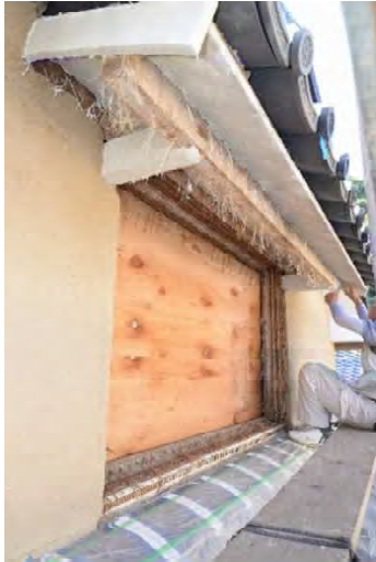
ミ組32 2階窓庇揚げ裏施工状況
