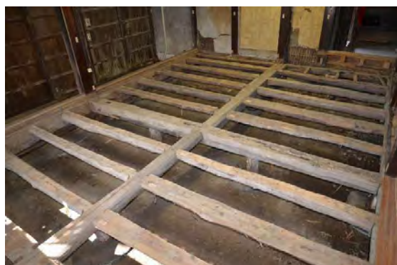
ミ解32 1階床組状況（北東より見る）
