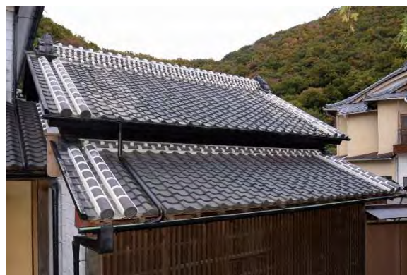
ミ組20 屋根漆喰施工完了（南面）
