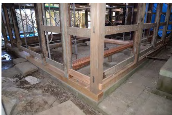
ミ組3 軸部組立状況1（北東より見る）
