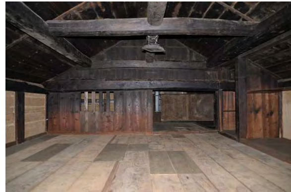
ミ組31 2階床板及び板壁組立完了（東より見る）
