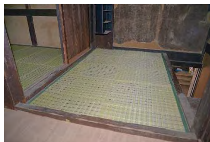
ミ組38 2階花御座設置完了
