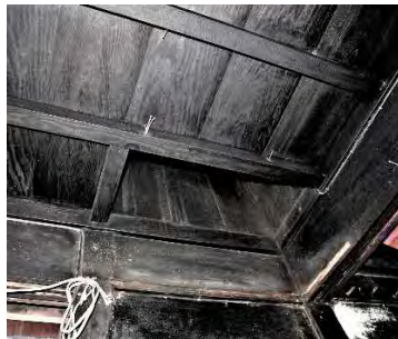
ミ解24 主体部1階南東隅天井廻り 神棚板のものと考えられる決り溝が 差鴨居などに残っていた。
