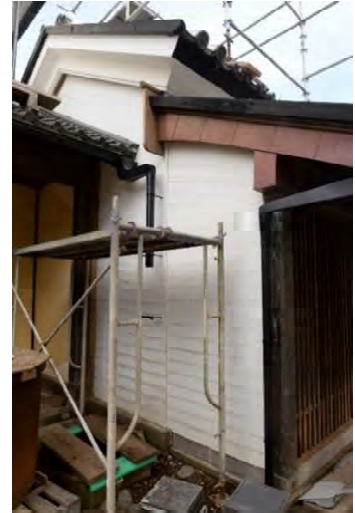
ミ組34 西面擬石塗下塗完了
