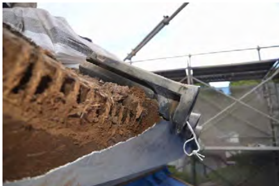
ミ解12 大屋根軒先解体状況
