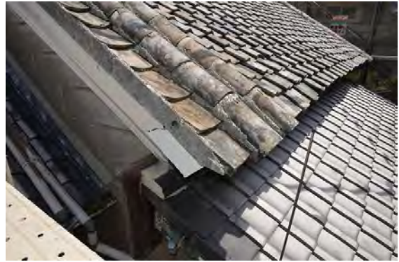
ミ解9 大屋根軒先現況（南西より見る）
