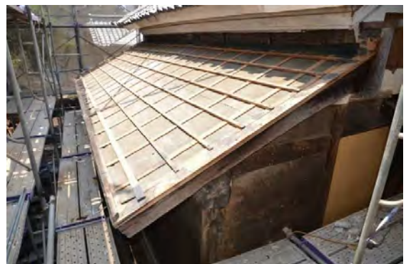
ミ解15 下屋下地状況 野地板からは全て後補材（平成）
