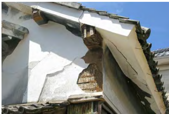
ミ解4 南面外壁及び北面揚げ裏現況 左官部分補修が入っていたが、所々当初の黒ノロ仕上げが残っていた。
