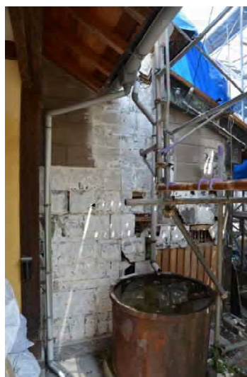
ミ解46 西面擬石塗解体完了 雨仕舞の悪い箇所、後世3回の補修が入っていた。
