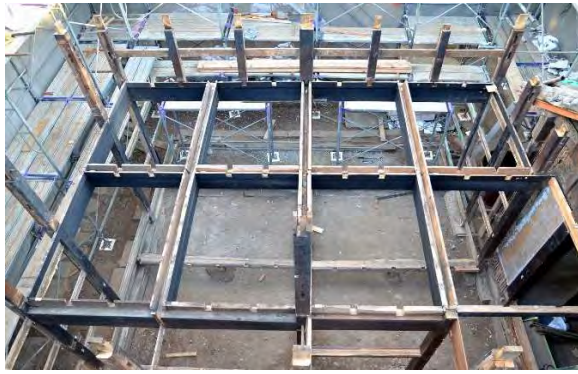
ミ解41 小屋組解体完了（北より見る）
