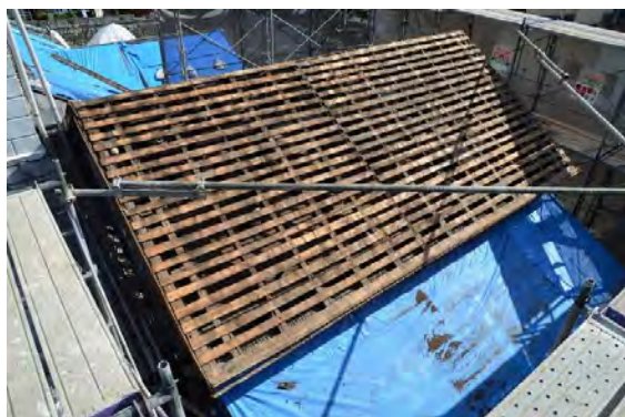
ミ解16 大屋根小舞野地状況（南西より見る）
