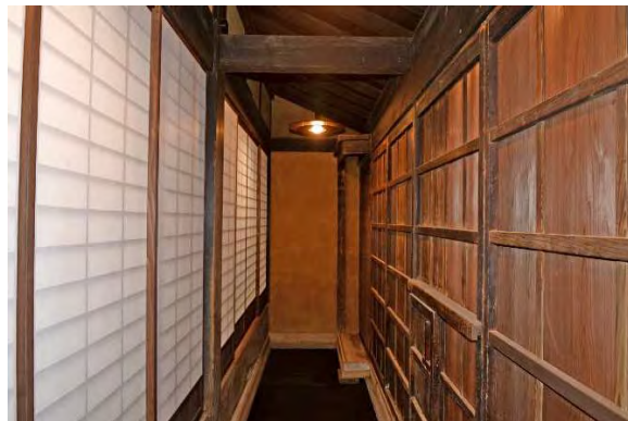
ミ組45 下屋建具復旧完了（西より見る）
