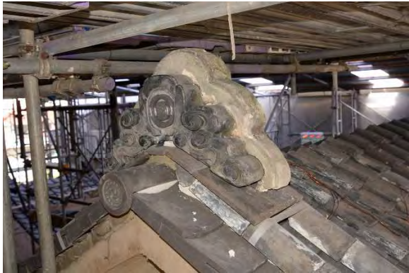
ミ組13 大棟西 鬼瓦・影盛復旧状況 影盛は補修再用とした。
