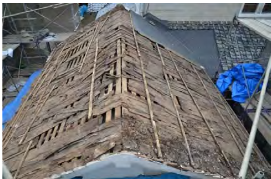
ミ解14 大屋根下地状況
