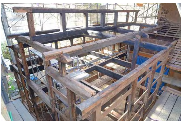
ミ組7 小屋組組立状況（北東より見る）
