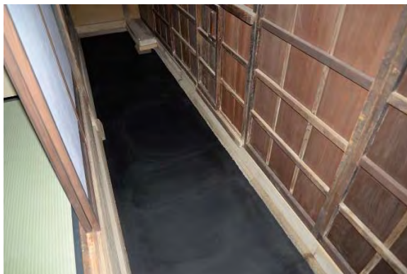
ミ組2 下屋叩き施工完了 残存していた当初仕上げを参考に黒漆喰塗で仕上げた。
