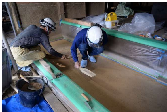
ミ組1 下屋叩き施工状況
