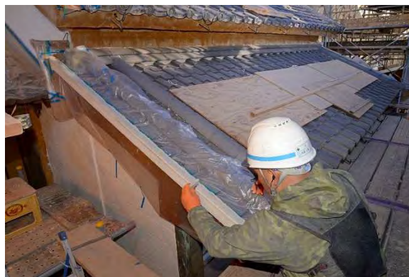
ミ組18 下屋黒漆喰袖巻施工状況
