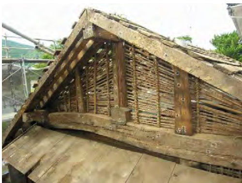
ミ解29 東面妻外壁左官解体完了
