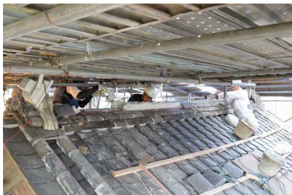
ミ組15 大棟積施工状況
