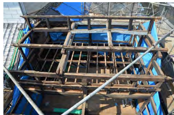
ミ解37 小屋組解体状況
