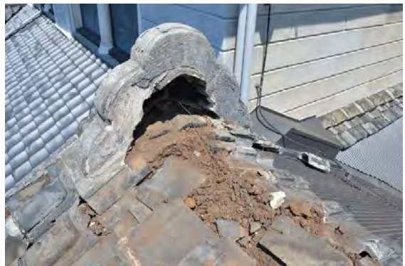
ミ解13 大棟解体完了、西側影盛状況
