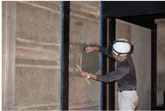
ミ組26 内部貫伏施工状況（当初なし、今回部分補強）
