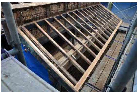
ミ解18 下屋根垂木状況（南西より見る） 垂木は1本を除き当初のものが残っていた。
