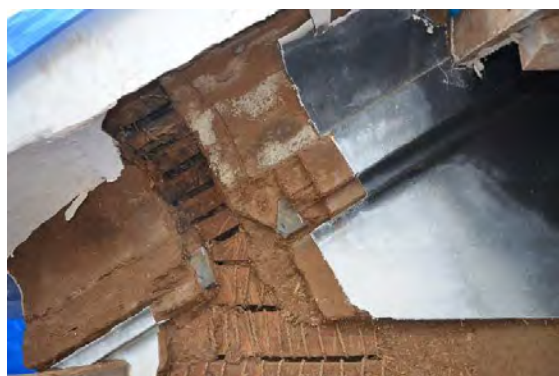
ミ解19 東面軒揚げ裏～外壁解体トレンチ
