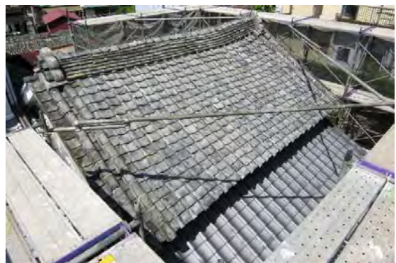
ミ解5 大屋根現況（南西より見る）
