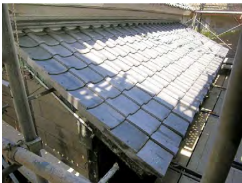
ミ解6 下屋屋根現況 棧瓦は全て後補材（平成）
