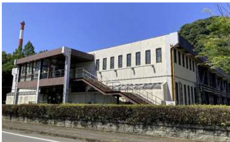
図1-8 旧屋内温水プール
