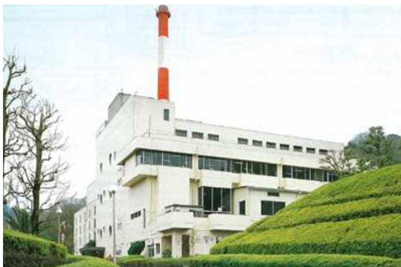
図1-1 現清掃プラント
