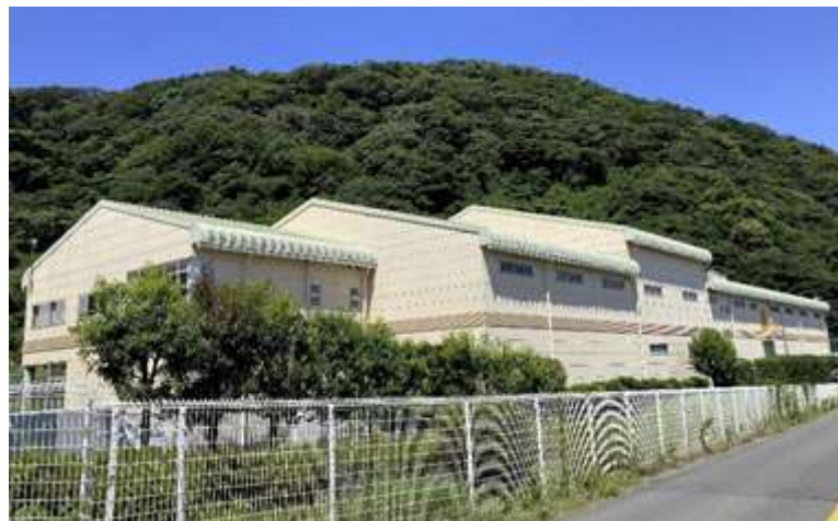
図1-5 中継・中間処理施設
