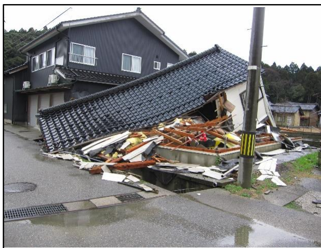
能登半島地震における耐震性のない家屋の崩壊状況
