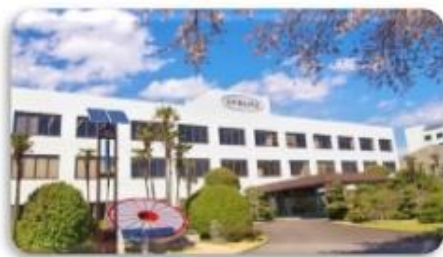
沼津本社 本館
