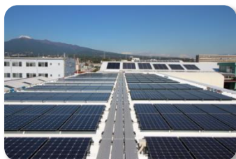
国内最大級の「太陽光発電 比較展示場」が見学できます。
