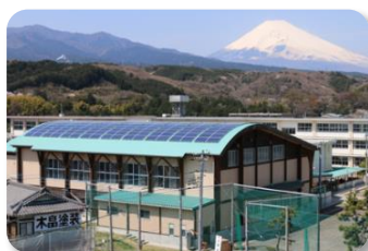
近隣の裾野市教育施設で「屋根貸し太陽光発電事業」を行っています。
