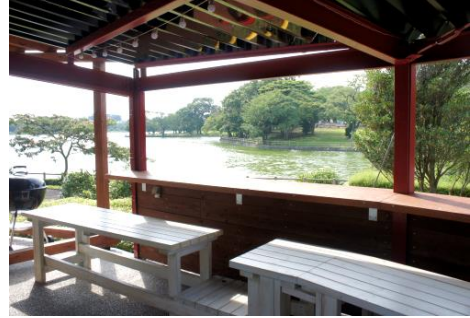
水辺の建築物のファサード改修
