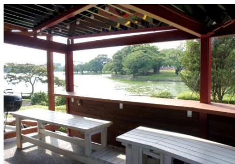
水辺の建築物のファサード改修
