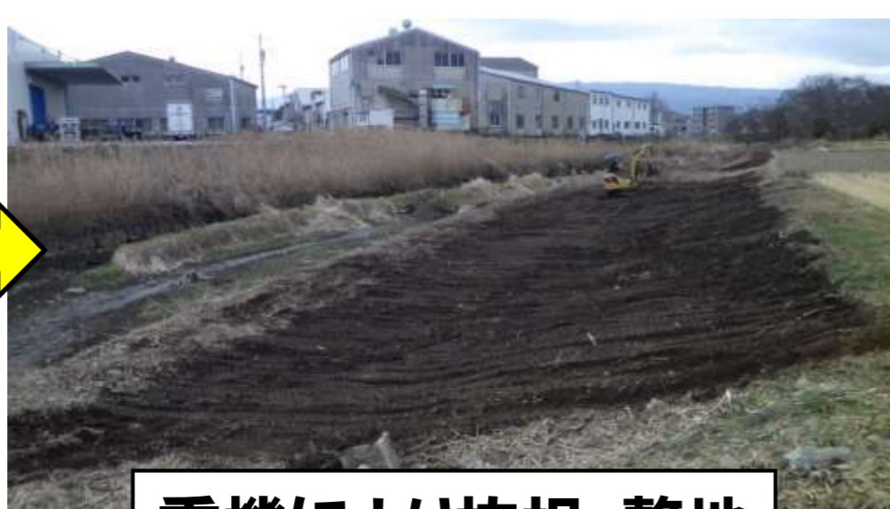
重機により抜根・整地
