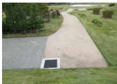
史跡大友氏館跡 洗い出しポーラスコ ンクリート舗装と土系舗装 大分県大分市
