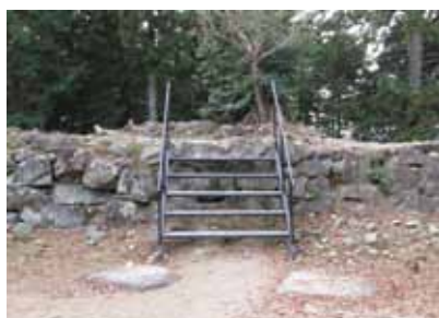
特別史跡安土城 遺構保護のための鉄 製階段 滋賀県近江八幡市
