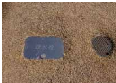
史跡甲府城跡 散水栓・止水弁 山梨県甲府市
