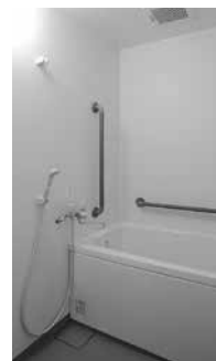
▲ユニバーサルデザインに配慮した浴室の整備（八重団地）
