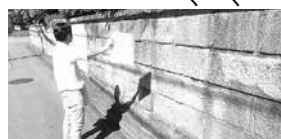
▲職員によるブロック塀点検
