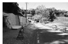
▲道路拡幅工事などが行われている 県道沼津土肥線
