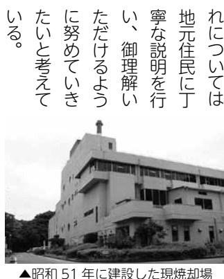
▲昭和 51 年に建設した現焼却場
