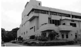
▲昭和51年に建設した現焼却場
