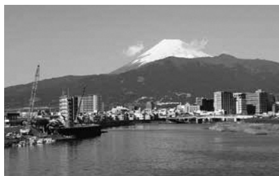
▲下河原地区の狩野川堤防工事
