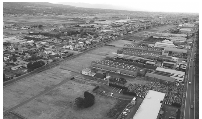
▲新貨物ターミナル建設予定地
