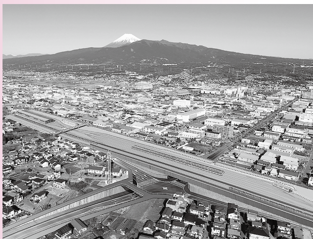
▲鉄道施設移転先の整備を進めます (新車両基地完成イメージ)
