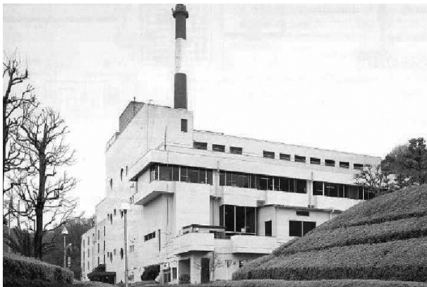
▲昭和51年に建築された現在の清掃プラント（ごみ焼却施設）
